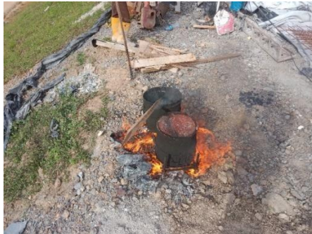
Gambar 4. 20 Pekerjaan pembakaran cairan aspal
