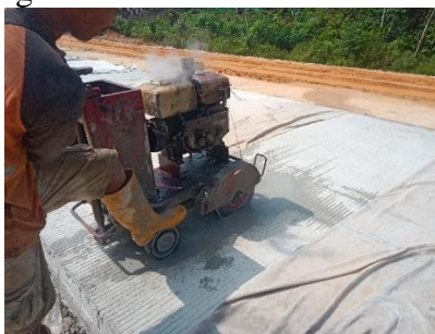
Gambar 4. 19 Pekerjaan cutting Sumber : Dokumentasi Kerja Praktek 2023
