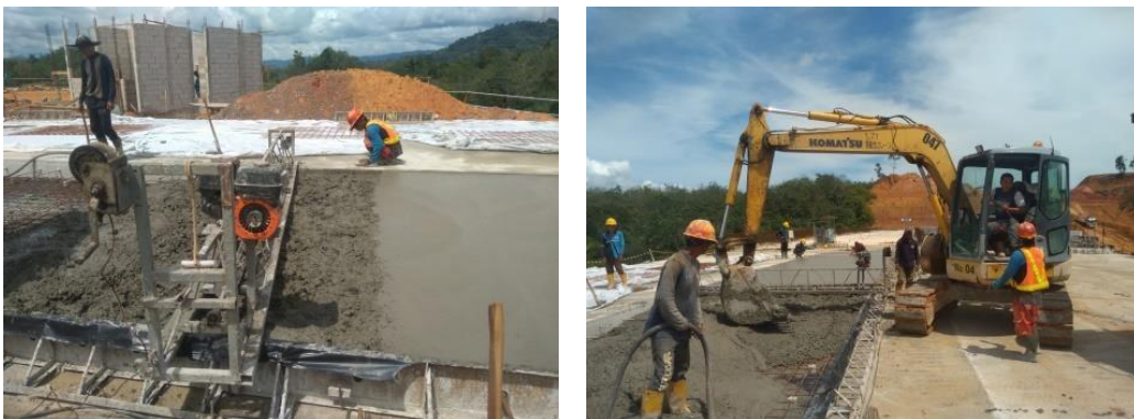
Gambar 3. 22 Proses Pekerjaan Rigid
