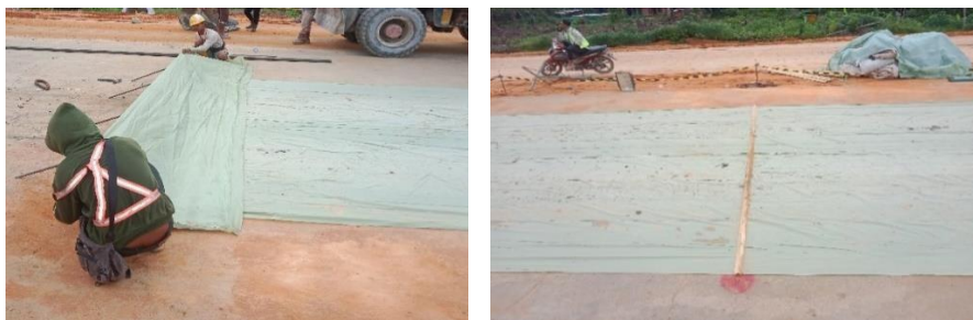
Gambar 4. 2 Pemasagn Plastik Cor Sumber : Dokumentasi Kerja Praktek 2023
