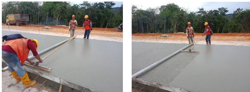
Gambar 4. 17 Pembuatan Alur Grooving Sumber : Dokumentasi Kerja Praktek 2023
