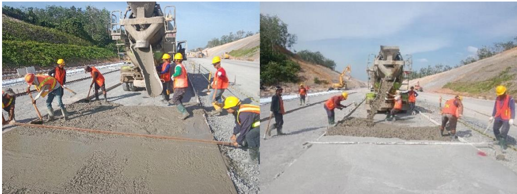
Gambar 3. 21 Pekerjaan Pengecoran Lean Concrete
