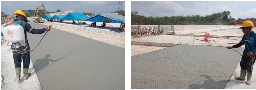
Gambar 4. 18 Penyemprotan Antisol Sumber : Dokumentasi Kerja Praktek 2023
