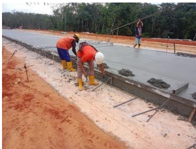
Gambar 4. 16 Pemasangan besi tie bar Sumber : Dokumentasi Kerja Praktek 2023
