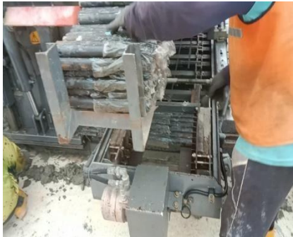
Gambar 4. 12 Proses memasukkan besi dowel
