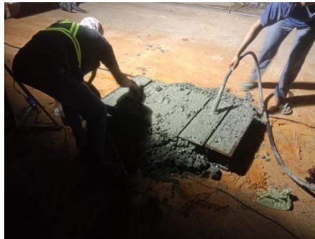
Gambar 4. 7 Pembuatan Sampel Uji Sumber : Dokumentasi Kerja Praktek 2023
