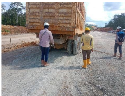
Gambar 3. 5 Pengujian Proofrolling Sumber : Dokumentasi Kerja Praktek 2023
