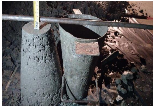
Gambar 4. 6 Pengujian Slump Sumber : Dokumentasi Kerja Praktek 2023
