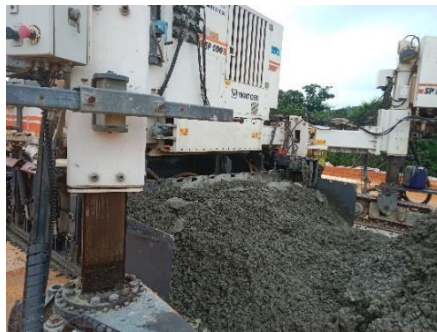
Gambar 4. 10 Auger memasukan campuran beton Sumber : Dokumentasi Kerja Praktek 2023
