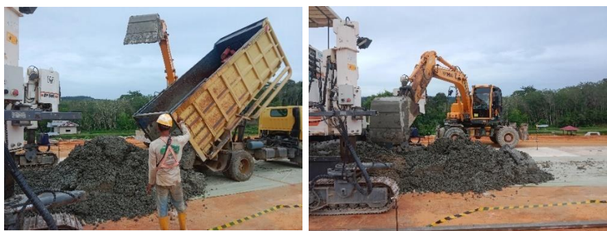
Gambar 4. 9 Penghamparan Material Sumber : Dokumentasi Kerja Praktek 2023
