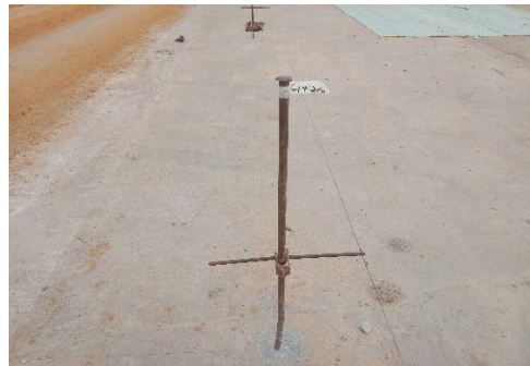
Gambar 4. 1 Pemasangan Stringline Sumber : Dokumentasi Kerja Praktek 2023
