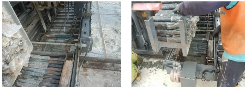
Gambar 4. 15 Pemasangan besi dowel Sumber : Dokumentasi Kerja Praktek 2023
