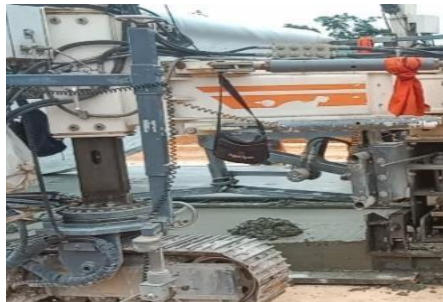
Gambar 4. 13 Super smoother meghaluskan permukaan beton
