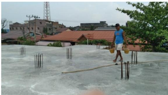
Gambar3.19 Proses Pemeliharaan pada Dak Lantai
