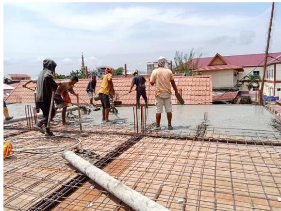
Gambar3.17 Pengecoran Plat Lantai
