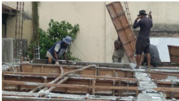
Gambar3.5 Pembongkaran Bekisting Sloof
