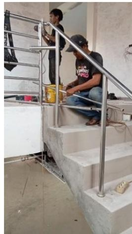
Gambar3.39 Pemasangan *Railing* Besi pada Tangga
