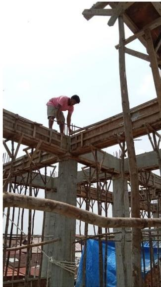
Gambar3.25 Pembongkaran Bekisting Ring Balok
