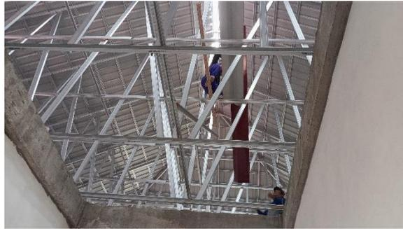
Gambar3.33 Pekerjaan Penutup Atap
