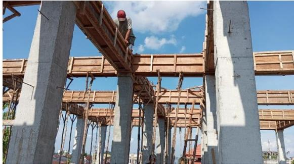
Gambar3.23 Pemasangan Bekisting Ring Balok
