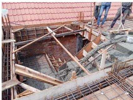
Gambar3.21 Proses Pengecoran Tangga
