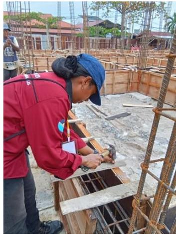
Gambar3.3 Pekerjaan Perakitan Bekisting Sloof
