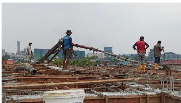
Gambar3.24 Proses Pengecoran Ring Balok
