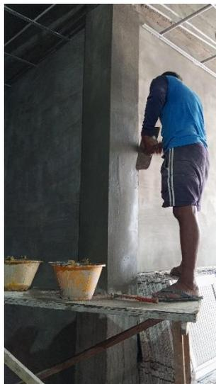
Gambar3.29 Pekerjaan Acian pad Kolom
