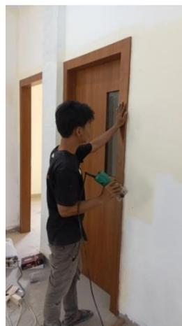
Gambar3.34 Proses Pekerjaan Pemasangan Pintu
