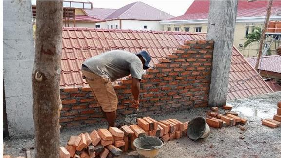
Gambar3.28 Pemasangan Bata dinding
