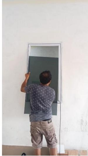
Gambar3.35 Pekerjaan Pemasangan Kaca jendela
