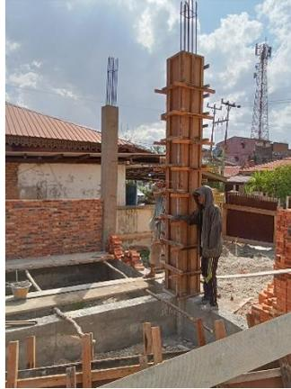
Gambar3.9 Pembongkaran Beksiting Kolom
