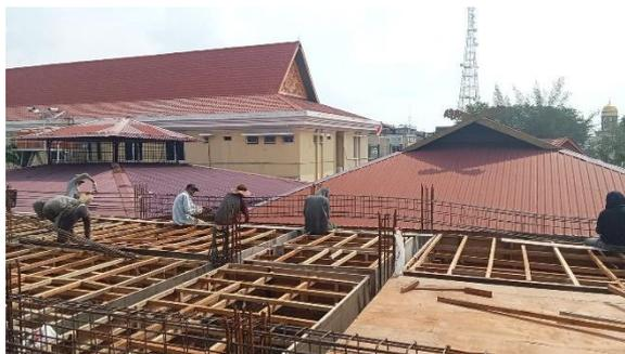
Gambar3.15 Perakitan bekisting pada Dak Lantai
