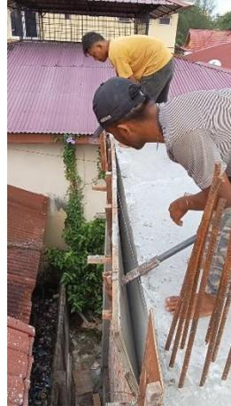
Gambar3.14 Pembongkaran Bekisting Balok Bordes
