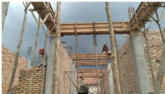
Gambar3.12 Pemasangan Bekisting Balok Bordes
