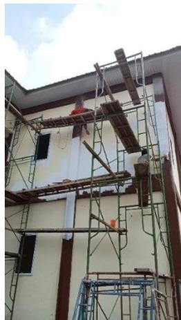
Gambar3.32 Pekerjaan Pengecatan
