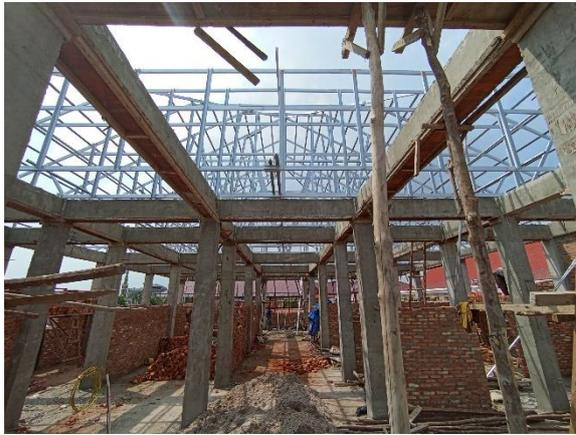
Gambar3.27 Pemasangan Kuda-kuda Atap Baja Ringan
