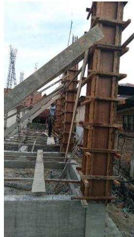
Gambar3.7 Pemasangan Beksiting Kolom
