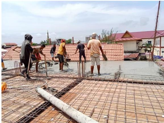
Gambar3.13 Pengecoran Balok Bordes
