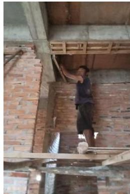
Gambar3.18 Pembongkaran Bekisting Dak Lantai
