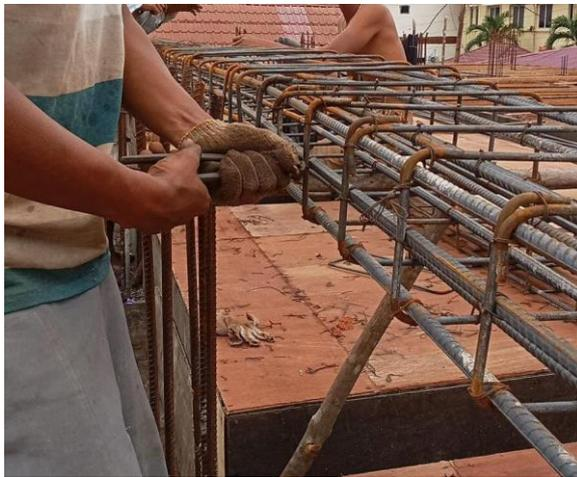
Gambar3.11 Perakitan Tulangan Besi untuk Balok Bordes
