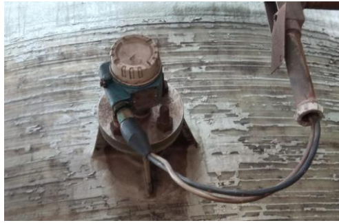
Gambar 2.5 Tuning Fork Level Switch (Sumber : Dokumentasi penulis,2023)
