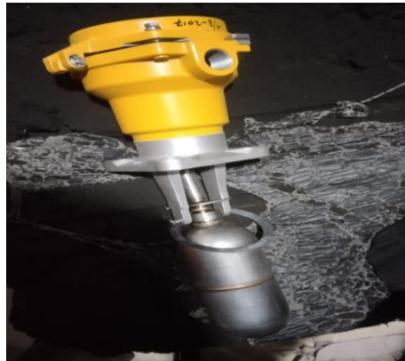
Gambar 3.3 Float switches sensor (Sumber : Dokumentasi penulis,2023)
