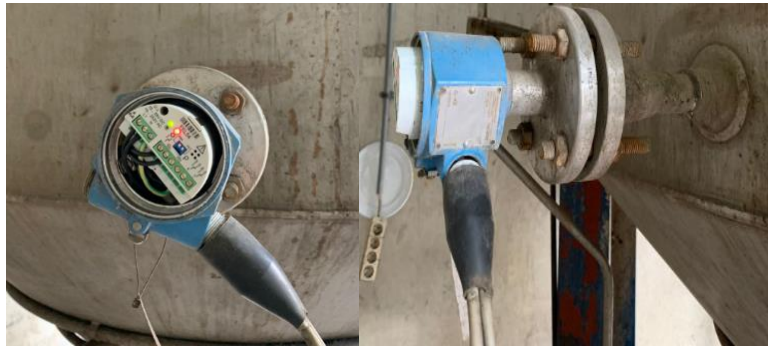
Gambar 3.1 Tuning fork level switch (Sumber : Dokumentasi Penulis,2023)
