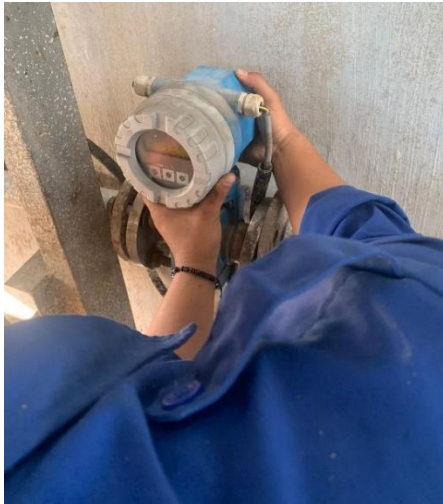
Gambar 2.3 Flowmeter Equalitation (Sumber : Dokumentasi penulis,2023)
