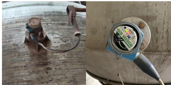
Gambar 3.4 tuning fork level switch (Sumber : Dokumentasi penulis,2023)
