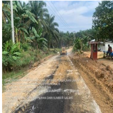
Gambar 3.14 eksisting jalan di proyek Sumber : Dokumentasi lapangan 2023
