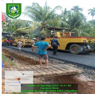
Gambar 3.7 Pengaspalan AC-BC
