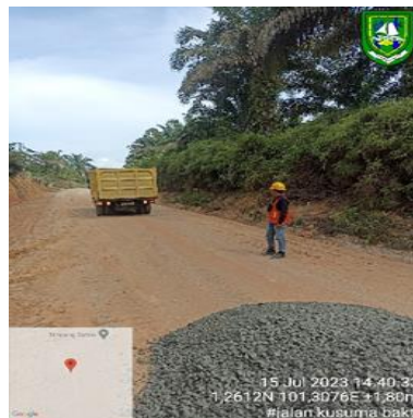
Gambar 3.15 penghamparan base A Sumber : Dokumentasi lapangan 2023
