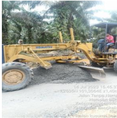
Gambar 3.3 Penghamparan Base Kelas A Menggunakan Motor Grader
