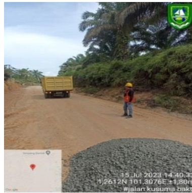
Gambar 3.2 Penumpukan Base Kelas A
