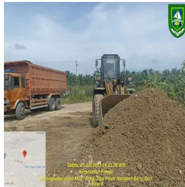
Gambar 3.1 Penghamparan dan pepadatan tanah timbunan
