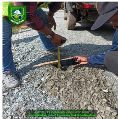
Gambar 3.4 core base dan pengukuran base A
