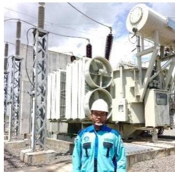
Gambar 2. 3 Survey Lapangan Gardu Induk 150 KV Sumber: (Dokumentasi, 2023)
