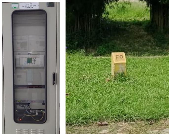
Gambar 2. 11 Survey Kabel Fiber Optic (Sumber : Dokumentasi, 2023)
