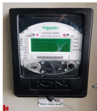
Gambar 3. 14 Metering ION 8650 (Sumber : Dokumentasi, 2023)
