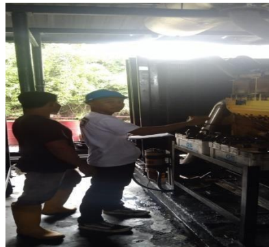
Gambar 2.45 Kegiatan monitoring KWh setiap jamnya (Sumber: PT. Megapower Makmur Tbk, 2023)
