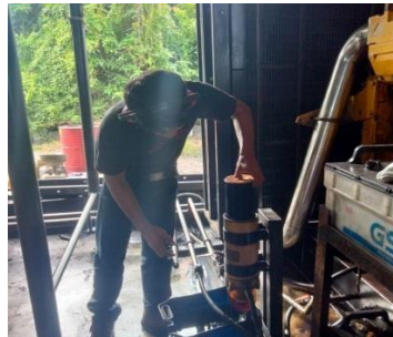
Gambar 2.23 Kegiatan pengantian filter oli dan filter (Sumber: PT. Megapower Makmur Tbk, 2023)
