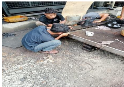
Gambar 2.32 kegiatan yaitu pembersihan radiator (Sumber: PT. Megapower Makmur Tbk, 2023)
