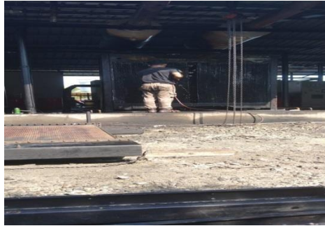
Gambar 2.19 Kegiatan pembersihan radiator unit 3 (Sumber: PT. Megapower Makmur Tbk, 2023)
