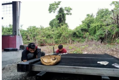
Gambar 2.35 kegiatan pemindahan radiator (Sumber: PT. Megapower Makmur Tbk, 2023)
