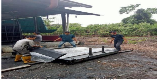
Gambar 2.37 kegiatan pembersihan radiator (Sumber: PT. Megapower Makmur Tbk, 2023)
