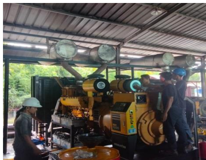
Gambar 2.18 Kegiatan penggantian oli unit lima (Sumber: PT. Megapower Makmur Tbk, 2023)
