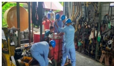
Gambar 2.1 Pembersihan Limbah Mesin PLTD (Sumber: PT. Megapower Makmur Tbk, 2023)
