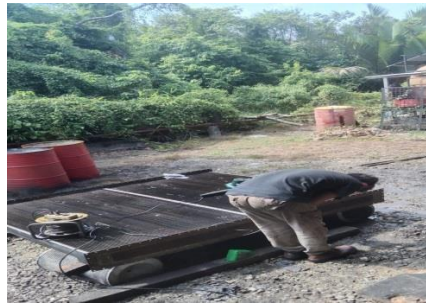
Gambar 2.26 kegiatan pembersihan radiator (Sumber: PT. Megapower Makmur Tbk, 2023)
