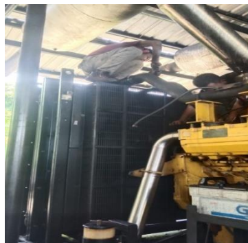
Gambar 2.27 kegiatan penggantian radiator unit tiga (Sumber: PT. Megapower Makmur Tbk, 2023)
