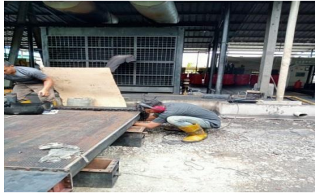
Gambar 2.43 kegiatan yaitu penggantian radiator (Sumber: PT. Megapower Makmur Tbk, 2023)
