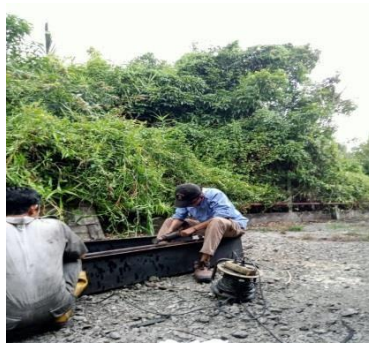
Gambar 2.47 Kegiatan pembersihan radiator (Sumber: PT. Megapower Makmur Tbk, 2023)
