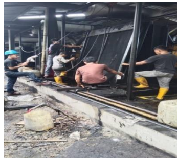
Gambar 2.6 Kegiatan Penggantian radiator unit 7 (Sumber: PT. Megapower Makmur Tbk, 2023)
