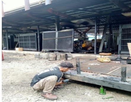
Gambar 2.8 Kegiatan pemindahan radiator (Sumber: PT. Megapower Makmur Tbk, 2023)
