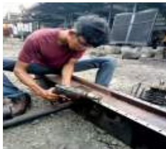
Gambar 2.47 Kegiatan pembersihan radiator (Sumber: PT. Megapower Makmur Tbk, 2023)
