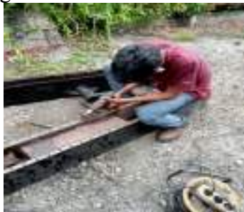
Gambar 2.26 kegiatan pembersihan radiator (Sumber: PT. Megapower Makmur Tbk, 2023)
