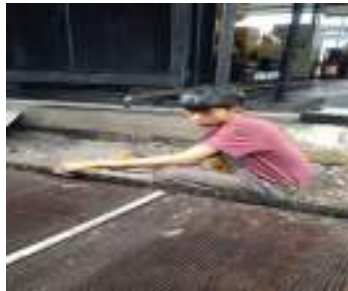
Gambar 2.31 kegiatan yaitu pembersihan radiator (Sumber: PT. Megapower Makmur Tbk, 2023)
