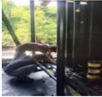
Gambar 2.27 kegiatan penggantian radiator unit tiga (Sumber: PT. Megapower Makmur Tbk, 2023)
