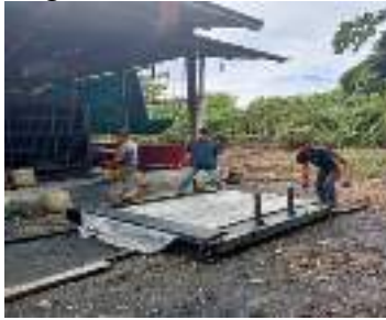
Gambar 2.36 kegiatan penggantian radiator unit 8 (Sumber: PT. Megapower Makmur Tbk, 2023)
