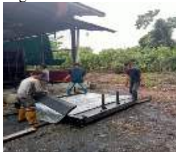
Gambar 2.35 kegiatan pemindahan radiator (Sumber: PT. Megapower Makmur Tbk, 2023)
