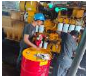
Gambar 2.7 Kegiatan penggantian oli mesin (Sumber: PT. Megapower Makmur Tbk, 2023)
