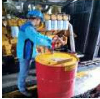
Gambar 2.18 Kegiatan penggantian oli unit lima (Sumber: PT. Megapower Makmur Tbk, 2023)
