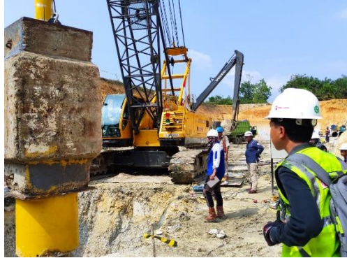
Gambar 3. 11 Meninjau pekerjaan PDA test
