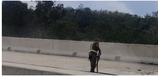
Gambar 4.1 Pembersihan lahan dengan kompresor
