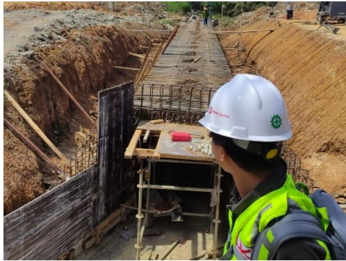
Gambar 3.2 Meninjau pembesian pada Box Culvert sta 54+000
