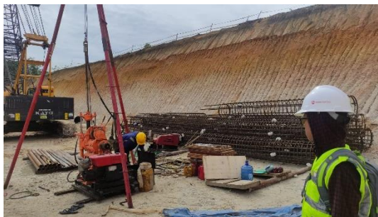
Gambar 3.7 Pengujian bor log SPT
