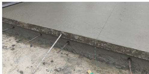
Gambar 4.12 Pekerjaan pemasangan tie bar
