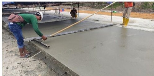
Gambar 4.14 Pekerjaan pemasangan tie bar
