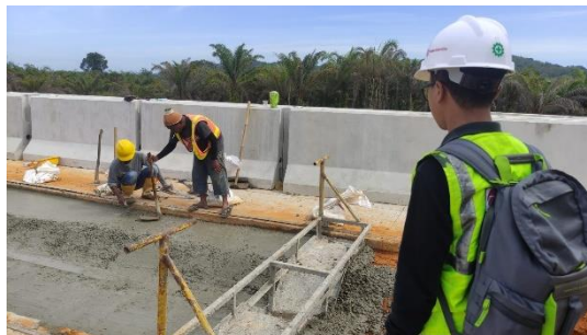
Gambar 3.6 Meninjau pekerjaan DSV
