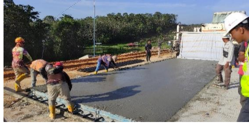
Gambar 4. 13 Pekerjaan pemasangan tie bar
