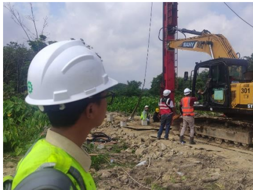
Gambar 3. 10 Meninjau pekerjaan minipile
