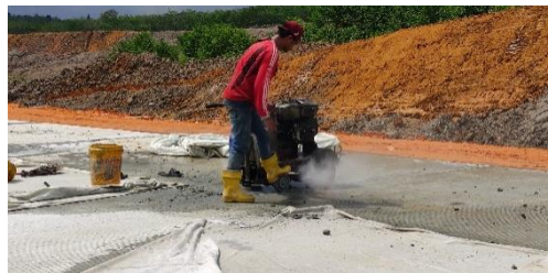
Gambar 4.16 Pekerjaan cutting
