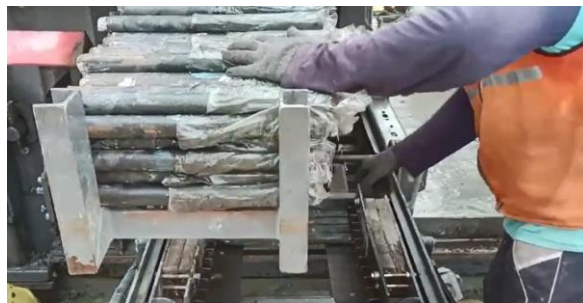
Gambar 4.2 Persiapan Dowel DBI pada alat Wirtgen SP 500
