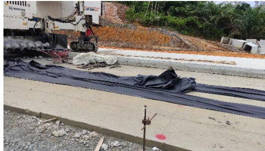
Gambar 4.4 Pemasangan Plastik Cor
