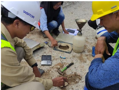
Gambar 3.3 Pengujian sand cone pada STA 56+650
