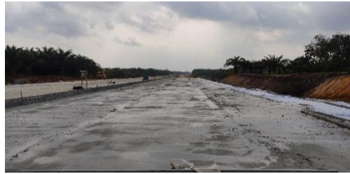
Gambar 4.15 Pekerjaan curing
