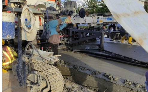
Gambar 4.11 Pekerjaan pemadatan beton
