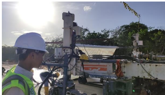
Gambar 3.8 Meninjau pengecoran menggunakan alat Wirtgen SP 500
