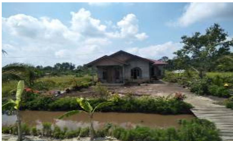
Gambar 1.2 Kondisi drainase pada saat musim penghujan, 26 Januari 2020
