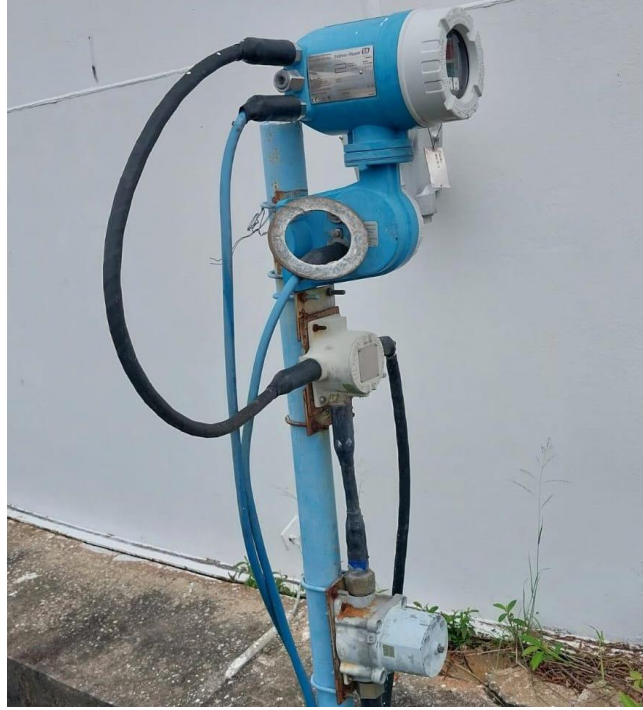
Gambar 3.16 Tank Side Monitor (Sumber : Dokumentasi pribadi)
