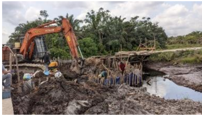
Gambar 3. 1 Pembendungan (Sumber : Dokumentasi Lapangan)
