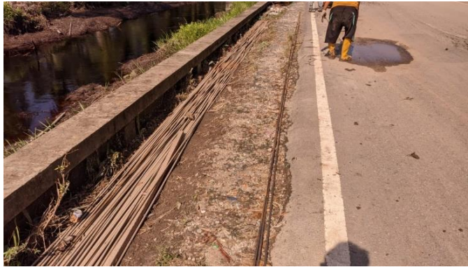
Gambar 3. 7 Proses Pabrikasi Besi Untuk Lantai Beton (sumber : Dokumentasi Lapangan)
