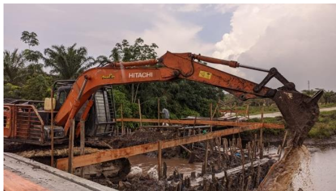
Gambar 4. 1 Pengurasan Air Dalam Bendungan
