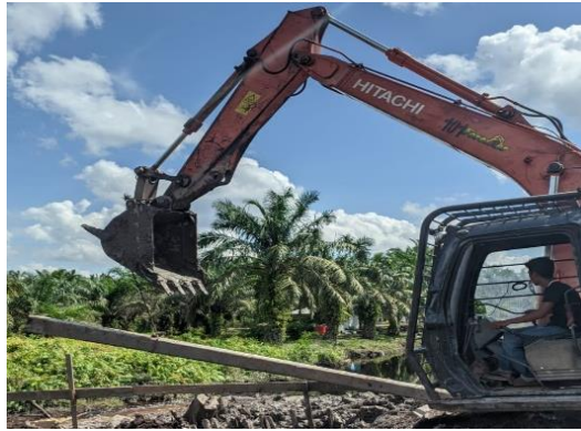
Gambar 4. 3 Pindahan Mini Pile Ke Patok Pemancangan
