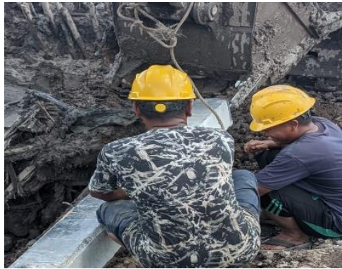
Gambar 4. 2 Pemasangan Clamp Sling Oleh Tukang
