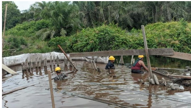
Gambar 3. 5 Proses Perbaikan Bendungan (Sumber: Dokumentasi Lapangan)
