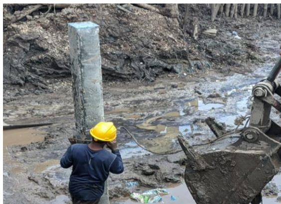
Gambar 4. 4 Pelepasan Clamp Sling Dari Tiang Pancang Oleh Kepala Tukang
