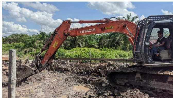
Gambar 3. 4 Proses Pemancangan Tiang Pancang Mini Pile (Sumber: Dokumentasi Lapangan)
