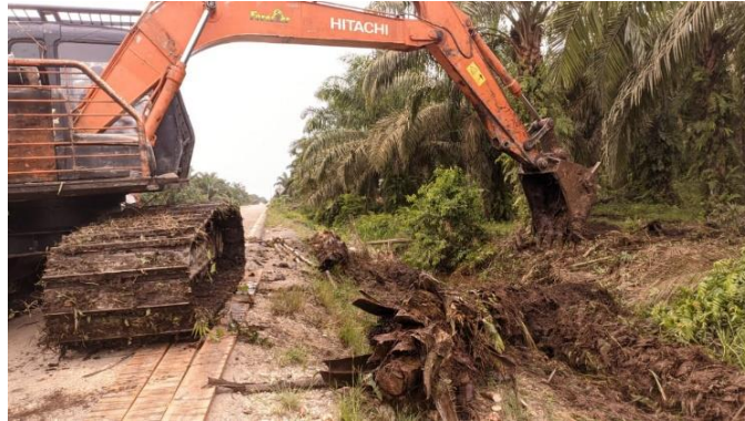
Gambar 3. 2 Pengambilan Pohon Sawit Sebagai Gambangan (Sumber: Dokumentasi Lapangan)
