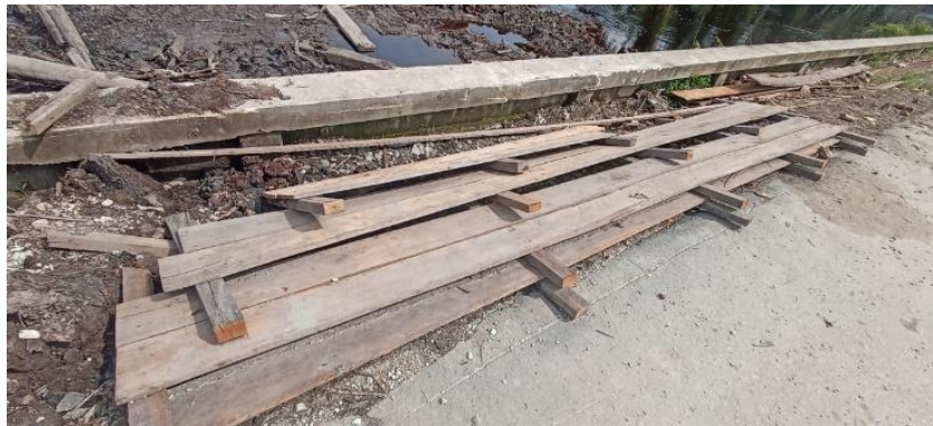
Gambar 3. 6 Mal Untuk Lantai Kerja dan Lantai Beton
