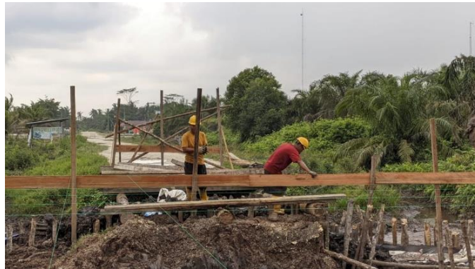
Gambar 3. 3 Proses Pemasangan Bowplank (Sumber: Dokumentasi Lapangan)
