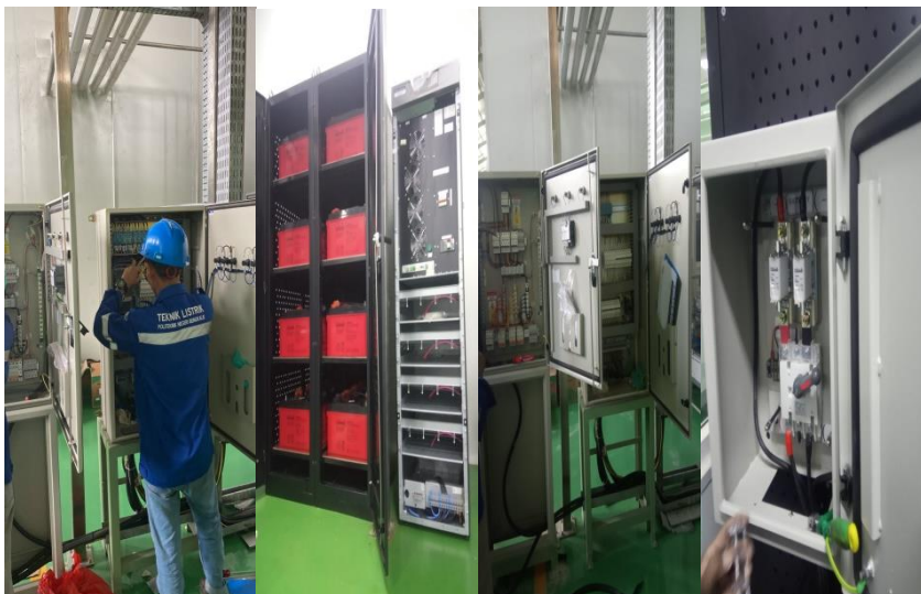
Gambar 2.12 melakukan pemasangan panel UPS 30kva Sumber : Dokumen Perusahaan PT. Sari Dumai Oleo
