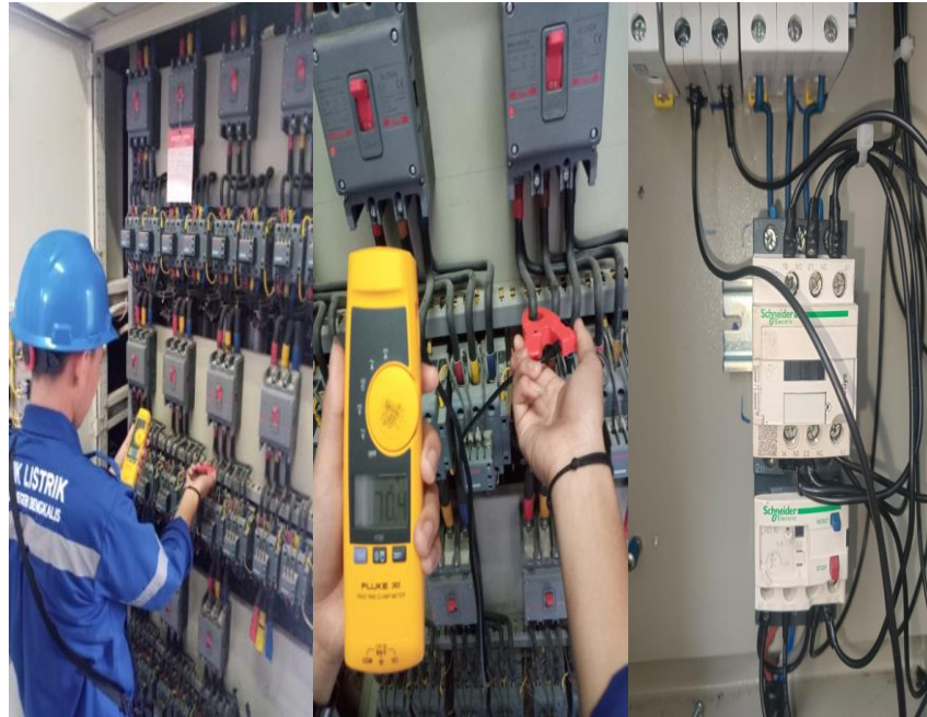
Gambar 2.2 Pengukuran Kapasitor Bank Sumber : Dokumen Perusahaan PT. Sari Dumai Oleo
