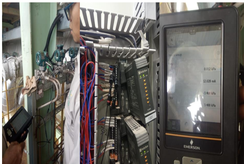
Gambar 2.7 merubah nilai range pada Transmitter Sumber : Dokumen Perusahaan PT. Sari Dumai Oleo
