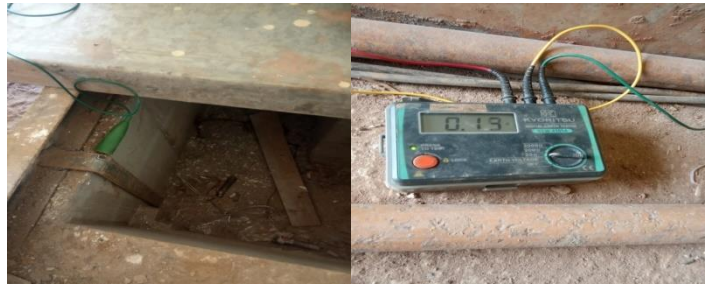
Gambar 2.8 melakukan pengukuran grounding Sumber : Dokumen Perusahaan PT. Sari Dumai Oleo
