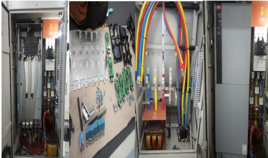
Gambar 2.4 perbaikan inverter Sumber : Dokumen Perusahaan PT. Sari Dumai Oleo
