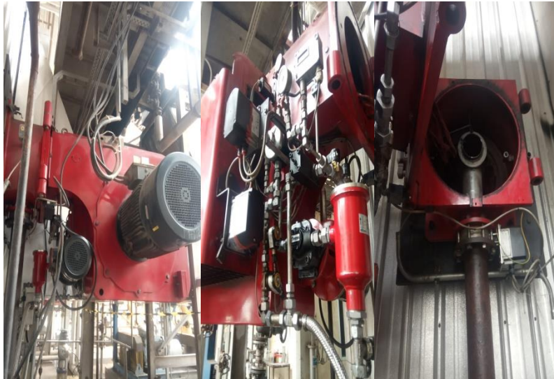
Gambar 2.11 perbaikan HPB (High Pressure Boiler) Sumber : Dokumen Perusahaan PT. Sari Dumai Oleo
