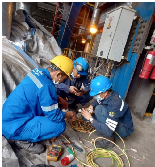
Gambar 2. 14 Proses penambahan power 3 phase di area Boiler unit 1 (Sumber : Dokumentasi 2023)
