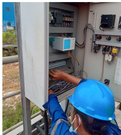
Gambar 2. 16 Proses pengecekan power penerangan di pos 8 (Sumber : Dokumentasi 2023)
