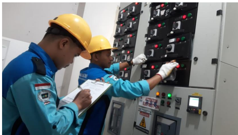
Gambar 2. 53 Pengecekan dan Pembersihan Braker dan Panel MCC Admin
