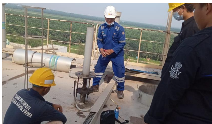
Gambar 2. 48 Proses penggantian Top Rapping (Sumber : Dokumentasi 2023)
