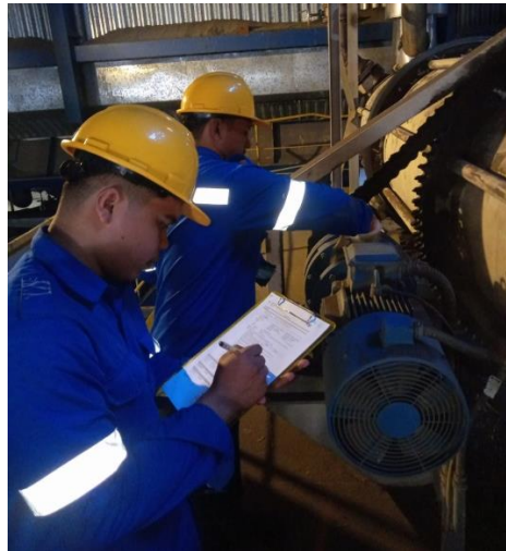
Gambar 2. 27 Proses PM di area Boiler (Sumber : Dokumentasi 2023)
