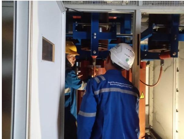
Gambar 2. 43 Proses cleaning di Trafo 400A (Sumber : Dokumentasi 2023)
