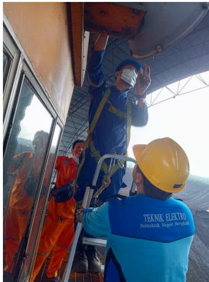
Gambar 2. 59 Penggantian lampu sorot SR
