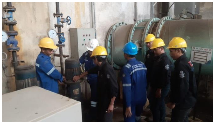
Gambar 2. 36 Proses pemasangan Motor Sump pump CWP (Sumber : Dokumentasi 2023)
