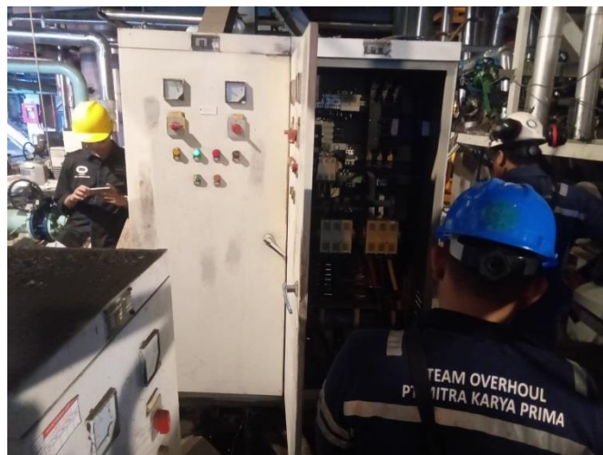
Gambar 2. 38 Proses penggantian Kontaktor Motor OCCWP (Sumber : Dokumentasi 2023)
