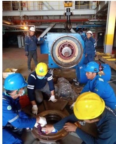
Gambar 3. 21 Pembersihan pada House Bearing (Sumber: Dokumentasi 2023)
