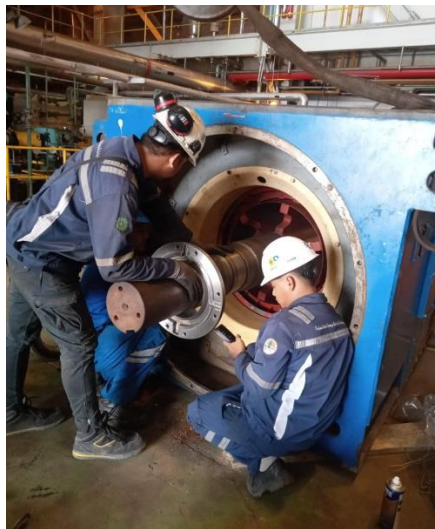
Gambar 3. 16 Pemasangan Ineer House Bearing (Sumber: Dokumentasi 2023)
