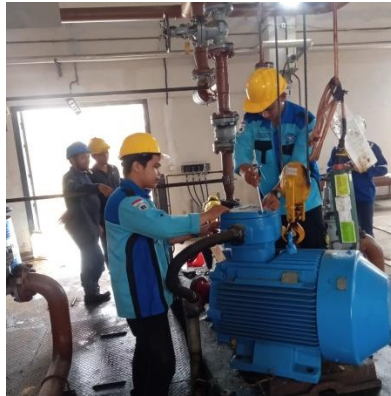
Gambar 2. 23 Proses pelepasan kabel power suplai (Sumber : Dokumentasi 2023)
