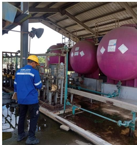
Gambar 2. 4 Proses pengambilan data nameplate Motor (Sumber : Dokumentasi 2023)
