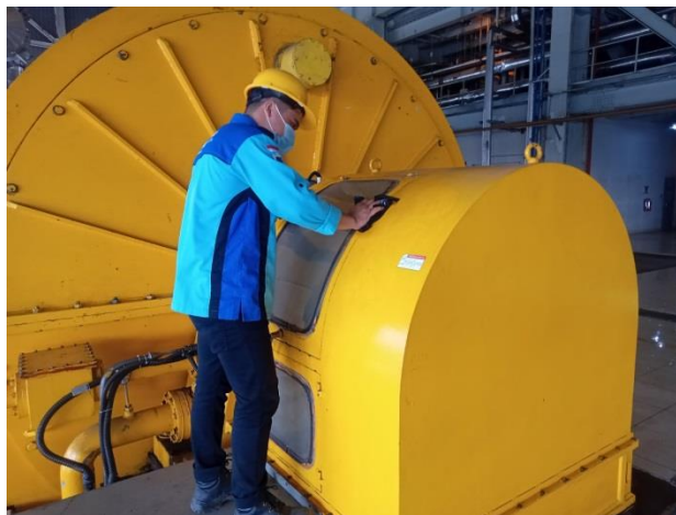
Gambar 2. 32 Proses pembersihan dan pengecekan Generator (Sumber : Dokumentasi 2023)
