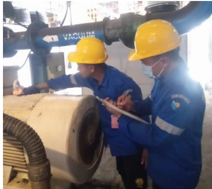
Gambar 2. 56 Pengecekan dan Pembersihan Body Motor
