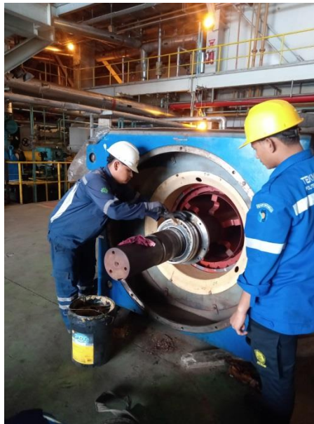
Gambar 2. 61 Penggantian Bearing Motor 6000V CWP
