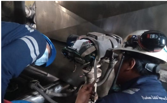
Gambar 2. 51 Proses pemindahan komponen MOV (Sumber : Dokumentasi 2023)
