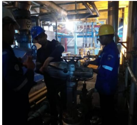
Gambar 2. 45 Proses pengecekan kerusakan MOV lantai 1 (Sumber : Dokumentasi 2023)
