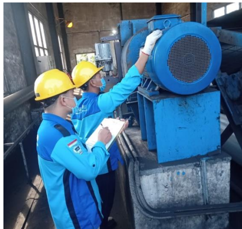
Gambar 2. 28 Proses PM di area CHCB (Sumber : Dokumentasi 2023)
