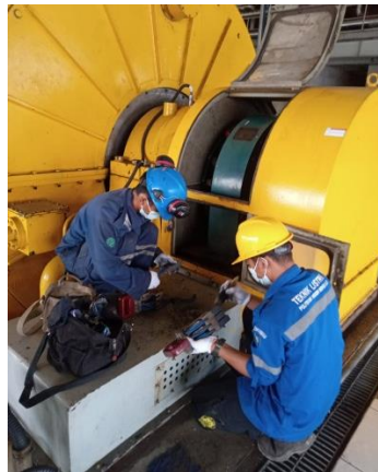
Gambar 2. 57 Pembersihan dan penggantian Karbon Brush Exciter
