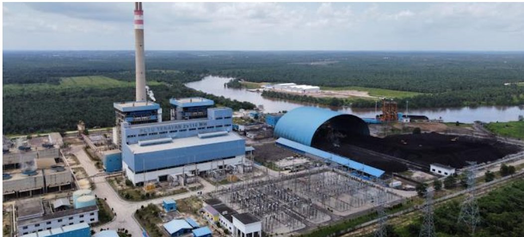
Gambar 1. 1 Penampakan PLTU Tenayan ( Sumber: Dokumentasi 2023 )
