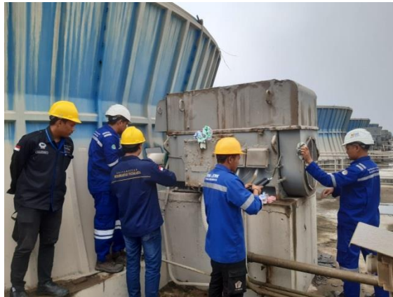
Gambar 2. 41 Proses pemberian gemuk pada Motor cooling fan tower (Sumber : Dokumentasi 2023)
