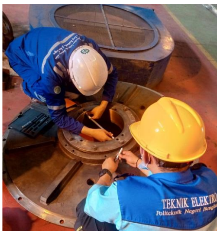
Gambar 2. 18 Proses pengukuran House bearing (Sumber : Dokumentasi 2023)
