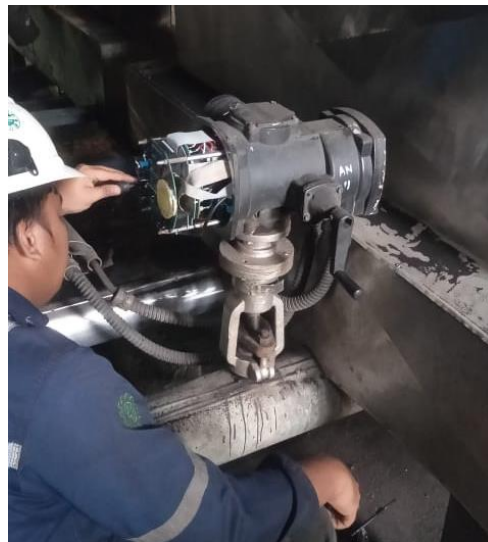
Gambar 2. 46 Proses penggantian Card Mov (Sumber : Dokumentasi 2023)
