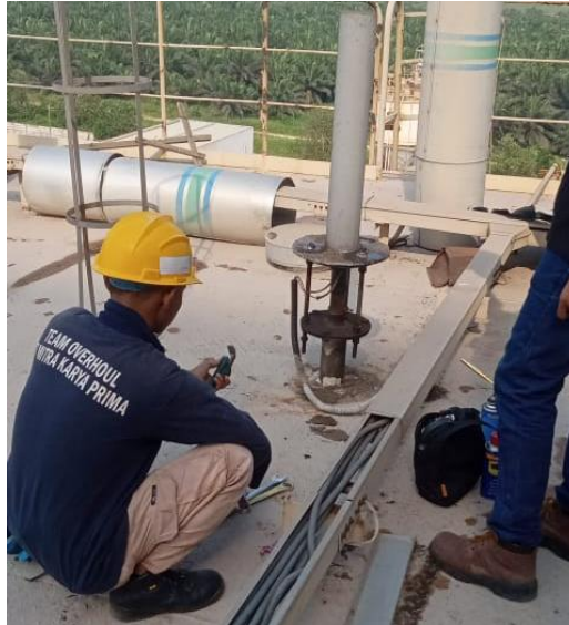
Gambar 2. 47 Proses Cleaning dan pengecekan korosi (Sumber : Dokumentasi 2023)
