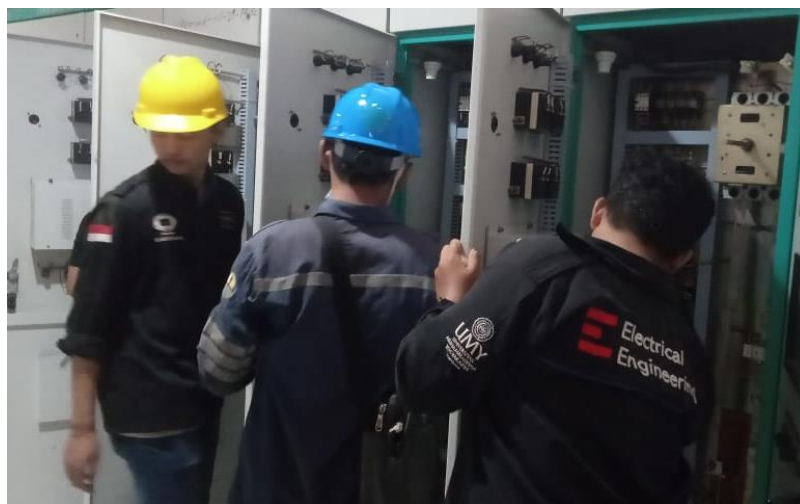
Gambar 2. 50 Proses pengecekan lampu di seluruh panel MCC ESP (Sumber : Dokumentasi 2023)
