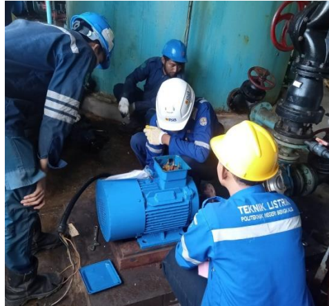
Gambar 2. 25 Proses pemasangan Motor Intermediate (Sumber : Dokumentasi 2023)
