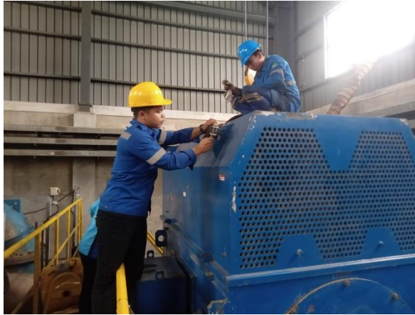
Gambar 2. 62 Penggantian Cooler Motor 6000V CWP 2A (Sumber: Dokumentasi 2023)
