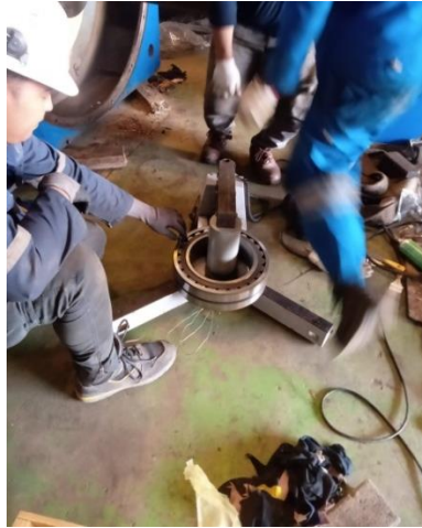
Gambar 3. 19 Pemanasan Bearing Menggunakan Heater
