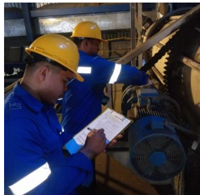
Gambar 2. 55 Pengecekan dan Pembersihan Body Motor
