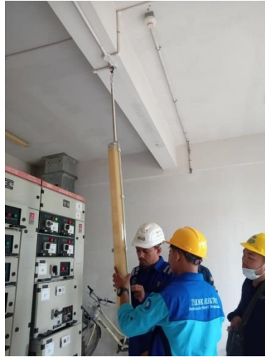
Gambar 2. 60 Penggantian lampu di ruangan Breaker WTP (Sumber: Dokumentasi 2023)
