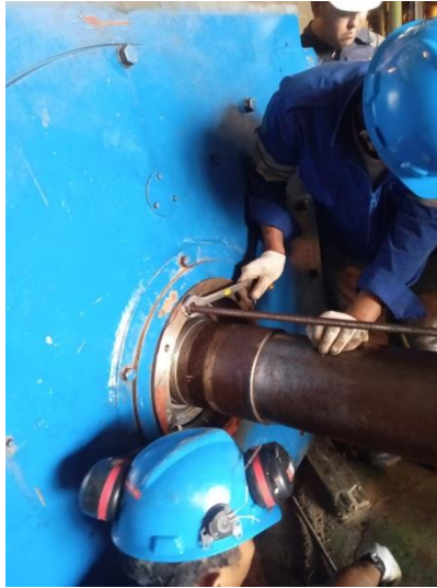
Gambar 3. 23 Pengencangan baut pada Inner dan Housing Bearing (Sumber: Dokumentasi 2023)
