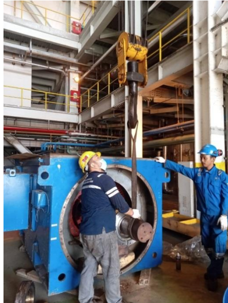
Gambar 3. 15 Pengangkatan Main Shaft oleh Crane (Sumber: Dokumentasi 2023)
