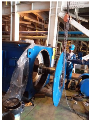
Gambar 3. 22 Pembersihan pada House Bearing (Sumber: Dokumentasi 2023)
