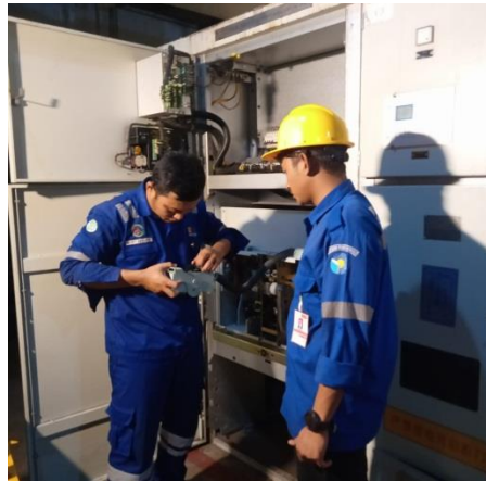
Gambar 2. 21 Proses perbaikan Bass 6KV (Sumber : Dokumentasi 2023)
