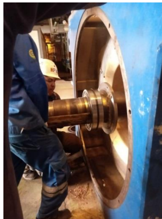
Gambar 3. 20 Pemasangan Bearing pada Main Shaft
