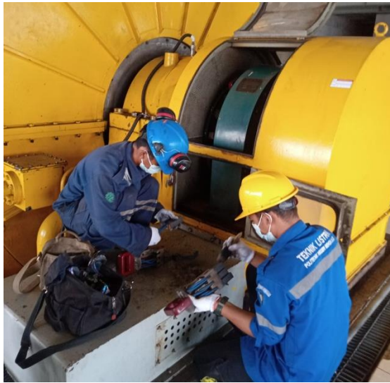
Gambar 2. 19 Proses penggantian Carbon Brush Exciter (Sumber : Dokumentasi 2023)
