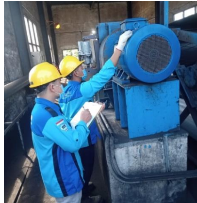
Gambar 2. 54 Pengecekan dan Pembersihan Body Motor C05
