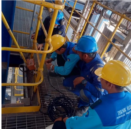
Gambar 2. 13 Proses penambahan power dan penerangan di area Boiler (Sumber : Dokumentasi 2023)
