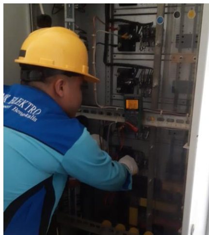
Gambar 2. 26 Proses PM di area WTP (Sumber : Dokumentasi 2023)
