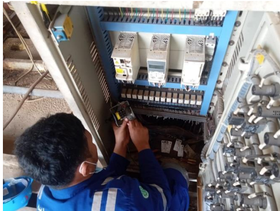
Gambar 2. 31 Proses penambahan power suplai Motor PAC (Sumber : Dokumentasi 2023)
