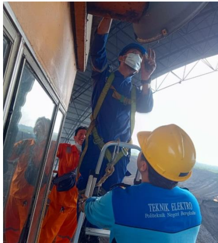
Gambar 2. 15 Proses penggantian lampu SR (Sumber : Dokumentasi 2023)
