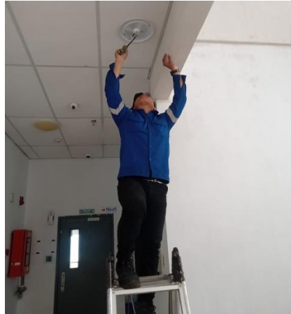
Gambar 2. 33 Proses perbaikan lampu Admin (Sumber : Dokumentasi 2023)
