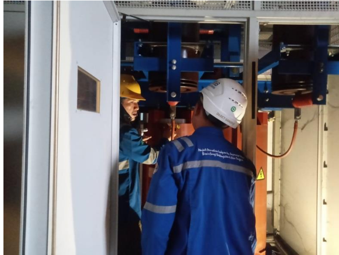
Gambar 2. 63 Overhaul di bagian Trafo (Sumber: Dokumentasi 2023)
