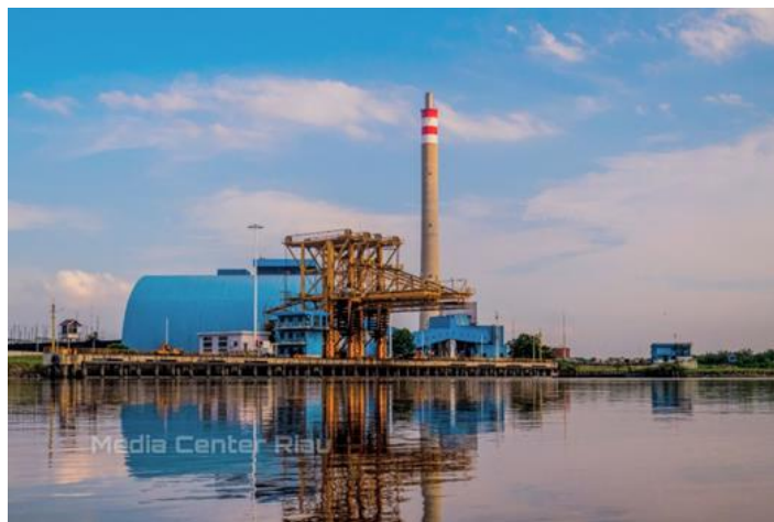
Gambar 1. 4 PLTU Tenayan Dari Belakang (Sumber: Dokumentasi 2023)
