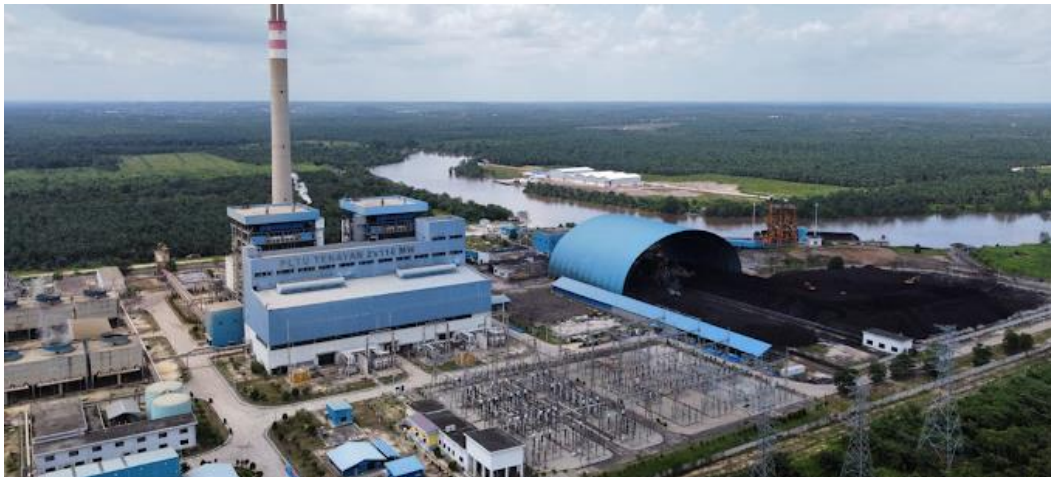
Gambar 1. 1 Penampakan PLTU Tenayan ( Sumber: Dokumentasi 2023 )
