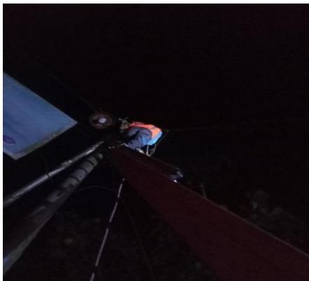
Gambar 2. 26 Perbaikan kabel SR yang putus Sumber: PT. Adra Gemilang. 2023
