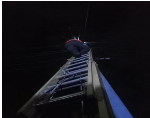
Gambar 2. 56 Memperbaiki lost kontak Sumber: PT. Adra Gemilang. 2023
