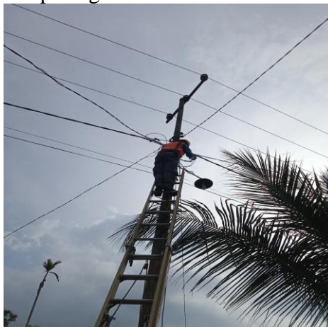
Gambar 2. 61Perbaikan lost kontak Sumber: PT. Adra Gemilang. 2023
