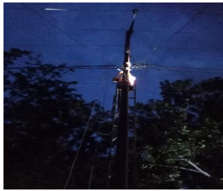
Gambar 2. 50 Perbaikan lost kontak Sumber: PT. Adra Gemilang. 2023
