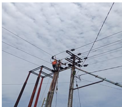
Gambar 2. 32 Perbaikan kabel SKTM Sumber: PT. Adra Gemilang. 2023
