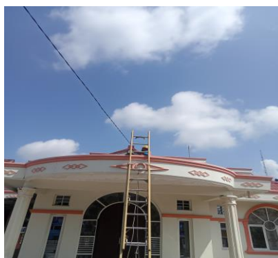
Gambar 2. 43Perbaikan kabel SR Sumber: PT. Adra Gemilang. 2023
