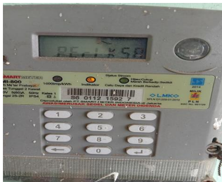
Gambar 2. 42 Pembuatan kode CT ( Clear Tamper ) Sumber: PT. Adra Gemilang. 2023
