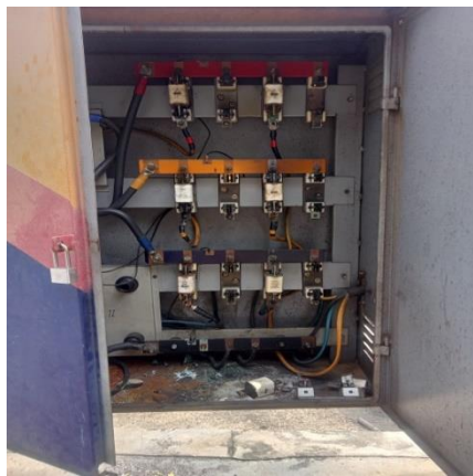
Gambar 2. 25 Penggantian NH fuse Sumber: PT. Adra Gemilang. 2023
