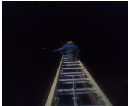
Gambar 2. 24 Perbaikan lampu padam Sumber: PT. Adra Gemilang. 2023
