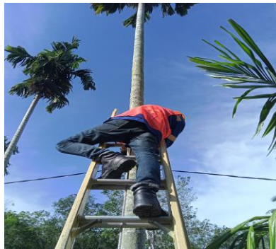
Gambar 2. 6 Perbaikan kabel SR Sumber : PT. Adra Gemilang. 2023
