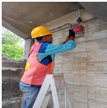
Gambar 2. 7Penukaran kWh meter sementara Sumber : PT. Adra Gemilang. 2023
