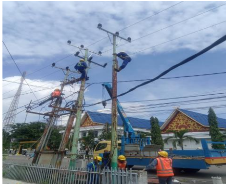
Gambar 2. 58 Perbaikan tiang listrik Sumber: PT. Adra Gemilang. 2023
