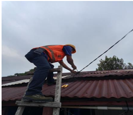
Gambar 2. 49 Perbaikan kabel SR Sumber: PT. Adra Gemilang. 2023
