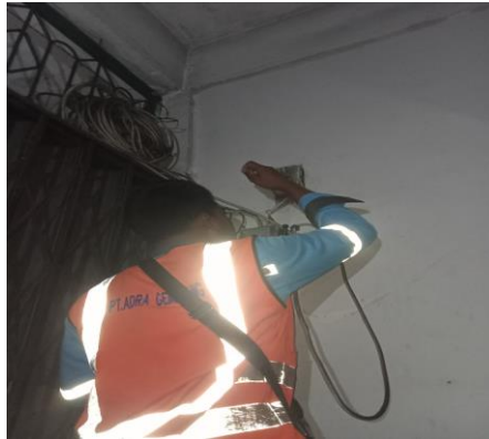
Gambar 2. 41 Perbaikan lampu padam Sumber: PT. Adra Gemilang. 2023
