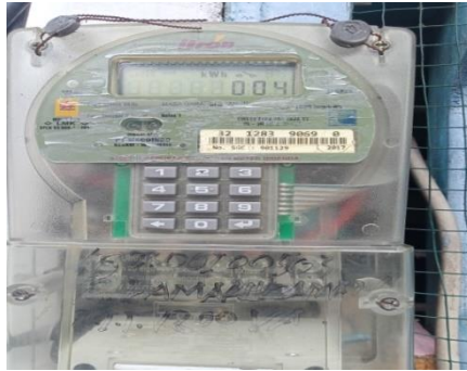
Gambar 2. 16 Memasukkan kode clear tamper pada kWh meter Sumber : PT. Adra Gemilang. 2023
