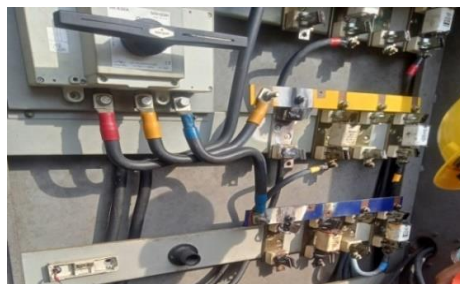
Gambar 2. 17 Memperbaiki trafo Sumber : PT. Adra Gemilang. 2023
