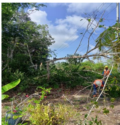
Gambar 2. 12 Pemangkasan pohon Sumber : PT. Adra Gemilang. 2023
