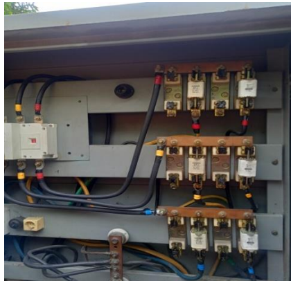
Gambar 2. 14Penggantian NH fuse Sumber : PT. Adra Gemilang. 2023
