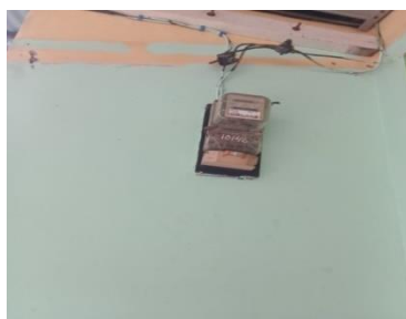
Gambar 2. 38 Perbaikan MCB pada kWh meter Sumber: PT. Adra Gemilang. 2023
