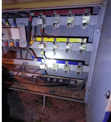
Gambar 2. 48 Pemeliharaan trafo Sumber: PT. Adra Gemilang. 2023
