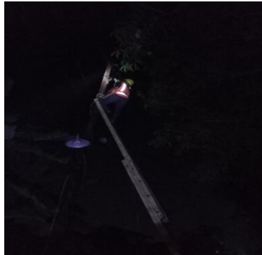
Gambar 2.33 Perbaikan lampu padam Sumber: PT. Adra Gemilang. 2023
