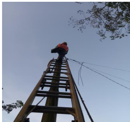
Gambar 2. 28 Perbaikan lampu padam Sumber: PT. Adra Gemilang. 2023
