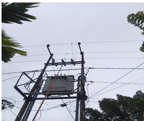
Gambar 2. 55 Penggantian fuse link Sumber: PT. Adra Gemilang. 2023
