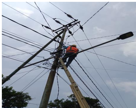
Gambar 2. 39 Perbaikan kabel SR Sumber: PT. Adra Gemilang. 2023
