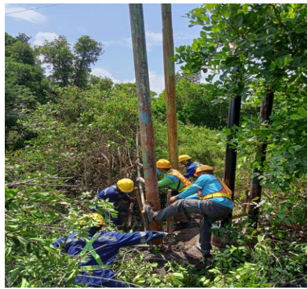
Gambar 2. 46 Pemangkasan pohon Sumber: PT. Adra Gemilang. 2023
