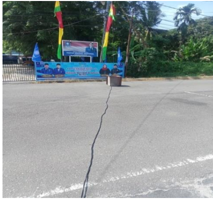
Gambar 2. 29Perbaikan kabel SR Sumber: PT. Adra Gemilang. 2023
