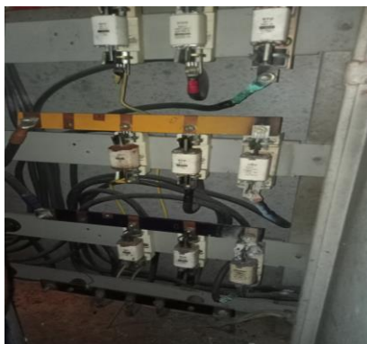
Gambar 2. 54 Pemeriksaan dan pemeliharaan trafo Sumber: PT. Adra Gemilang. 2023
