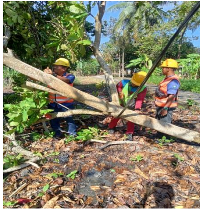
Gambar 2. 23Perbaikan kabel listrik SKTM Sumber: PT. Adra Gemilang. 2023
