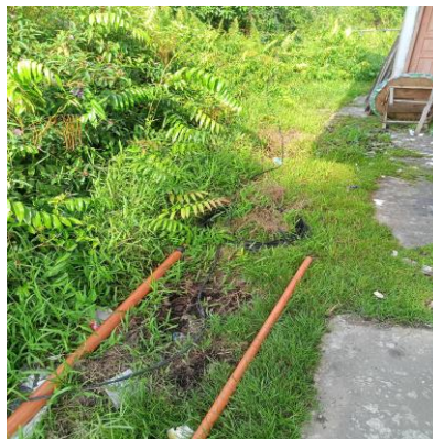
Gambar 2. 11 Perbaikan kabel SR Sumber : PT. Adra Gemilang. 2023
