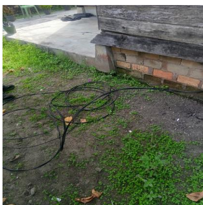
Gambar 2. 13 Pemindahan kabel SR Sumber : PT. Adra Gemilang. 2023
