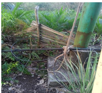
Gambar 2. 35Perbaikan kabel SR Sumber: PT. Adra Gemilang. 2023
