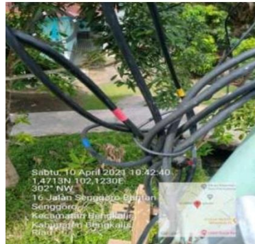
Gambar 3.8 Isolasi ulang/membrikan Isolasi pada Kabel Bushing Jurusan
