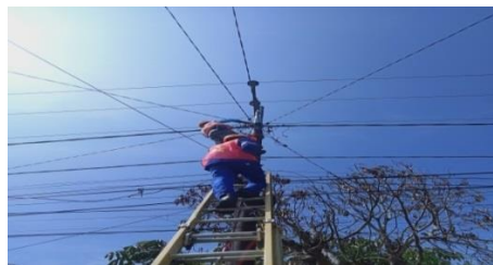
Gambar 2.51 Perbaikan Kabel SR ( Sumber : PT. Adra gemilang.2023)
