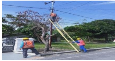
Gambar 2.45 Menaikan kabel SR yang Kendor akibat di Tabrak Mobil ( Sumber : PT. Adra gemilang.2023)
