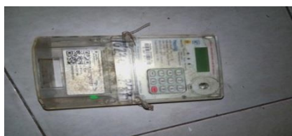
Gambar 2.26 Melakukan Pengantian KWh Meter akibat Lost Kontak ( Sumber :PLN. Rayon bengkalis PT. Adra gemilang.2023)
