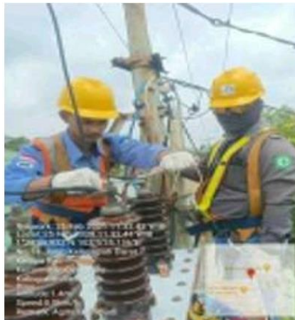
Gambar 3.13 mMenguncikan / Mengecangkan Baut pada Bushing Trafo
