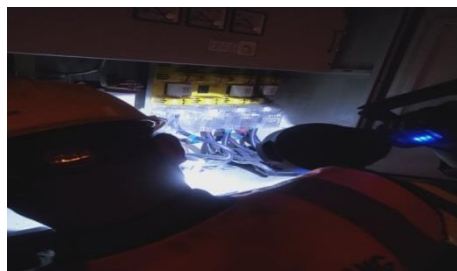
Gambar 2.41 Melakukan Pengecekan NH FUSE ( Sumber : PT. Adra gemilang.2023 )
