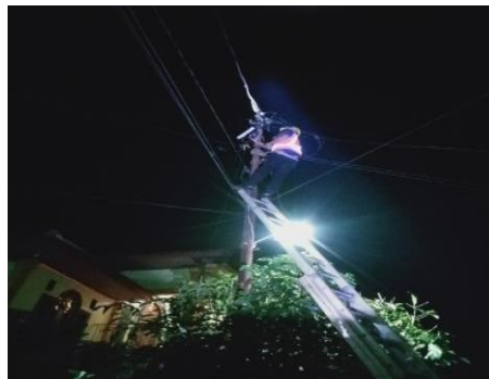
Gambar 2.28 Melakukan pemindahan Kabel SR yang terjadi Hubung Singkat ( Sumber :PLN. PT. Adra gemilang.2023 )
