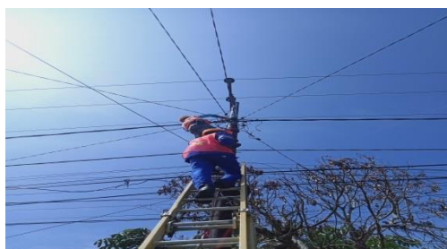
Gambar 2.33 melakukan penggantian piercing connector ( Sumber :PLN. PT. Adra gemilang.2023 )
