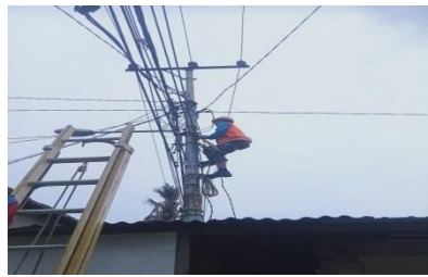
Gambar 2. 21 Melakukan Pengunciaan Piercing Connector Pada Rumah Pelanggan ( Sumber PT. Adra gemilang.2023 )
