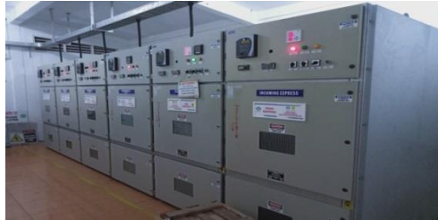
Gambar 2.34 Melakukan Pengecekan Feeder yang Ttrip ( Sumber :PLN. PT. Adra gemilang.2023 )
