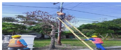
Gambar 2.55 Perbaikan Kabel SKHU yang Kendor ( Sumber : PT. Adra gemilang.2023)
