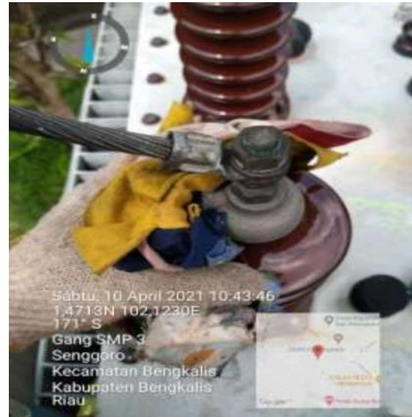
Gambar 3. 11 Memebersihkan dan Mengelap Blusing Trafo
