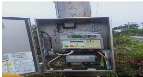
Gambar 2.44 Mengatasi Gangguan RC / Trip di Jalan Penampi ( Sumber : PT. Adra gemilang.2023 )
