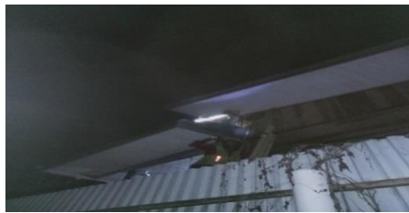
Gambar 2. 23 Melakukan Pengantian Piercing yangTerbakar ( Sumber :PLN. Rayon bengkalis PT. Adra gemilang.2023 )
