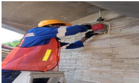
Gambar 2. 13 Perbaikan KWh Meter yang Rusak Dan Mengatikan KWh Sementara ( Sumber: PT. Adra gemilang.2023 )
