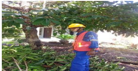
Gambar 2.54 Melakukan Pemangkasan Pohon diarea Kabel SR. ( Sumber : PT. Adra gemilang.2023)
