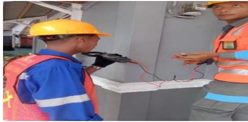
Gambar 2.25 melakukan perbaikan tegangan drop di rumah pelanggan ( Sumber :PLN. Rayon bengkalis PT. Adra gemilang.2023)
