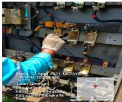
Gambar 3.6 Memeberikan Minyak Gres pada kedudukan NH Fuse
