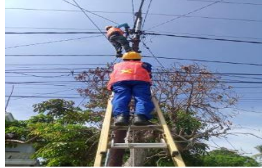
Gambar 2.3 Perbaikan Kabel SR ( Sumber PT. Adra gemilang.2023)
