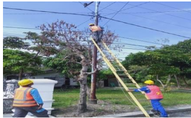
Gambar 2.30 Perbaikan Kabel SR yang tertabrak mobil tronton. ( Sumber :PLN. PT. Adra gemilang.2023)
