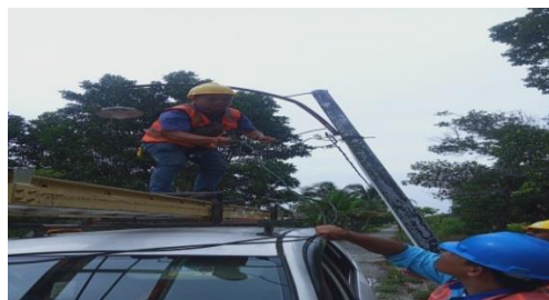
Gambar 2.11 Penaikan Kabel Pada Rumah Pelanggan ( Sumber :PT. Adra gemilang.2023)
