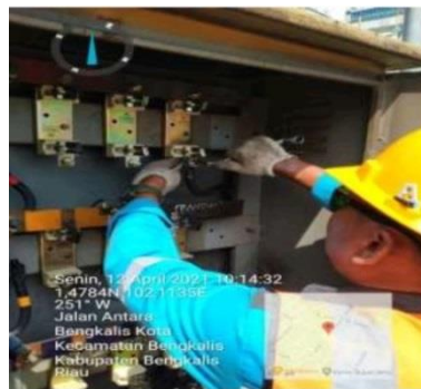
Gambar 3.7 Menguci/Menegecangkan Baut di Busing Primer dan Skunder
