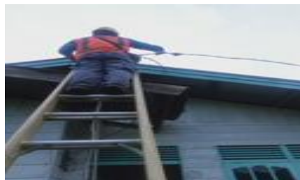
Gambar 2.5 Perbaikan Kabel SR yang Tertabrak Mobil (Sumber: PT. Adra gemilang.2023)
