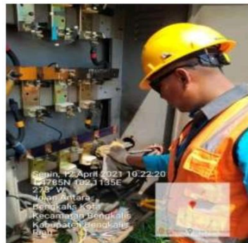
Gambar 3.9 Memebersihkan dan Mengelap Blusing Trafo
