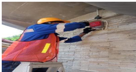
Gambar 2.60 Melakukan pengantian pada Kwh Meter Sementara ( Sumber :PT. Adra gemilang.2023)
