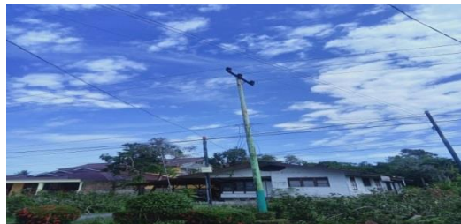
Gambar 2.24 Melakukan Pemangkasan di JTM ( Sumber :PT. Adra gemilang.2023
