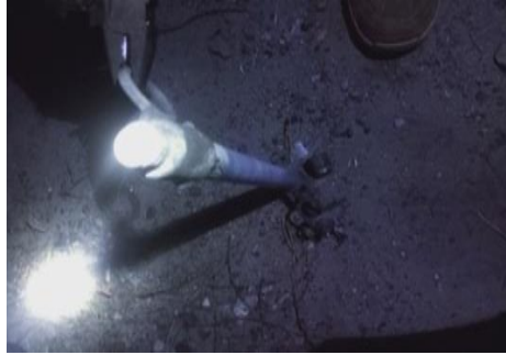
Gambar 2.59 Melakukan Penggantian Fuse Link FCO ( Sumber :PT. Adra gemilang.2023)
