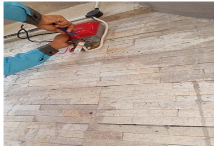
Gambar 2.15 Mengatikan KWh Sementara ( Sumber : PT. Adra gemilang.2023)
