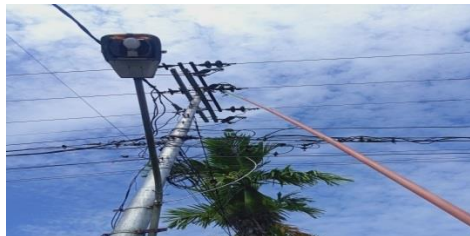
Gambar 2.46 Menganti dan memperbaiki Fuse Link FCO ( Sumber : PT. Adra gemilang.2023)
