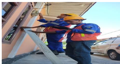
Gambar 2.49 Mengatasi Gangguan KWh Meter yang tidak bisa di masukan Kode CT ( Sumber : PT. Adra gemilang.2023)
