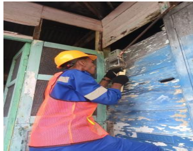
Gambar 2.9 Adanya Gangguan Pada KWh Meter ( Sumber : PT. Adra gemilang.2023 )
