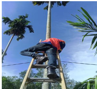
Gambar 2.35 Melakukan penegangan Kabel SR yang Kendor ( Sumber :PLN. PT. Adra gemilang.2023 )
