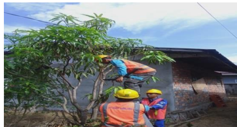
Gambar 2.18 Menaikan Kebel SR yang Kendor pada Rumah pelanggan ( Sumber : PT. Adra gemilang.2023 )
