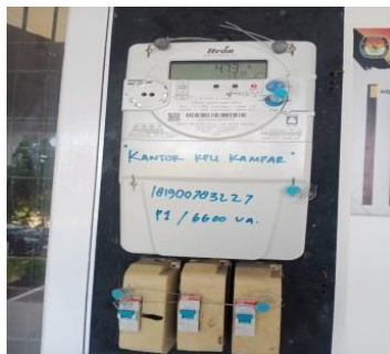
Gambar 2. 16 Pemasangan Kwh Meter 3 Phasa
