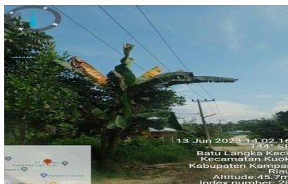
Gambar 2. 6 Ranting pohon Dekat Jaringan (Sumber : PT. PLN (Persero) ULP Bangkinang 2023)
