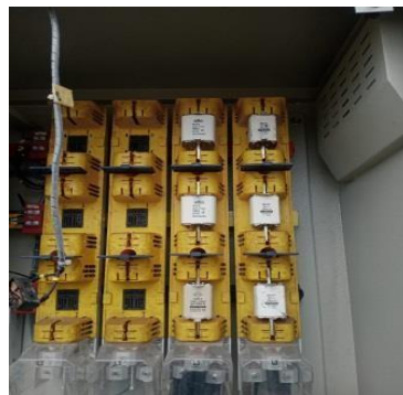
Gambar 2. 32 Penggantian NH Fuse (Sumber : PT. PLN (Persero) ULP Bangkinang 2023)
