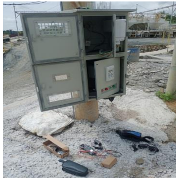
Gambar 2. 45 Pemasangan Modem (Sumber : PT. PLN (Persero) ULP Bangkinang 2023)
