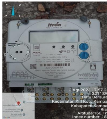
Gambar 2. 33 Penggantian Kwh Meter 3 Phasa (Sumber : PT. PLN (Persero) ULP Bangkinang 2023)
