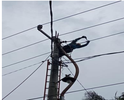
Gambar 2. 35 Penyambungan Kabel Tanah (Sumber : PT. PLN (Persero) ULP Bangkinang 2023)
