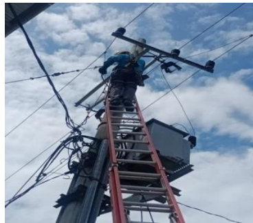
Gambar 2. 18 Pemasangan Treck Schoor
