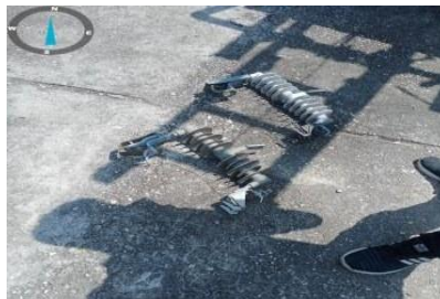
Gambar 2. 10 Penggantian FCO Trafo (Sumber : PT. PLN (Persero) ULP Bangkinang 2023)
