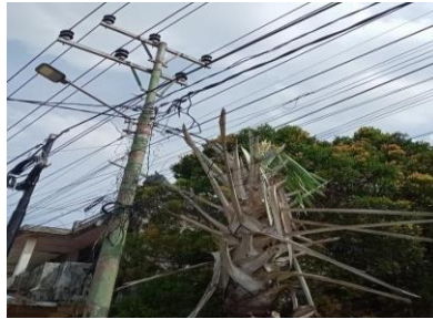
Gambar 2. 3 Ranting pohon dekat jaringan (Sumber : PT. PLN (Persero) ULP Bangkinang 2023)
