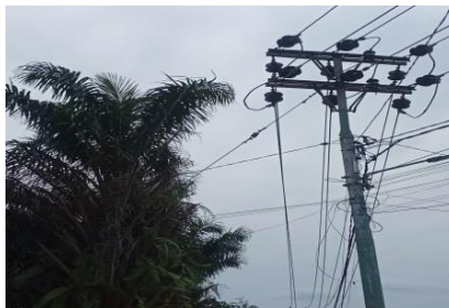
Gambar 2. 5 Ranting pohon dekat jaringan (Sumber : PT.PLN (Persero) ULP Bangkinang 2023)
