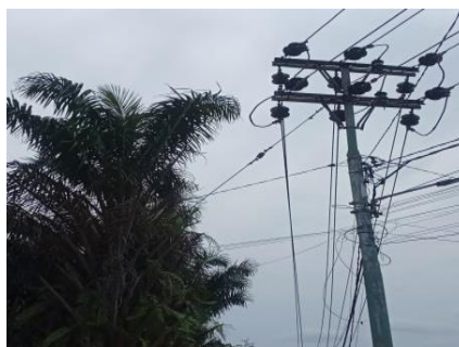
Gambar 2.5 Ranting pohon dekat jaringan (Sumber : PT.PLN (Persero) ULP Bangkinang 2023)
