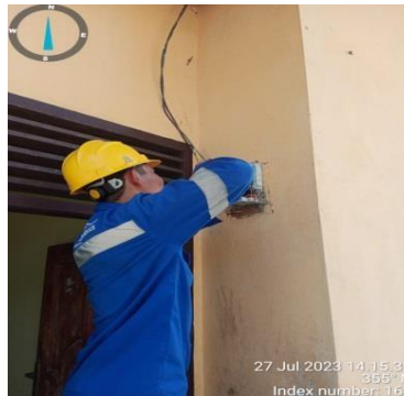
Gambar 2. 30 Pemasangan Kwh Meter 1 Phasa (Sumber : PT. PLN (Persero) ULP Bangkinang 2023)
