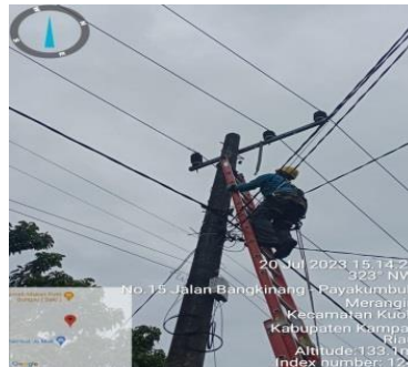
Gambar 2. 26 Pemasangan Pin Cover Isolator (Sumber : PT. PLN (Persero) ULP Bangkinang 2023)
