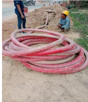
Gambar 2. 37 Pemasangan Kabel Tanah (Sumber : PT. PLN (Persero) ULP Bangkinang 2023)
