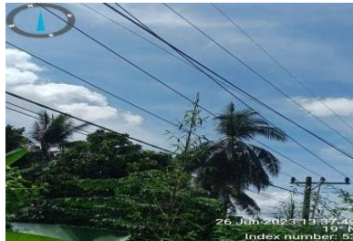
Gambar 2. 14 Ranting Pohon Dekat Jaringan (Sumber : PT. PLN (Persero) ULP Bangkinang 2023)
