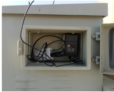
Gambar 2. 29 Pemasangan Modem (Sumber : PT. PLN (Persero) ULP Bangkinang 2023)
