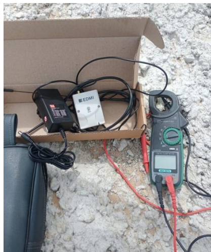
Gambar 2. 34 Penggantian Modem (Sumber : PT. PLN (Persero) ULP Bangkinang 2023)
