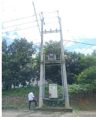
Gambar 2. 47 Inspeksi Jaringan Tegangan Menengah (Sumber : PT. PLN (Persero) ULP Bangkinang 2023)
