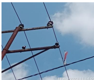
Gambar 2. 39 Layangan Dijaringan Tengan Menengah (Sumber : PT. PLN (Persero) ULP Bangkinang 2023)
