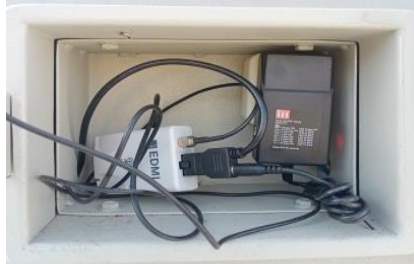
Gambar 2. 11 Pemasangan Modem (Sumber : PT. PLN (Persero) ULP Bangkinang 2023)
