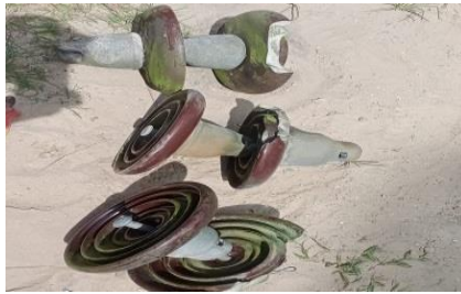
Gambar 2. 7 Penggantian Isolator Tarik (Sumber : PT. PLN (Persero) ULP Bangkinang 2023)
