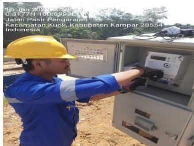
Gambar 2. 8 Pemasangan Modem (Sumber : PT. PLN (Persero) ULP Bangkinang 2023)
