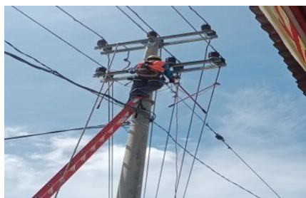
Gambar 2. 4 Penggantian sutm (Sumber : PT. PLN (Persero) ULP Bangkinang)
