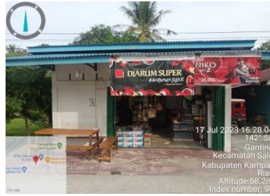
Gambar 2. 25 Survei Pemasangan Baru (Sumber : PT. PLN (Persero) ULP Bangkinang 2023)
