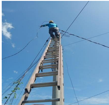
Gambar 2. 27 Penggantian Kabel Saluran Rumah (Sumber : PT. PLN (Persero) ULP Bangkinang 2023)
