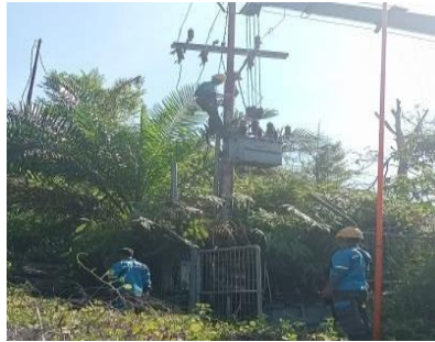
Gambar 2. 9 Penggantian Trafo (Sumber : PT. PLN (Persero) ULP Bangkinang 2023)
