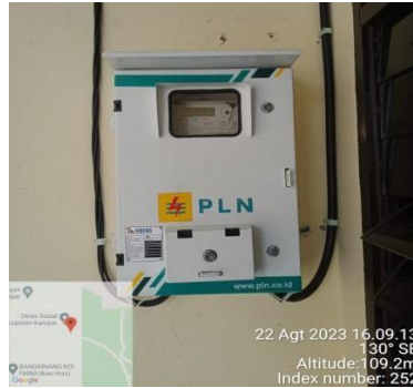
Gambar 2. 44 Pemasangan Panel Box (Sumber : PT. PLN (Persero) ULP Bangkinang 2023)
