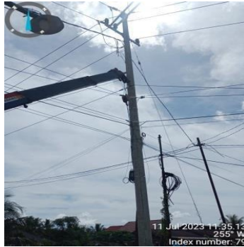
Gambar 2. 21 Pemasangan Treck Schoor (Sumber : PT. PLN (Persero) ULP Bangkinang 2023)
