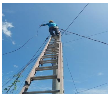
Gambar 2. 23 Pemasangan Kabel SR (Sumber : PT. PLN (Persero) ULP Bangkinang 2023)
