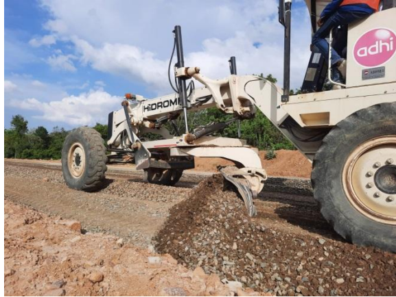
Gambar 3.21 Meratakan Base A Menggunakan Grader (Sumber : Dokumentasi Kerja Praktek, 2023)
