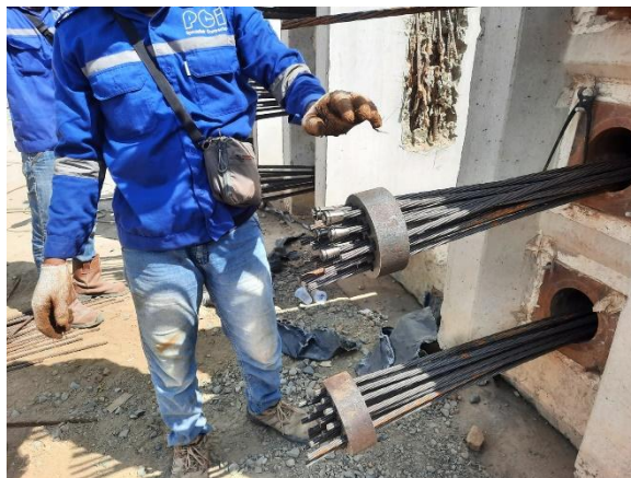
Gambar 3.53 Pemasangan Anchor
