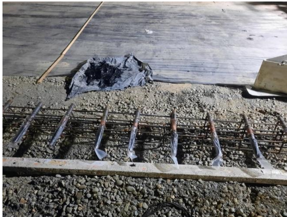
Gambar 3.30 Peletakan Dowel
