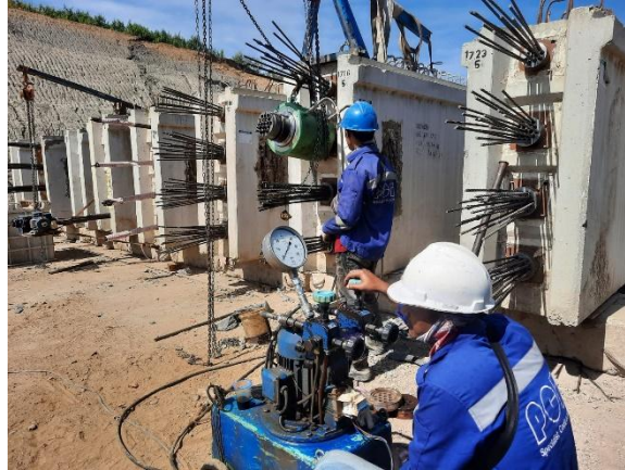
Gambar 3.54 Stressing (penarikan kabel strand) (Sumber : Dokumentasi Kerja Praktek, 2023)
