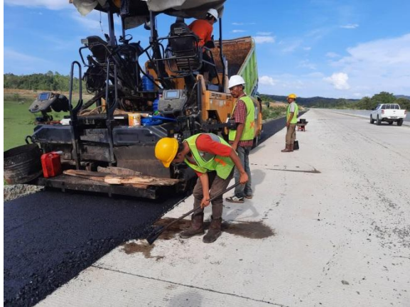
Gambar 3.46 Meratakan aspal dengan mesin aspal finisher
