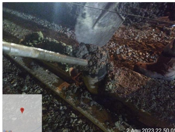
Gambar 3.43 Virator untuk memastikan sampel beton sempurna
