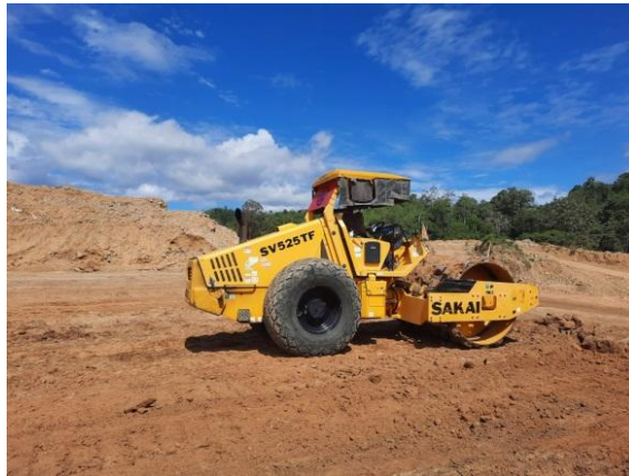
Gambar 3.10 Pekerjaan Pemadatan Menggunakan Sheep Foot (Sumber : Dokumentasi Kerja Praktek, 2023)
