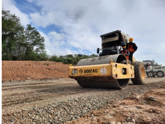
Gambar 3.23 Pemasatan Base A
