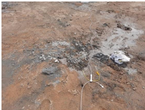
Gambar 3.4 Rangkaian Kabel Surface
