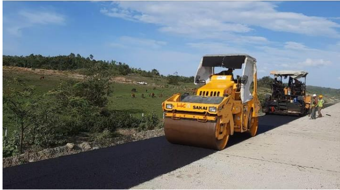
Gambar 3.48 Pematatan menggunakan tandem roller (Sumber : Dokumentasi Kerja Praktek, 2023)
