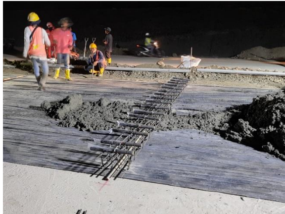
Gambar 3.36 Peletakan besi dowel melintang (Sumber : Dokumentasi Kerja Praktek, 2023)
