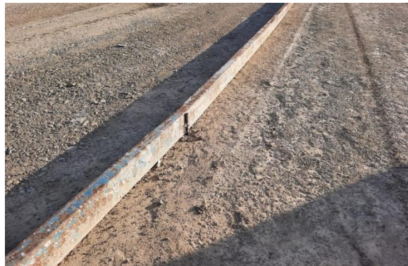
Gambar 3.26 Pemasangan Bekisting Hollow
