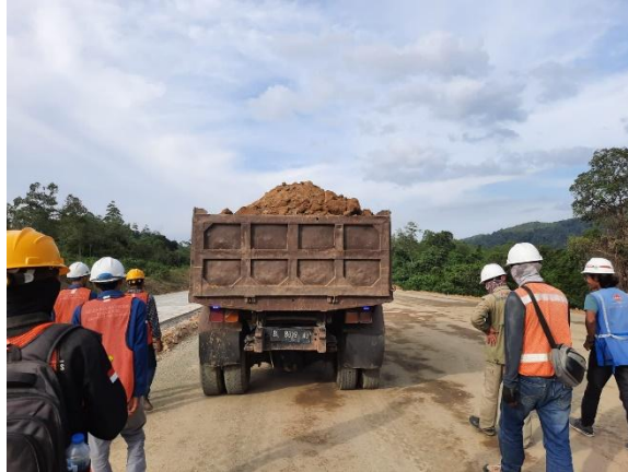
Gambar 3.24 Pengujian Proof Rolling
