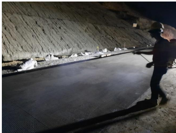
Gambar 3.40 Pekerjaan curing
