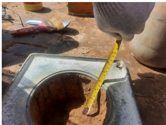
Gambar 3.13 Pekerjaan Pengukuran Dimensi Lubang (Sumber : Dokumentasi Kerja Praktek, 2023)
