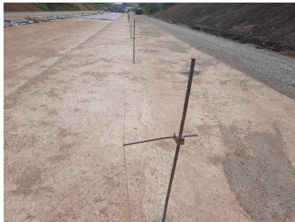
Gambar 3.28 Pemasangan String Line
