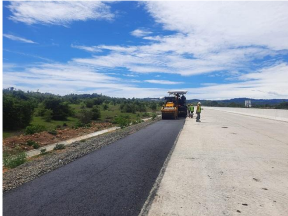
Gambar 3.50 Pematatan akhir menggunakan tandem roller (Sumber : Dokumentasi Kerja Praktek, 2023)
