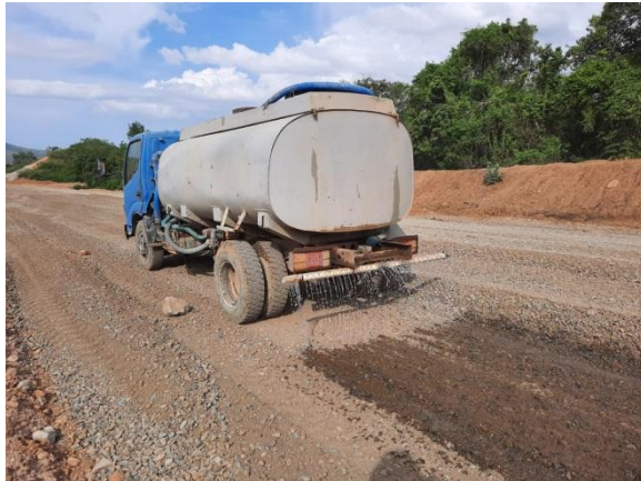
Gambar 3.22 Penyiraman Untuk Mendapatkan Hasil Pematatan Yang Bagus (Sumber : Dokumentasi Kerja Praktek, 2023)
