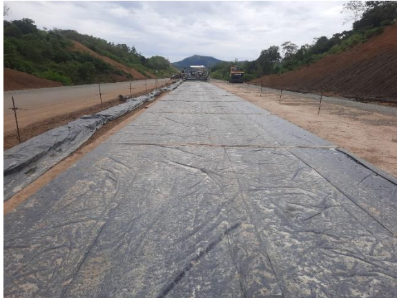
Gambar 3.29 Pemasangan plastik Terpal
