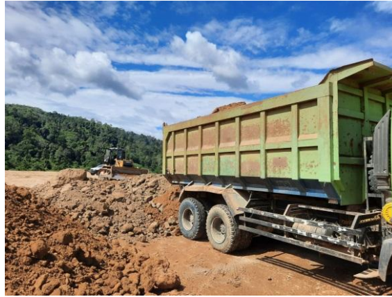
Gambar 3.8 Pekerjaan Penghamparan Tanah Timbunan (Sumber : Dokumentasi Kerja Praktek, 2023)
