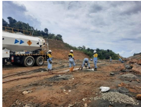
Gambar 3.3 Pekerjaan Pengisian bahan Peledak
