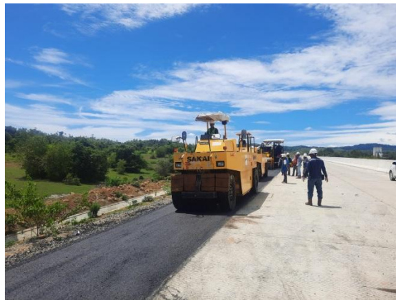
Gambar 3.49 Pematatan kedua menggunakan Pneumatic Tandem Roller (Sumber : Dokumentasi Kerja Praktek, 2023)
