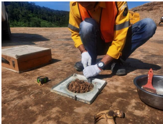
Gambar 3.12 Pekerjaan Penggalian Tanah (Sumber : Dokumentasi Kerja Praktek, 2023)
