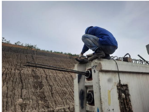
Gambar 3.55 Pemotongan kabel
