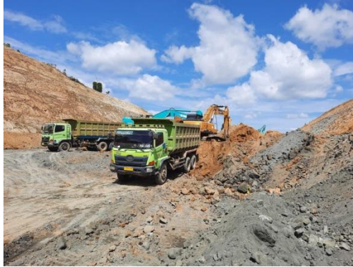
Gambar 3.7 Pekerjaan Pengangkatan Material (Sumber : Dokumentasi Kerja Praktek, 2023)
