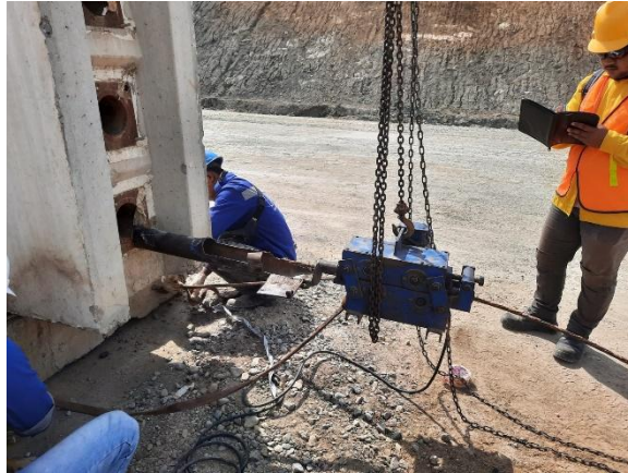
Gambar 3.52 Memasukkan Kabel Strand
