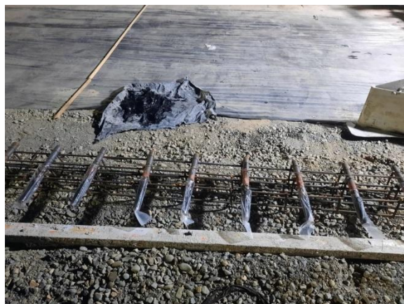
Gambar 3.35 Dowel (Sumber : Dokumentasi Kerja Praktek, 2023)
