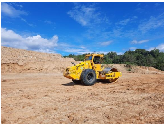
Gambar 3.11 Pekerjaan Pemadatan Menggunakan Wheel Roller (Sumber : Dokumentasi Kerja Praktek, 2023)
