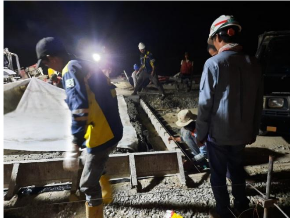
Gambar 3.38 Pemasangan Cover Awal mulai pekerjaan
