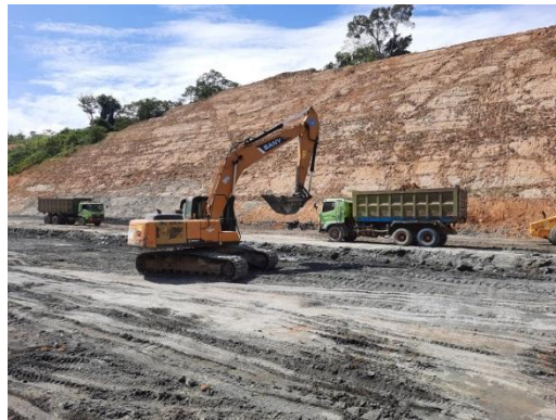
Gambar 3.6 Pekerjaan Pembersihan Hasil Blasting
