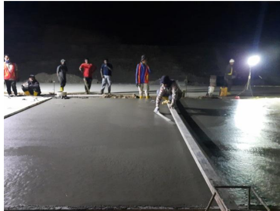
Gambar 3.34 meratakan permukaan beton menggunakan raskam (Sumber : Dokumentasi Kerja Praktek, 2023)
