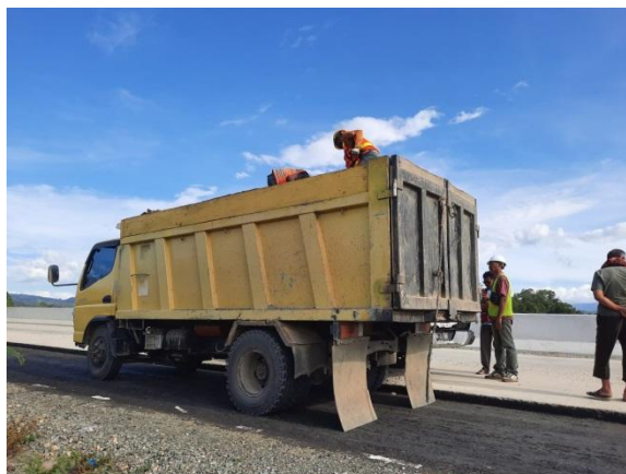
Gambar 3.45 Penghamparan aspal dari Dump truck
