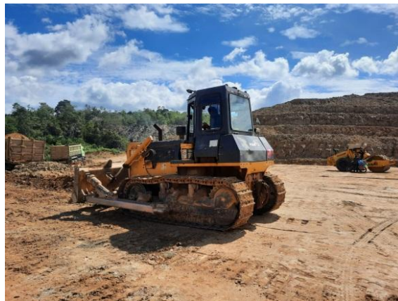
Gambar 3.9 Pekerjaan Meratakan Timbunan (Sumber : Dokumentasi Kerja Praktek, 2023)
