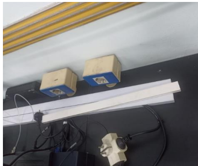
Gambar 2. 3 Pemasangan Cable tray (sumber dokumen penulis, 2023)
