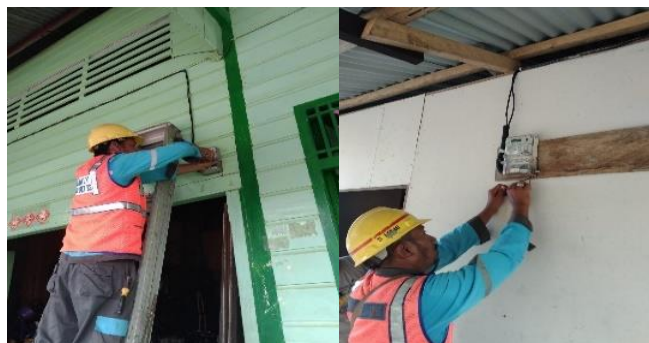
Gambar 2. 31 Mengganti MCB Sumber: (Dokumentasi Pribadi 2023)
