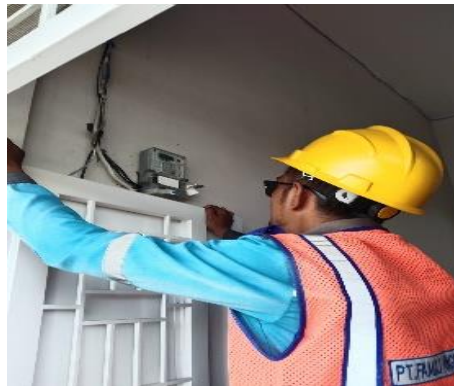
Gambar 2. 41 Mengatasi Gangguan Listrik Sumber: (Dokumentasi Pribadi 2023)
