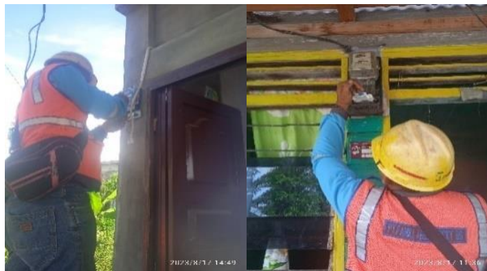
Gambar 2. 51 Mengganti MCB Sumber: (Dokumentasi Pribadi 2023)
