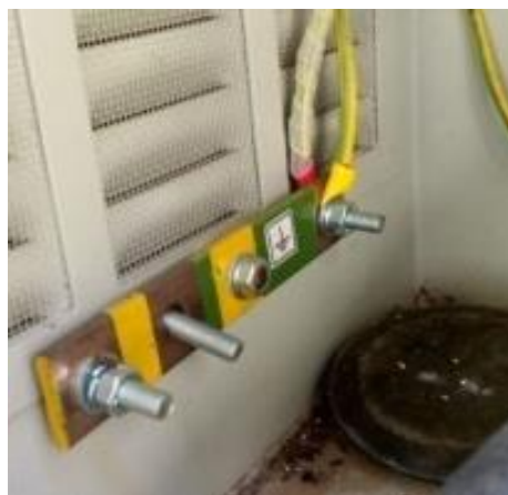
Gambar 3. 5 Sistem Pentanahan Sumber: (Dokumentasi Pribadi 2023)
