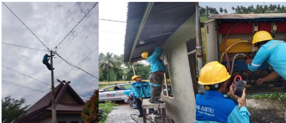
Gambar 2. 5 Perbaikan Kabel SR Dan Pengecekan Tegangan Sumber: (Dokumentasi Pribadi 2023)
