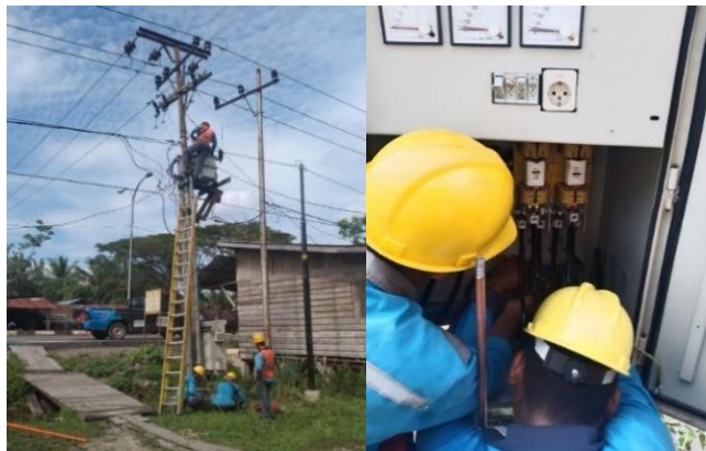
Gambar 2. 3 Pemeliharaan PHB Sumber: (Dokumentasi Pribadi 2023)
