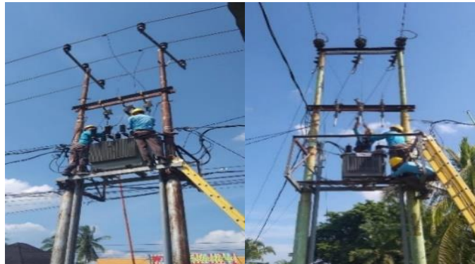
Gambar 2. 6 Penggantian LA Dan Pemasangan Grounding Pada gardu Sumber: (Dokumentasi Pribadi 2023)
