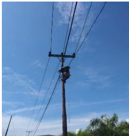
Gambar 2. 16 Pemasangan Payung Seng Sumber: (Dokumentasi Pribadi 2023)
