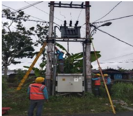
Gambar 2. 44 Pemeliharaan PHB-TR Sumber: (Dokumentasi Pribadi 2023)
