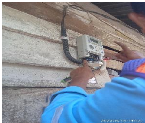
Gambar 2. 52 Mengganti MCB Sumber: (Dokumentasi Pribadi 2023)
