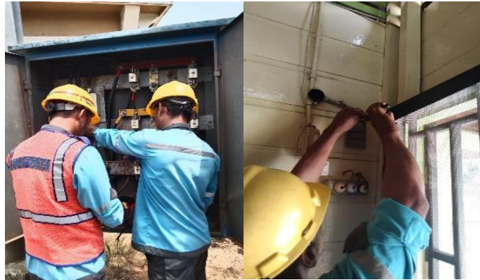
Gambar 2. 36 Pengecekan Tegangan Dan Mengganti MCB Sumber: (Dokumentasi Pribadi 2023)
