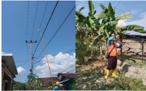
Gambar 2. 12 Mengatasi Gangguan Listrik Sumber: (Dokumentasi Pribadi 2023)
