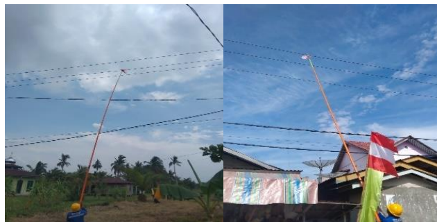
Gambar 2. 49 Pemeliharaan JTM Sumber: (Dokumentasi Pribadi 2023)
