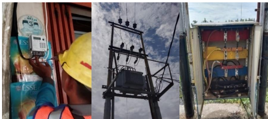
Gambar 2. 7 Mengganti MCB Dan Mengganti FCO Sumber: (Dokumentasi Pribadi 2023)
