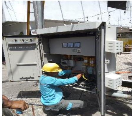
Gambar 2. 42 Pemeliharaan PHB-TR Sumber: (Dokumentasi Pribadi 2023)
