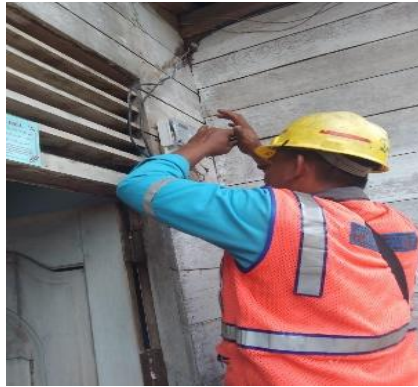
Gambar 2. 50 Mengganti KWH Meter Sumber: (Dokumentasi Pribadi 2023)
