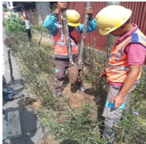
Gambar 2. 47 Menggali Lobang Sumber: (Dokumentasi Pribadi 2023)
