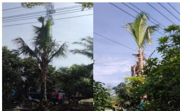
Gambar 2. 2 Pemeliharaan JTM (Jaringan Tegangan Menengah) Sumber: (Dokumentasi Pribadi 2023)
