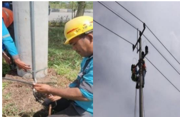
Gambar 2. 1 Pemasangan Grounding Arrester Sumber: (Dokumentasi Pribadi 2023)
