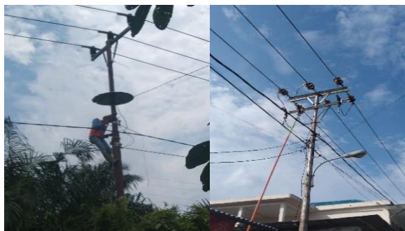
Gambar 2. 18 Mengatasi Gangguan Listrik Sumber: (Dokumentasi Pribadi 2023)
