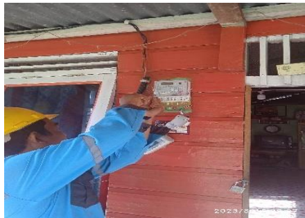
Gambar 2. 48 Mengganti KWH Meter Sumber: (Dokumentasi Pribadi 2023)
