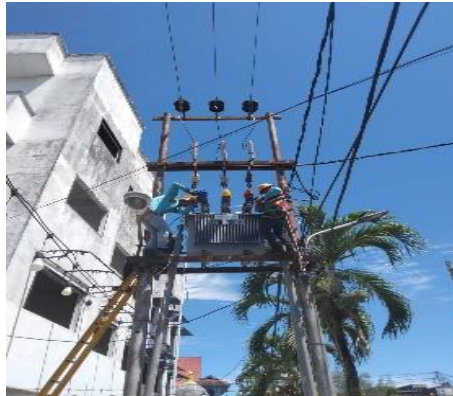
Gambar 2. 40 Pemasangan LA Sumber: (Dokumentasi Pribadi 2023)
