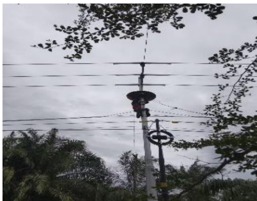
Gambar 2. 53 Pemasangan Payung Seng Sumber: (Dokumentasi Pribadi 2023)
