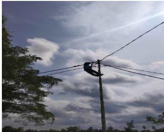
Gambar 2. 46 Mengganti Kabel SKU Sumber: (Dokumentasi Pribadi 2023)
