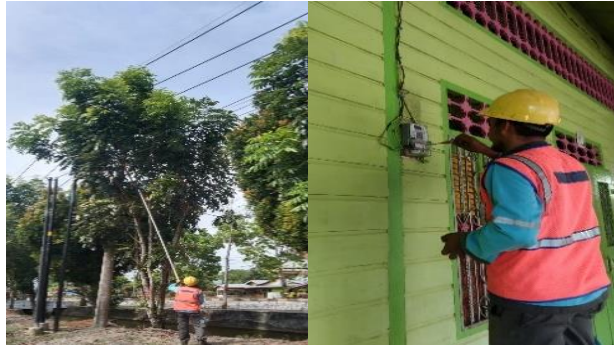
Gambar 2. 15 Mengatasi Gangguan Listrik Sumber: (Dokumentasi Pribadi 2023)
