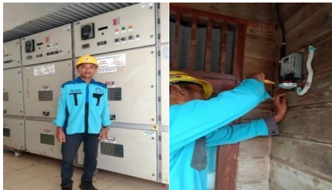
Gambar 2. 4 Pengecekan GH Dan Pemasangan MCB Sumber: (Dokumentasi Pribadi 2023)
