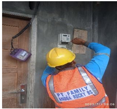
Gambar 2. 19 Mengganti KWH Meter Sumber: (Dokumentasi Pribadi 2023)
