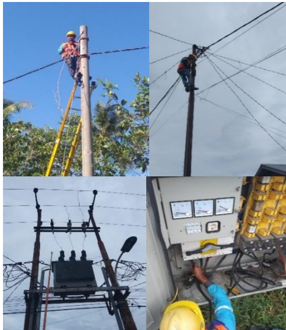
Gambar 2. 8 Pemeliharaan JTR dan Gardu Portal Sumber: (Dokumentasi Pribadi 2023)
