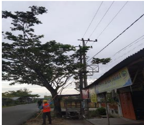
Gambar 2. 30 Pemeliharaan JTM Sumber: (Dokumentasi Pribadi 2023)
