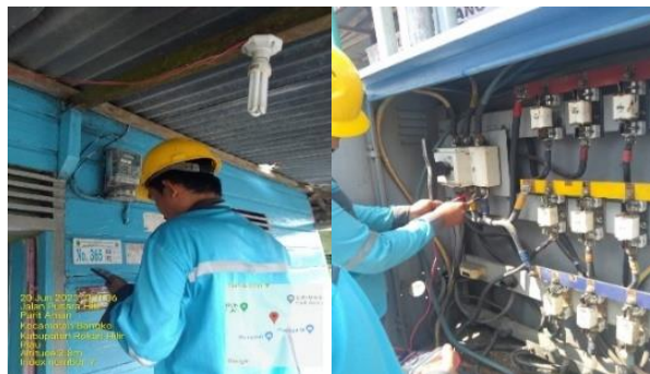
Gambar 2. 11 Mengatasi Gangguan Listrik Sumber: (Dokumentasi Pribadi 2023)
