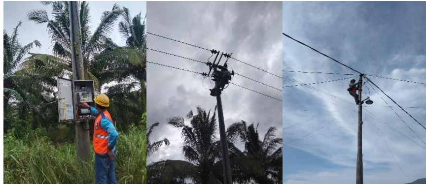
Gambar 2. 14 Mengatasi Gangguan Listrik Sumber: (Dokumentasi Pribadi 2023)
