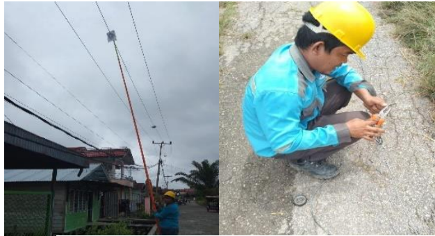
Gambar 2. 17 Mengatasi Gangguan Listrik Sumber: (Dokumentasi Pribadi 2023)
