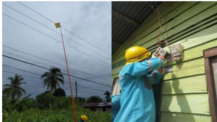
Gambar 2. 27 Mengganti KWH meter Sumber: (Dokumentasi Pribadi 2023)
