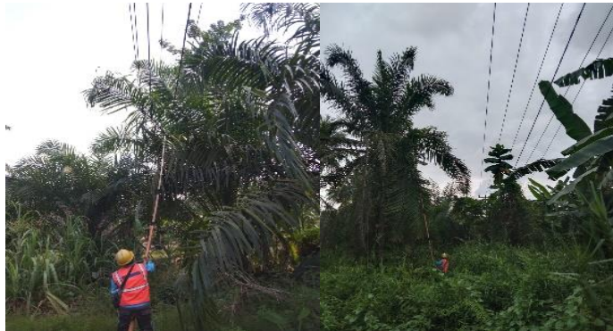
Gambar 2. 54 Pemeliharaan JTM Sumber: (Dokumentasi Pribadi 2023)
