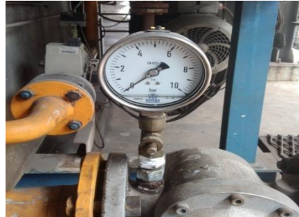
Gambar 2. 3 pemasangan pressure
