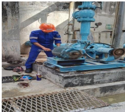
Gambar 2. 1 Perbaikan motor induksi 3phasa
