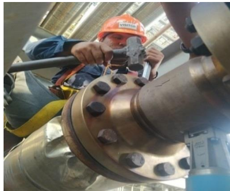
Gambar 2. 5perbaikan flowmeter
