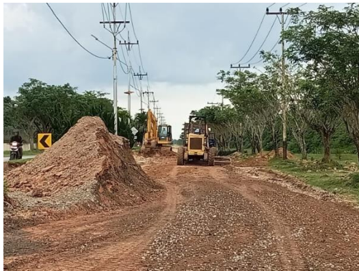
Gambar 3.1 Penghamparan Base B dengan Motor Grader
