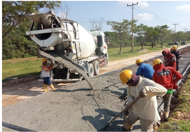
Gambar 3.9 Pekerjaan Concrete Vibro Pada Rigid
