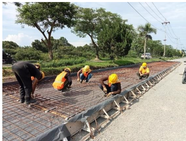
Gambar 3.6 Pekerja Merakit Tulangan.
