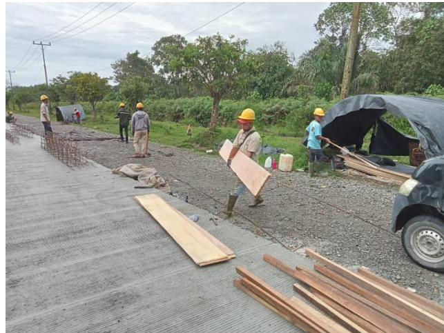
Gambar 3.3 Pekerjaan Pembuatan Bekisting.
