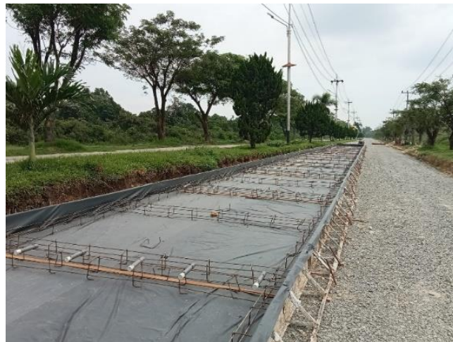
Gambar 3.5 Perakitan Tulangan Dudukan dan Tul Tie Bar.
