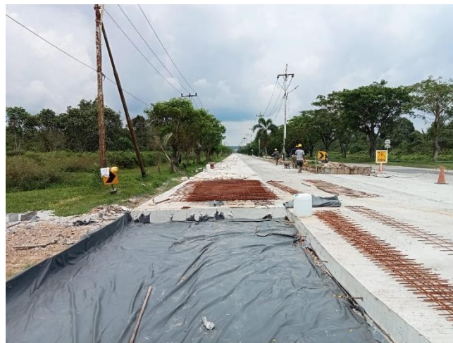
Gambar 3.4 Pekerjaan Pemberian Alas Plastik
