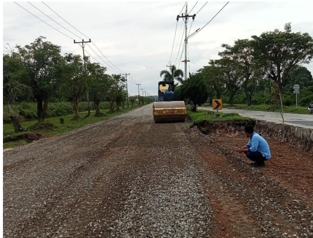
Gambar 3.2 Pemadatan Base B dengan Vibrator Roller
