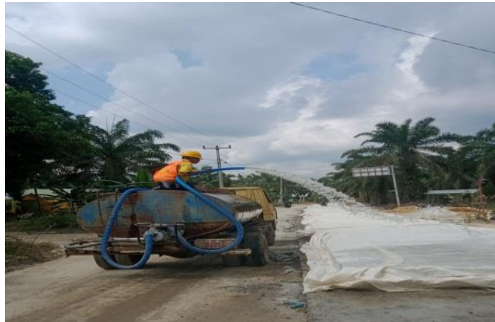
Gambar 3.9 Proses Curing Pada Rigid
