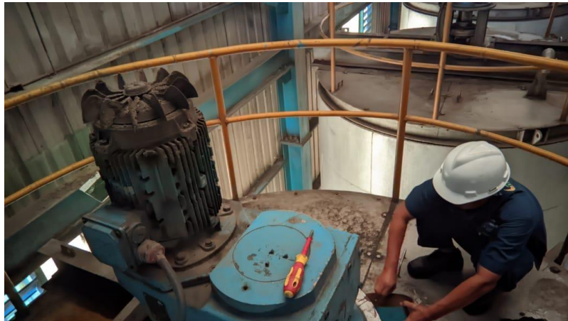
Gambar 2.17 Proses cleaning motor Sumber: (Dokumentasi, 2023)
