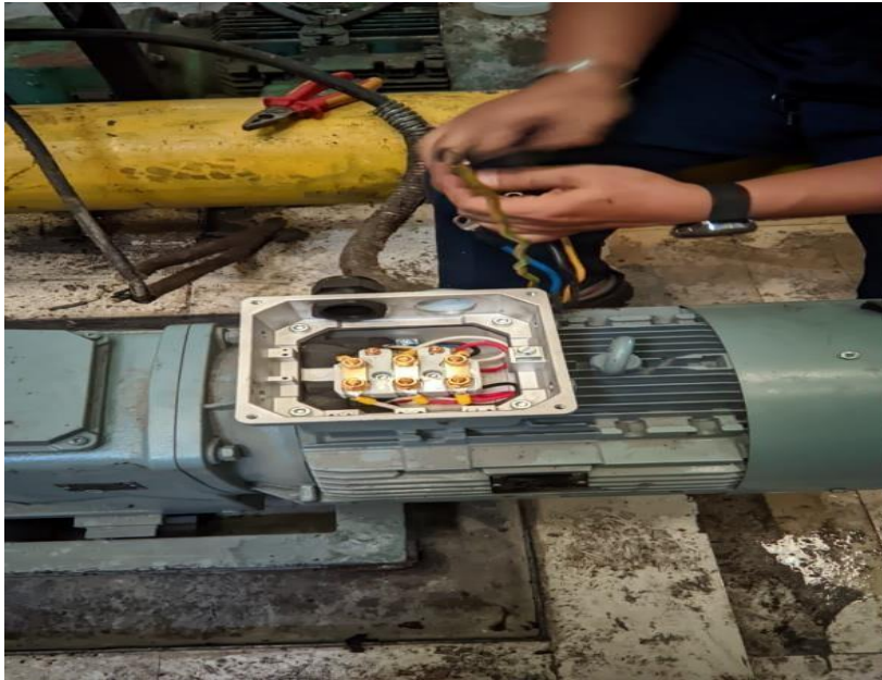
Gambar 2.11 Pengkoneksian rangkain delta pada motor Sumber: (Dokumentasi, 2023)
