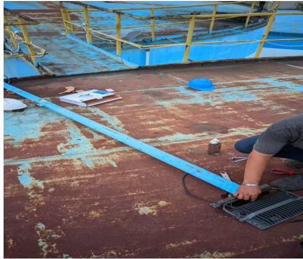
Gambar 2.9 Pemasangan lighting area tankfarm TK26 Sumber: (Dokumentasi, 2023)
