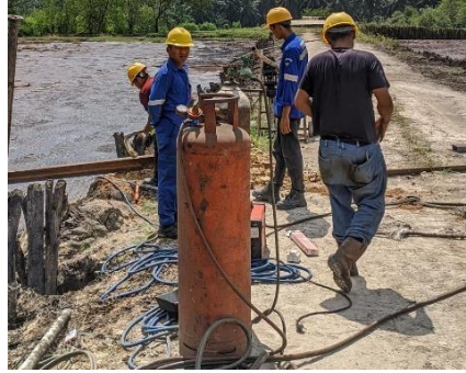
Gambar 2. 15 Pemasangan pompa limbah
