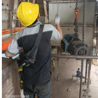
Gambar 2. 28 Mengkatrol dan mengganti elmot
