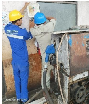
Gambar 2. 9memperbaiki arus listrik dan memasang panel kontrol
