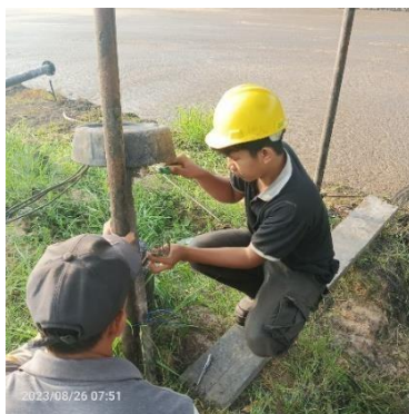
Gambar 2. 67Memasang kabel pompa limbah
