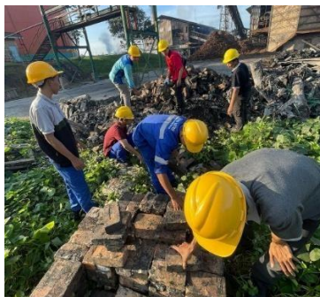
Gambar 2. 12Pemindahan batu bata bekas bongkaran boiler
