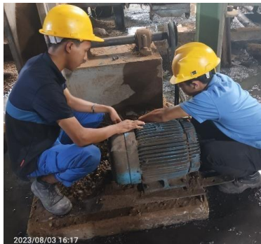
Gambar 2. 47Membongkar dan mengganti elmot
