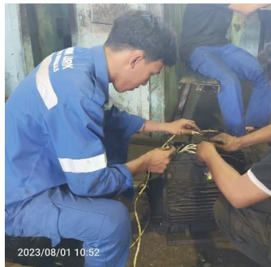
Gambar 2. 45Mengcouple/merakit elmot
