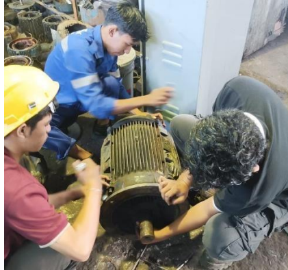
Gambar 2. 50Mengcouple/merakit elmot
