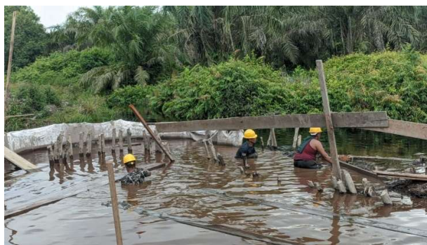
Gambar 3.5 Proses Perbaikan Bendungan (Sumber : Dokumentasi Lapangan)
