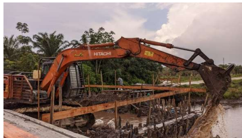
Gambar 4.1 Pengurasan Air Dalam Bendungan (Sumber : Dokumentasi Lapangan)
