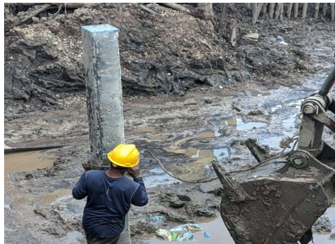
Gambar 4.4 Pelepasan Clamp Sling Dari Tiang Pancang Oleh Kepala Tukang (Sumber : Dokumentasi Lapangan)
