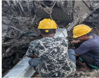
Gambar 4.2 Pemasangan Clamp Sling Oleh Tukang (Sumber : Dokumentasi Lapangan)
