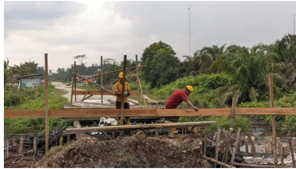
Gambar 3.3 Proses Pemasangan Bowplank (Sumber : Dokumentasi Lapangan)
