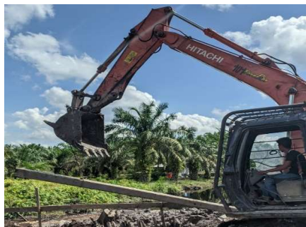
Gambar 4.3 Pemindahan Mini Pile Ke Patok Pemancangan (Sumber : Dokumentasi Lapangan)
