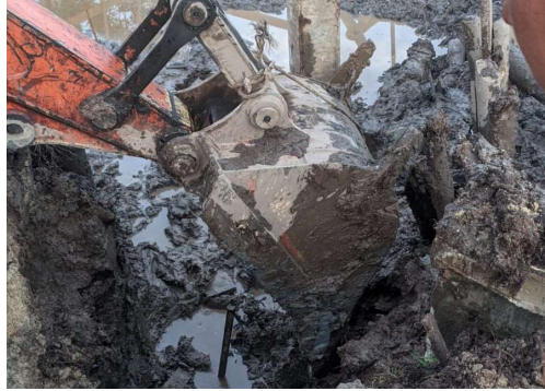
Gambar 4.5 Pemancangan Sampai Kedalaman Yang Ditentukan
