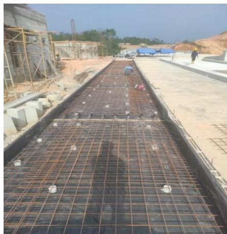
Gambar 4.4 Pemasangan Besi Wiremesh
