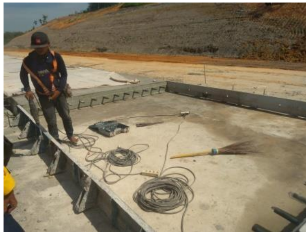
Gambar 4.2 Pemasangangan Bekisting
