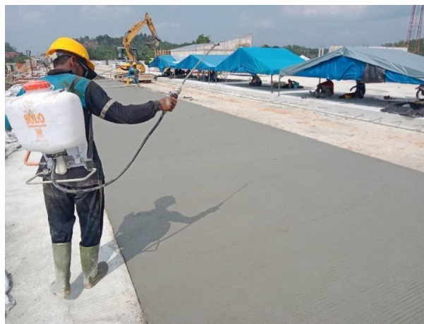
Gambar 4.14 Penyemprotan Antisol
