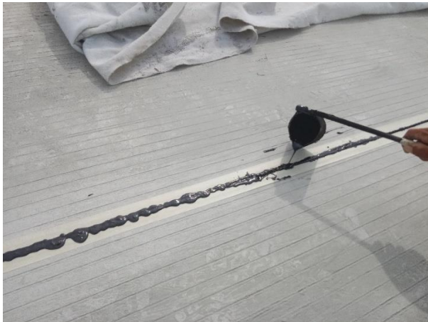
Gambar 4.18 Pekerjaan Join Sealent
