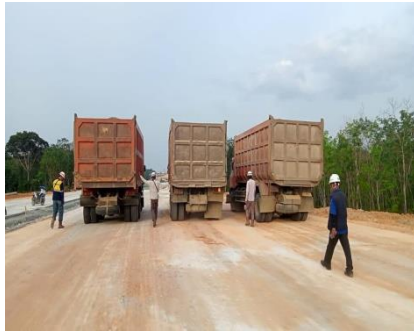
Gambar 3.8 Pengujian Pengujian Proofrolling dan CBR Lapangan
