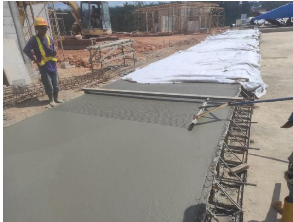
Gambar 4.13 Pekerjaan Alur Groving
