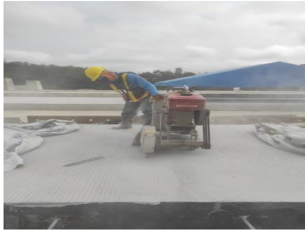
Gambar 4.16 Pekerjaan Cutting
