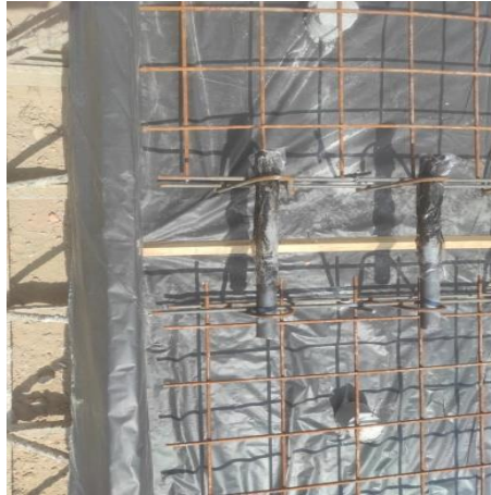
Gambar 4.5 Pemasangan Besi Dowel
