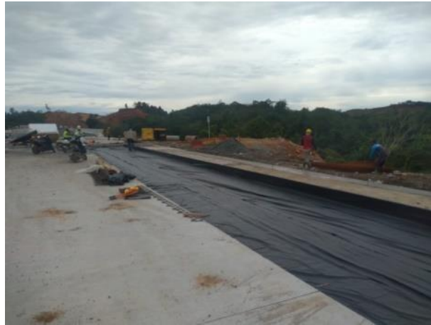
Gambar 4.3 Pemasangan Plastik Cor
