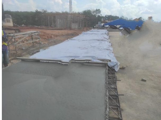
Gambar 4.15 Penggunaan Geotextile Non Woven
