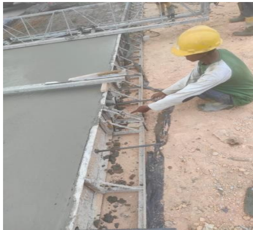
Gambar 4.6 Pemasangan Besi Tie Bar
