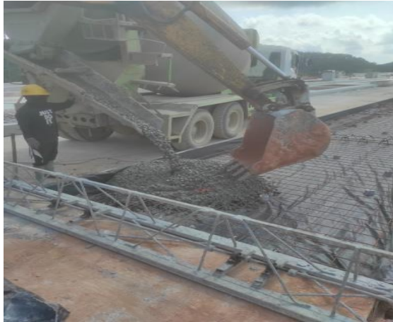
Gambar 4.9 Penuangan Beton Segar
