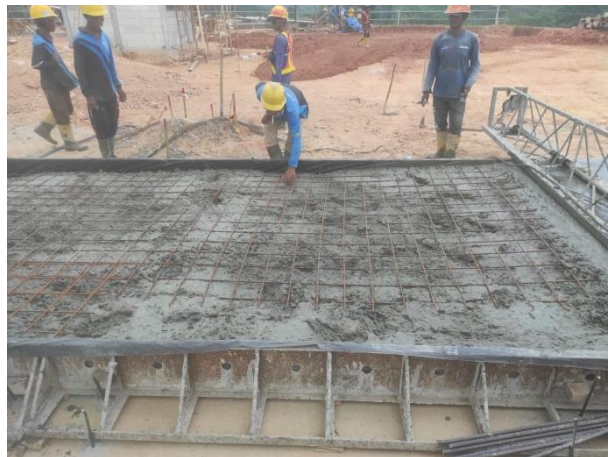
Gambar 4.10 Pemasangan Besi Wiremesh
