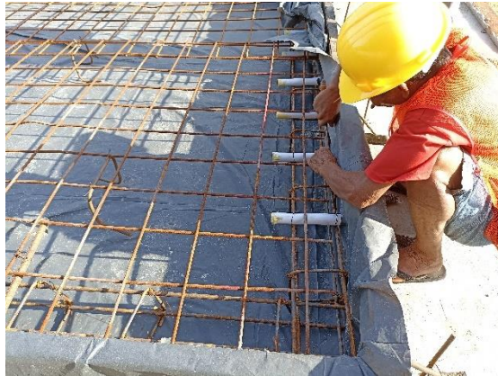
Gambar 4.4 Pemasangan Dowel (Sumber: Dokumentasi Lapangan)
