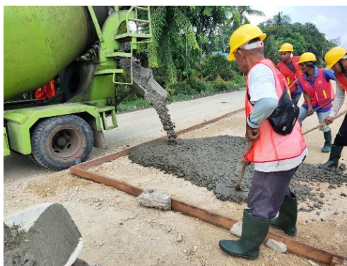
Gambar 3.5 Pekerjaan Pengecoran Lantai Kerja
