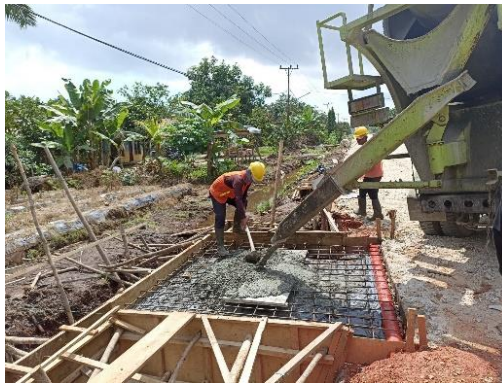
Gambar 3.1 Pekerjaan Box Culvert
