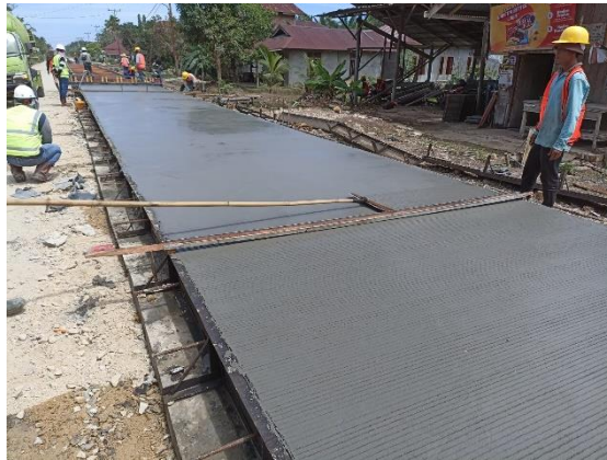
Gambar 4.11 Pekerjaan Grooving (Sumber: Dokumentasi Lapangan)
