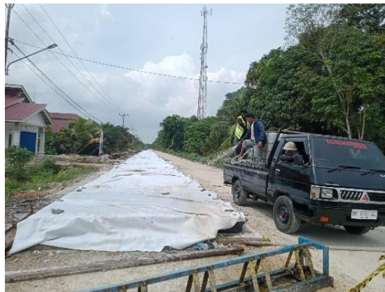
Gambar 3.11 Pekerjaan Penyiraman Rigid (Sumber: Dokumentasi Lapangan)
