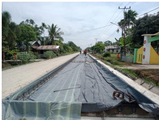
Gambar 4.2 Pemasangan Pelapis Anti Bocor
