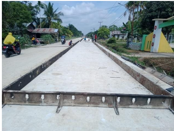
Gambar 4.1 Pemasangan Mal
