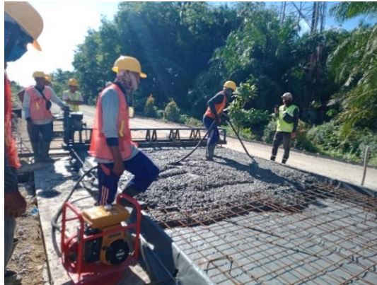
Gambar 4.9 Penggunaan Concrete Vibrator (Sumber: Dokumentasi Lapangan)
