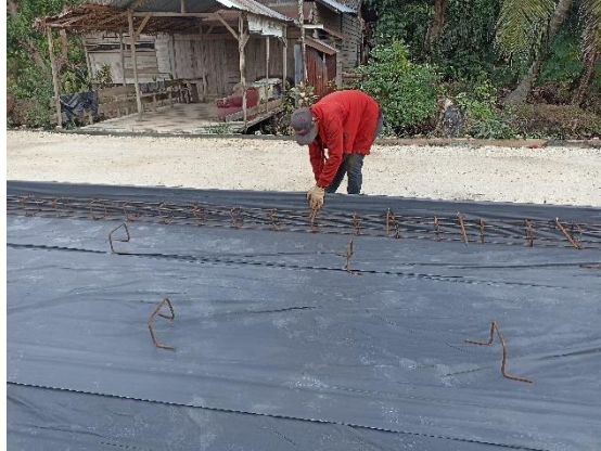
Gambar 4.3 Pemasangan Tulangan Bangku
