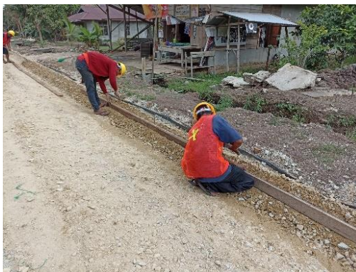
Gambar 3.4 Pemasangan Mal Untuk Lantai Kerja
