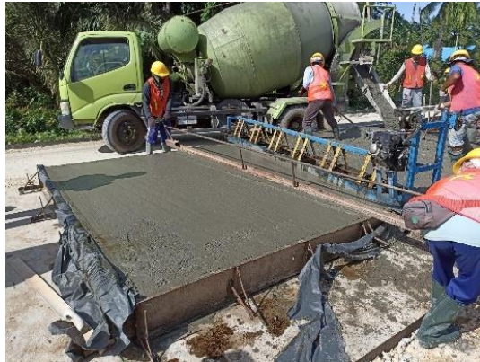
Gambar 3.8 Pekerjaan Pengecoran Rigid
