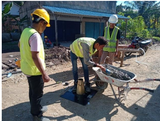
Gambar 4.7 Pengujian Slump (Sumber: Dokumentasi Lapangan)
