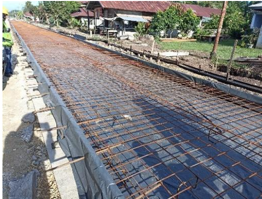
Gambar 3.7 Pekerjaan Pemasangan Tulangan Rigid
