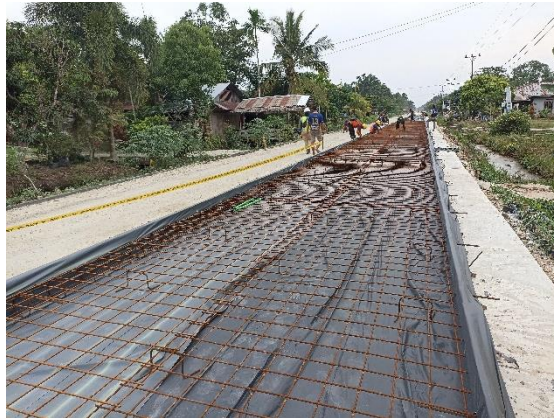
Gambar 4.6 Wiremesh Yang Telah Terpasang
