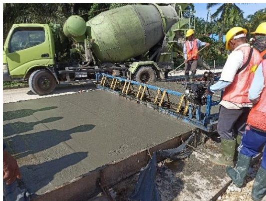
Gambar 4.10 Penggunaan Concrete Truss Screenshot (Sumber: Dokumentasi Lapangan)
