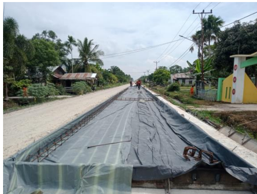
Gambar 3.6 Pemasangan Mal Dan Waterproofing Membrane
