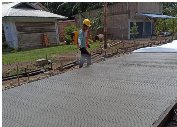
Gambar 4.12 Penyemprotan Curing Compound (Sumber: Dokumentasi Lapangan)
