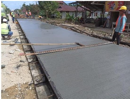
Gambar 3.9 Pekerjaan Grooving
