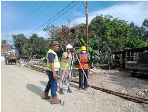
Gambar 3.3 Pengukuran Elevasi Untuk Lantai Kerja
