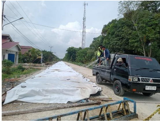
Gambar 4.13 Penyiraman Menggunakan Water Tank (Sumber: Dokumentasi Lapangan)
