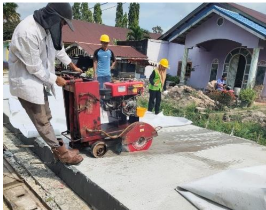
Gambar 4.14 Pemotongan Rigid (Sumber: Dokumentasi Lapangan)
