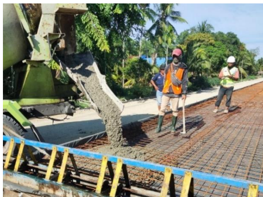
Gambar 4.8 Penghamparan Beton (Sumber: Dokumentasi Lapangan)
