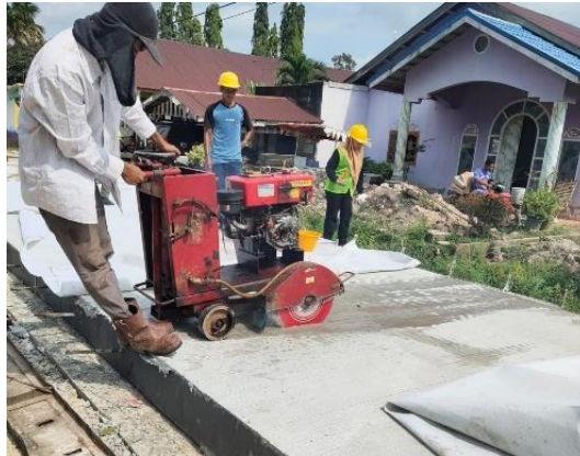
Gambar 3.10 Pekerjaan Cutting (Sumber: Dokumentasi Lapangan)
