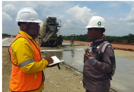
Gambar 3. 8 Dokumentasi [pekerjaan lean concrete
