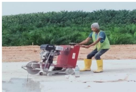
Gambar 3. 17 pemotong segmen pada beton
