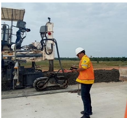
Gambar 3. 11 pekerjaan perkerasan beton menggunakan alat wirgen
