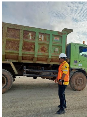
Gambar 3. 7 pekerjaan uji vroof roling
