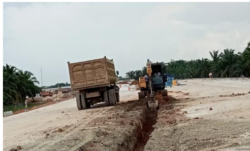
Gambar 4. 11 pekerjaan galian untuk ds-3
