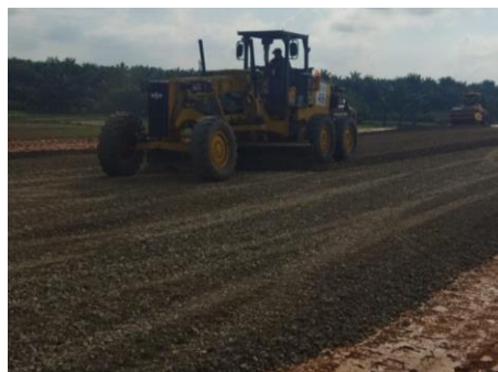
Gambar 3. 5 Proses pekerjaan penghamparan LD
