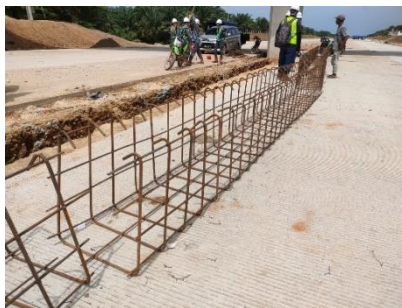
Gambar 4. 12 proses pekerjaan penulangan
