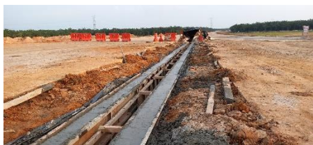
Gambar 4. 20 proses pelepasan bekisting
