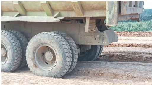
Gambar 3. 3 uji vroof roling top subgrade (sumber : Dokumentasi Lapangan,2023)
