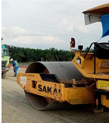
Gambar 3. 6 Pekerjaan pemadatan LD
