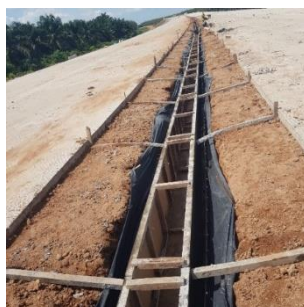
Gambar 4. 16 proses pemasangan bekisting
