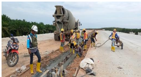
Gambar 4. 19 proses pengecoran dinding ds -3
