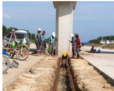
Gambar 4. 10 proses pekerjaan join survey
