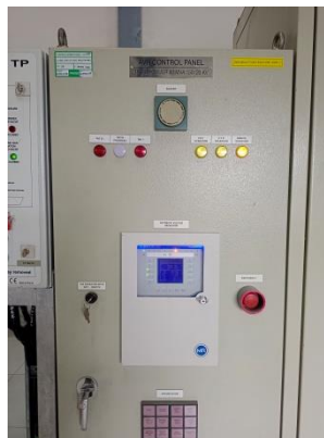
Gambar 2. 19 Automatic Voltage Regulator (sumber :dokumentasi penulis)
