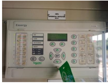
Gambar 2. 24 Differential Relay (sumber :dokumentasi penulis)
