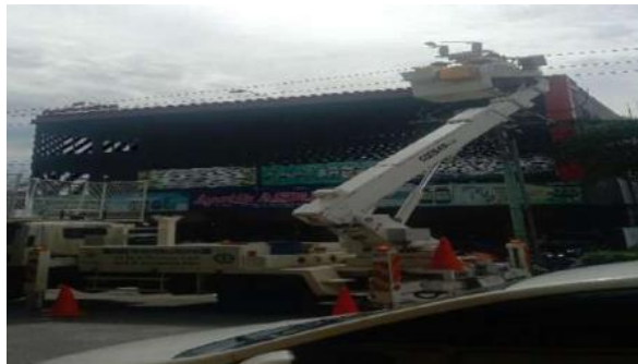
Gambar 2.36 Pemasangan LBS Sumber: Dokumentasi, 2022
