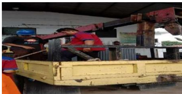
Gambar 2.13 Pembongkaran Trafo Sumber: Dokumentasi, 2022
