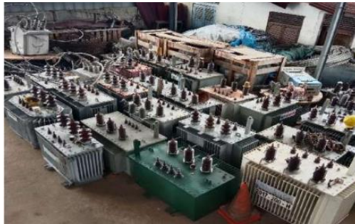
Gambar 2.21 Pembongkaran Trafo Sumber: Dokumentasi, 2022
