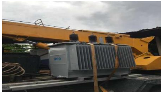
Gambar 2.2 Penggantian Trafo Sumber: Dokumentasi, 2022
