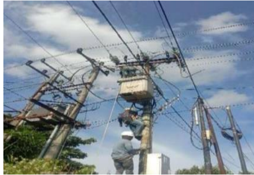
Gambar 2.11 Penggantian Trafo Sumber: Dokumentasi, 2022
