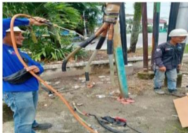
Gambar 2.34 Jointing Kabel Sumber: Dokumentasi, 2022
