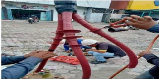
Gambar 2.8 Pemasangan SCADA Sumber: Dokumentasi, 2022
