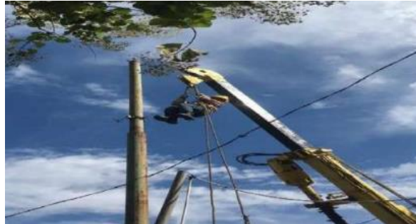
Gambar 2.23 Pemasangan Kabel TM Sumber: Dokumentasi, 2022
