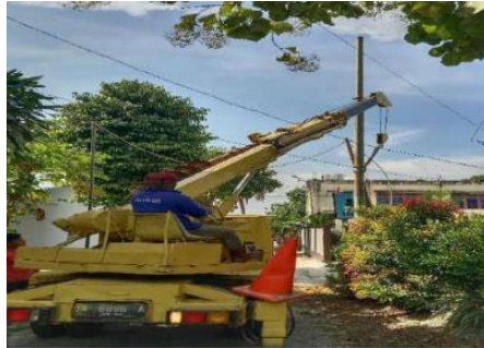
Gambar 2.30 Pemasangan Tiang PLN Sumber: Dokumentasi, 2022
