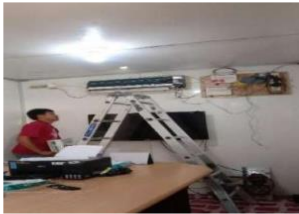
Gambar 2.9 Perbaikan AC Sumber: Dokumentasi, 2022
