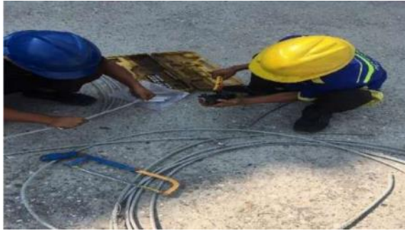
Gambar 2.20 Pemotongan Kabel Konduktor Tembaga Sumber: Dokumentasi, 2022
