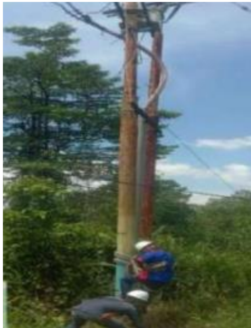
Gambar 2.7 Perbaiki Gangguan Kabel TM Sumber: Dokumentasi, 2022
