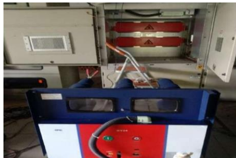
Gambar 2.22 Pemeliharaan Kubikel Sumber: Dokumentasi, 2022
