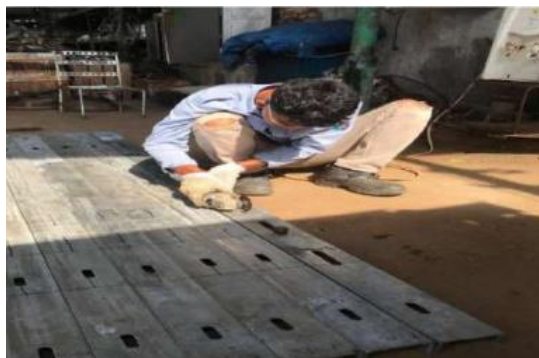
Gambar 2.25 Pemotongan Tumpuan Trafo Sumber: Dokumentasi, 2022
