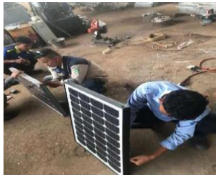
Gambar 2.31 Pemasangan Tapak Solar Cell Sumber: Dokumentasi, 2022
