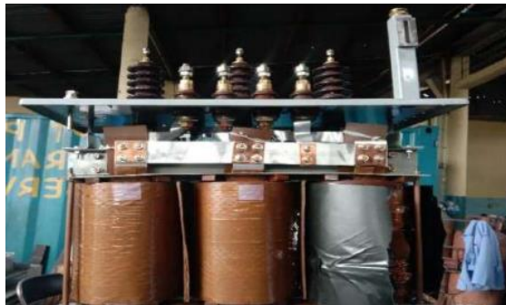
Gambar 2.24 Perbaiki Trafo Sumber: Dokumentasi, 2022
