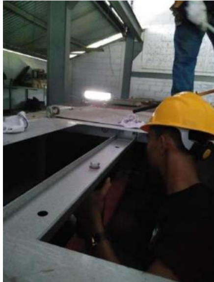
Gambar 2.4 Perawatan dan Perbaikan Kubikel Sumber: Dokumentasi, 2022
