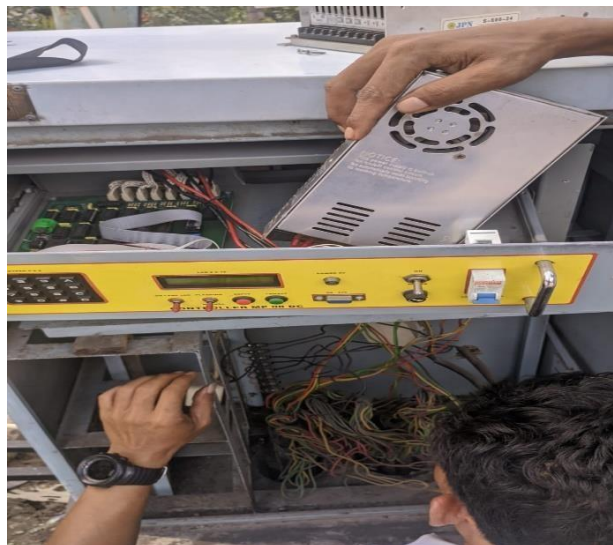
Gambar 3.2 Pemasangan Power Suplay
