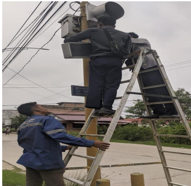
Gambar 3.5 Pemasangan Lampu Warning Light
