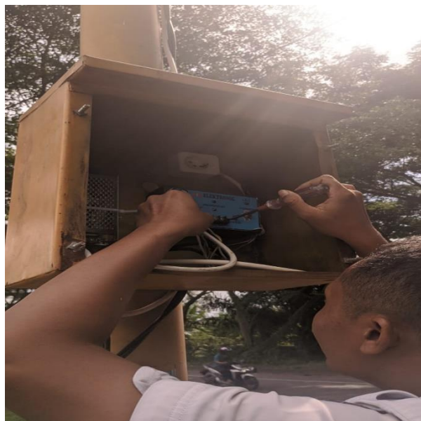
Gambar 3.6 Penggantian Control Dan Power Suplay
