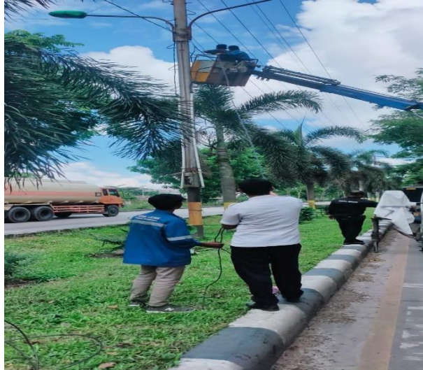
Gambar 3.1 Pemasangan Kabel Twister
