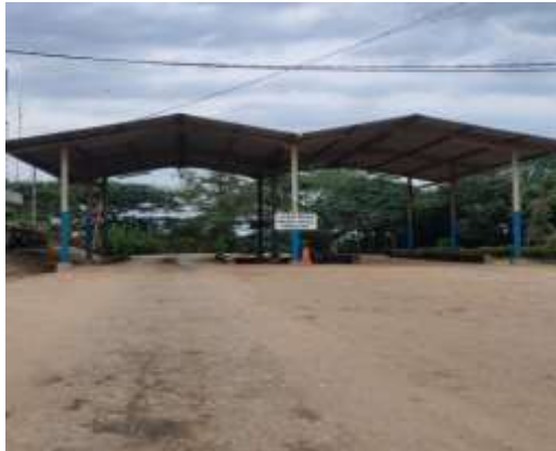
Gambar 2. 2 Jembatan Timbangan Sumber (Dokumentasi 2023)
