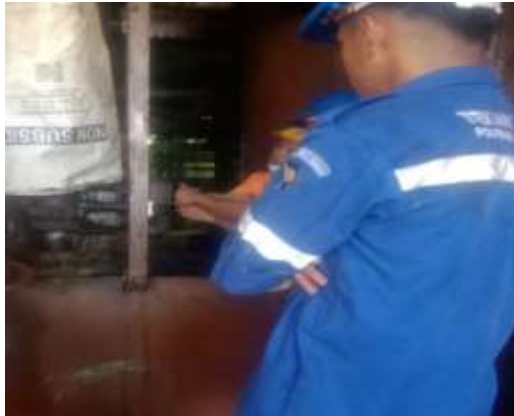
Gambar 2. 35 Pemasangan sensor di oil Tank Sumber Dokumentasi 2023
