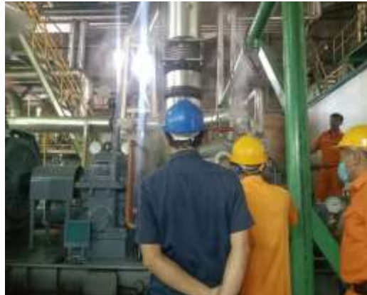
Gambar 2. 41 Pengoperasian awal Turbin setelah Maintenance Sumber Dokumentasi 2023
