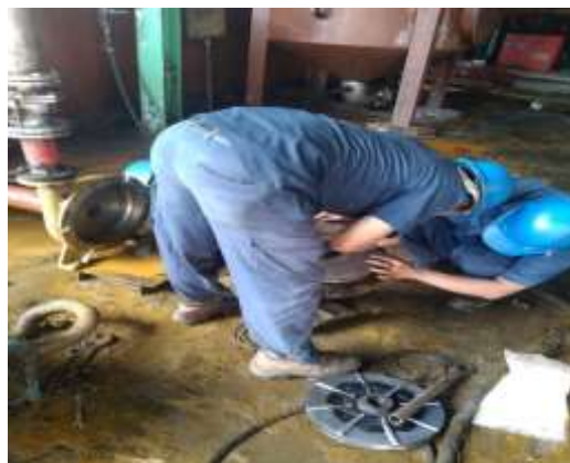
Gambar 2. 34 Perbaikan Pompa transfer ke storage Tank Sumber Dokumentasi 2023
