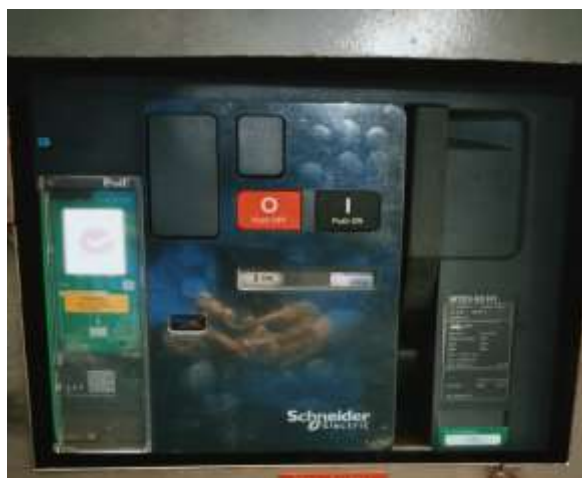
Gambar 2. 43 Pengenalan Proteksi generator Sumber Dokumentasi 2023
