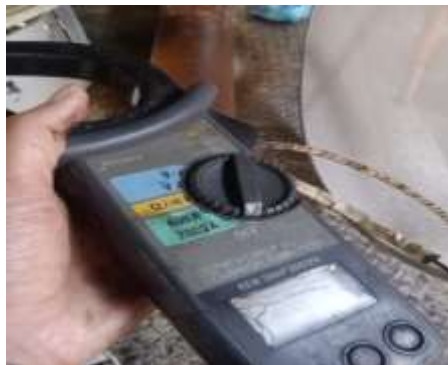
Gambar 2. 26 Pengukuran Tegangan di Panel Klarifikasi Sumber Dokumentasi
