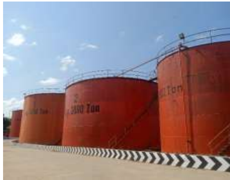
Gambar 2. 18 Storage Tank Sumber : (dokumentasi 2023)
