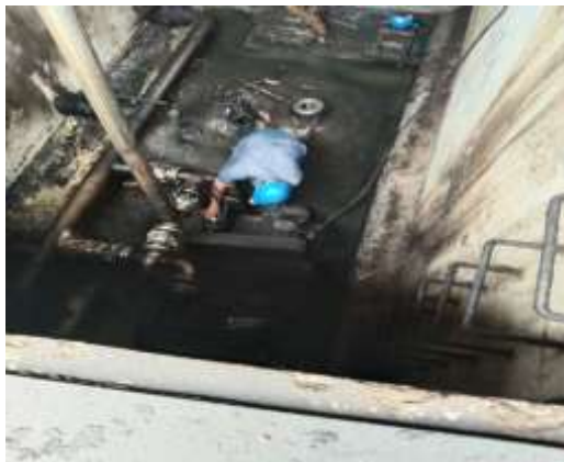
Gambar 2. 17 Membantu perbaikan Pompa Transfer Sumber Dokumentasi 2023
