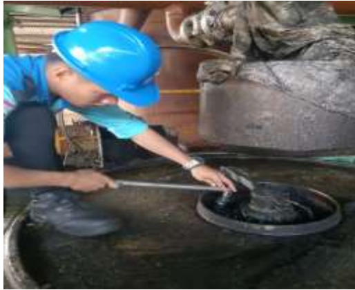
Gambar 2. 16 Perbaikan dan maintenance sweco Sumber dokumentasi 2023
