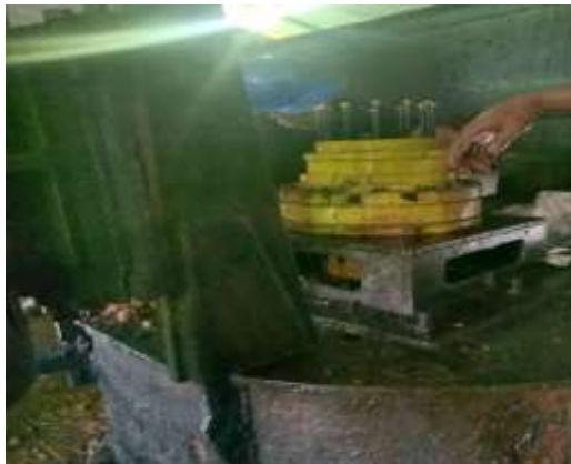
Gambar 2. 25 Perbaikan gearbox digester Sumber dokumentasi 2023
