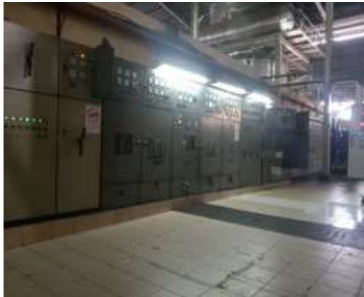
Gambar 2. 31 Monitoring di pembangkit Sumber Dokumentasi 2023
