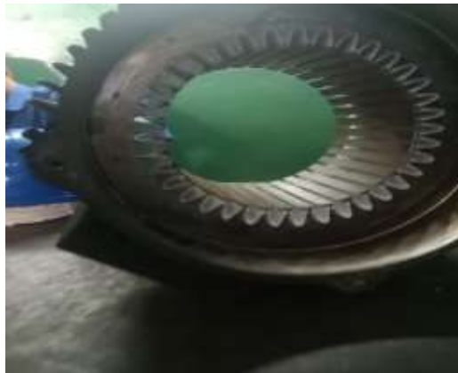
Gambar 2. 19 Rewinding Elektromotor Sumber Dokumentasi 2023
