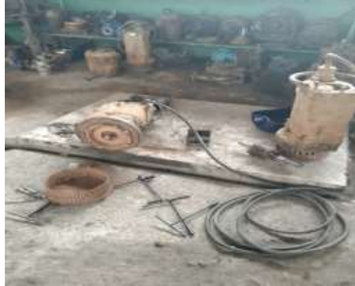
Gambar 2. 13 Perbaikan Elektromotor Sumber Dokumentasi 2023
