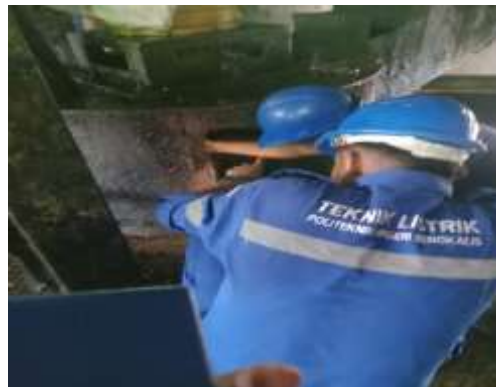
Gambar 2. 15 Perbaikan atau maintenance Digester Sumber Dokumentasi 2023
