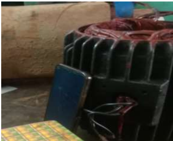
Gambar 2. 49 Perbaikan Elektromotor Sumber Dokumentasi 2023
