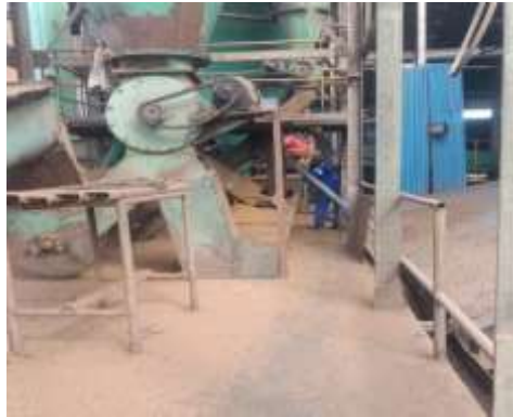
Gambar 2. 32 Mengganti elektromotor di fibre cyclone Sumber Dokumentasi 2023
