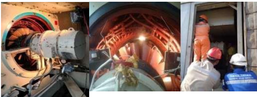
Gambar 2. 5 Pemeliharaan generator turbin (Sumber : Dokumentasi 2022)
