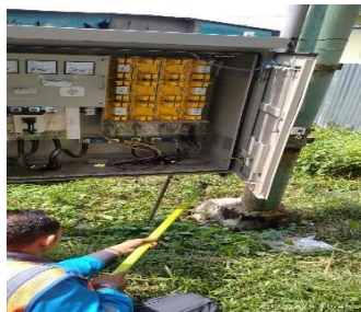
Gambar 2.4 Pembersihan Rumput Liar sekitar Panel PHB-TR (Sumber PT. Haleyora Power 2023)
