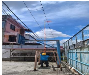
Gambar 2.2 Pembersihan Layang-layang dari Jaringan SUTM (Sumber PT. Haleyora Power 2023)
