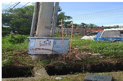
Gambar 2.18 Melakukan pemasangan grounding (Sumber PT. Haleyora Power 2023)
