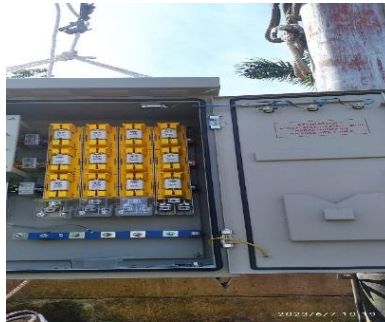
Gambar 2.3 Pengerjaan Pemasangan LS Board Panel PHB-TR (Sumber PT. Haleyora Power 2023)
