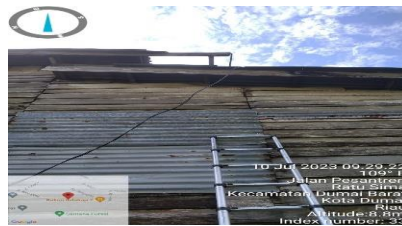
Gambar 2.23 Memperbaiki percing yang longgar kunciannya (Sumber PT. Haleyora Power 2023)
