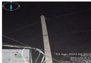
Gambar 2.53 Mengecek kondisi gangguan pada tiang tr (Sumber PT. Haleyora Power 2023)
