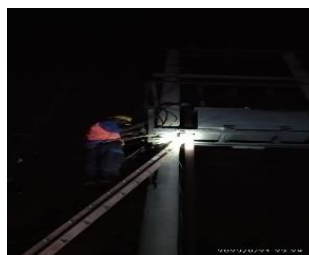
Gambar 2.51 Memperbaiki percing longgar (Sumber PT. Haleyora Power 2023)
