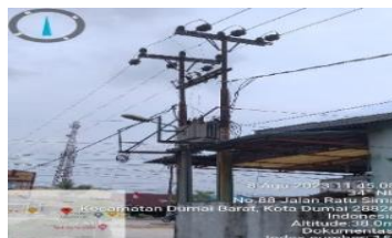
Gambar 2.43 Inpeksi Lapangan untuk mengecek kondisi trafo (Sumber PT. Haleyora Power 2023)
