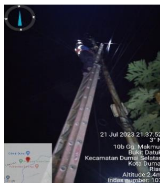
Gambar 2.32 Perbaikan percing yang longgar (Sumber PT. Haleyora Power 2023)
