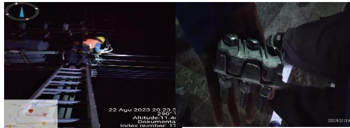
Gambar 2.52 Memperbaiki isolasi kabel outgoing (Sumber PT. Haleyora Power 2023)
