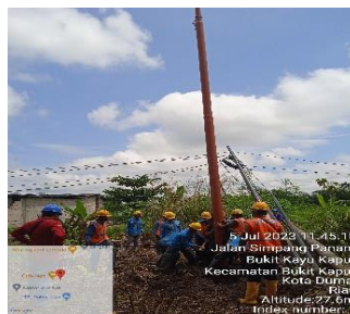
Gambar 2.20 Menegakkan tiang yang tumbang (Sumber PT. Haleyora Power 2023)
