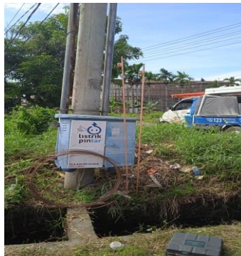
Gambar 3.4 Kawat tembaga dan Elektroda batang (Sumber Olahan Data 2023)
