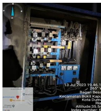
Gambar 2.26 Perbaikan Isolasi Kabel Outgoing pada jurusan 1 (Sumber PT. Haleyora Power 2023)
