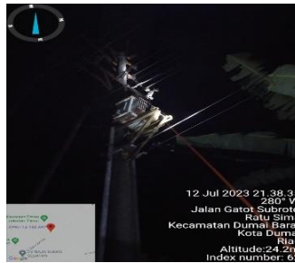
Gambar 2.25 Mengatasi Masalah gangguan Isolasi Kabel Incoming pada trafo cantol (Sumber PT. Haleyora Power 2023)
