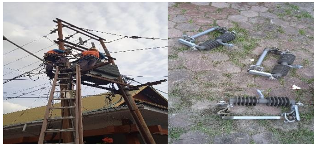
Gambar 2.16 Pemasangan FCO (Sumber PT. Haleyora Power 2023)
