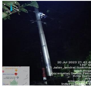
Gambar 2.31 Perbaikan kabel sktr yang terbakar dan percing yang longgar (Sumber PT. Haleyora Power 2023)
