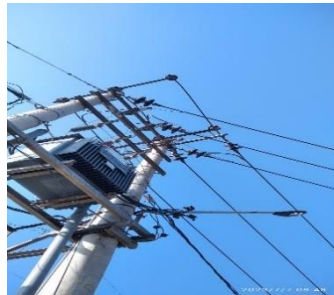
Gambar 2.22 Inpeksi lapangan pada jaringan SUTM (Sumber PT. Haleyora Power 2023)
