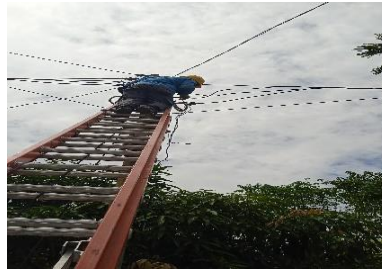
Gambar 2.14 Peyambungan kabel SR yang putus. (Sumber PT. Haleyora Power 2023)
