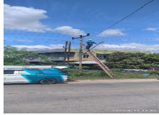
Gambar 2.11 Pemasangan Kabel SKTR jalur baru yang bersimpangan dengan jalan (Sumber PT. Haleyora Power 2023)
