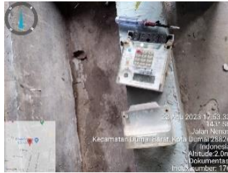
Gambar 2.54 Pemindahan Kwh meter 1 phasa (Sumber PT. Haleyora Power 2023)
