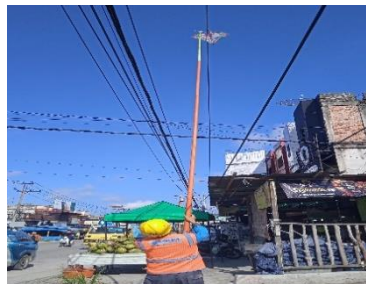
Gambar 2.15 Pengambilan layang-layang dari jaringan JTM (Sumber PT. Haleyora Power 2023)
