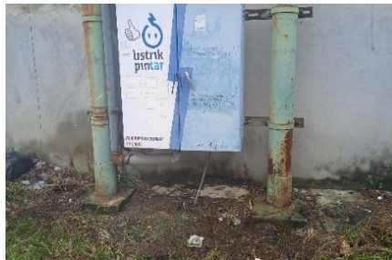
Gambar 2.17 Membersihkan rumput-rumput pada di bawah panel ls board (Sumber PT. Haleyora Power 2023)
