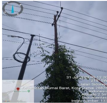
Gambar 2.38 Pembersihan tumbuhan liar yang menempel pada tiang tm 1 (Sumber PT. Haleyora Power 2023)
