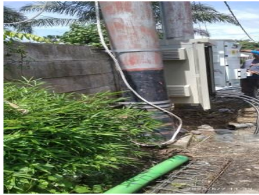
Gambar 3.3 Pengerjaan pemasangan kabel incoming ke panel phb-tr (Sumber Olahan Data 2023)
