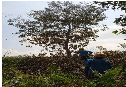
Gambar 2.12 Pemangkasan Dahan Pohon Liar (Sumber PT. Haleyora Power 2023)
