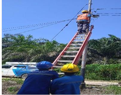
Gambar 2.8 Memperbaiki kabel Sktr yang mengalami kebocoran tegangan (Sumber PT. Haleyora Power 2023)
