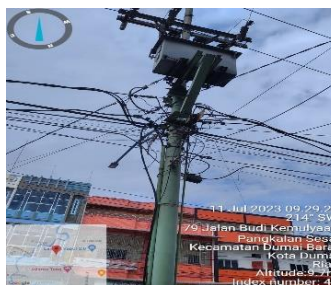
Gambar 2.24 Perbaikan percing yang longgar atau lost kontak (Sumber PT. Haleyora Power 2023)
