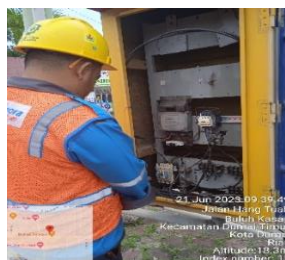
Gambar 2.13 Pengantian MCB (Sumber PT. Haleyora Power 2023)
