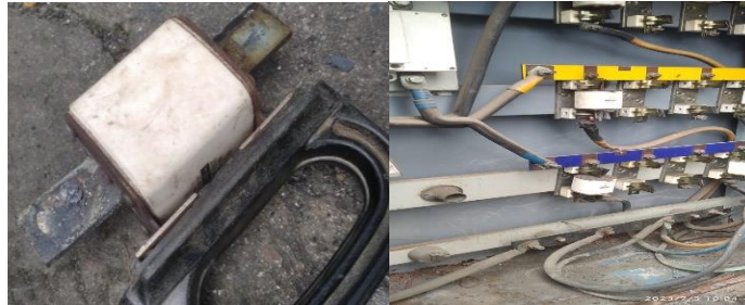
Gambar 2.19 Pergantian NH Fuse 200 A yang berapi ke NH Fuse 315 A (Sumber PT. Haleyora Power 2023)
