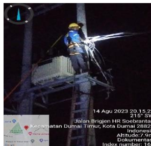
Gambar 2.47 Perbaikan kabel sktr yang tumbang (Sumber PT. Haleyora Power 2023)
