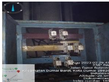
Gambar 2.49 Perbaikan fasa yang hilang pada fasa t satu jurusan (Sumber PT. Haleyora Power 2023)
