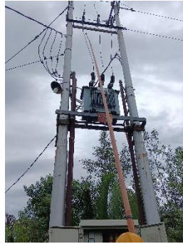
Gambar 3.2 Stick 20 KV Sumber (Dokumentasi, 2023)
