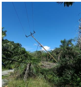
Gambar 2.2 Perbaikan Tiang Miring
