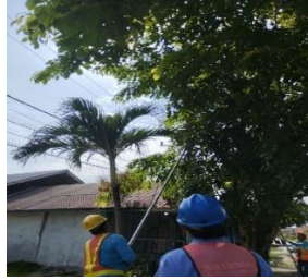
Gambar 2.6 Pemangkasan atau Pembersihan JTM di Desa Senderak Sumber: (Dokumentasi, 2023)
