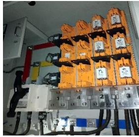
Gambar 2.34 Inspeksi Gardu Distribusi (PHBTR) di Desa Bantan Tengah Sumber: (Dokumentasi, 2023)
