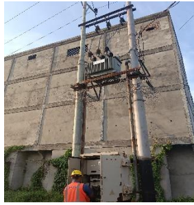
Gambar 2.30 Inspeksi Gardu Distribusi (PHBTR) di Desa Bantan Tengah Sumber: (Dokumentasi, 2023)
