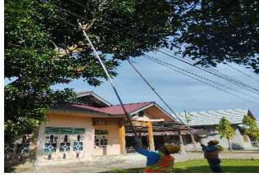
Gambar 2.8 Pemangkasan atau Pembersihan JTM di Area Pangkalan Batang Sumber: (Dokumentasi, 2023)
