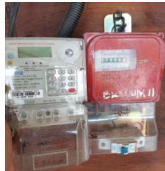
Gambar 2.18 Penggantian kWh Meter ke meter dummy di Desa Ulu Pulau Sumber: (Dokumentasi, 2023)
