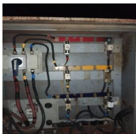
Gambar 2.19 Pergantian NH Fuse di Desa Bantan Tengah Sumber: (Dokumentasi, 2023)
