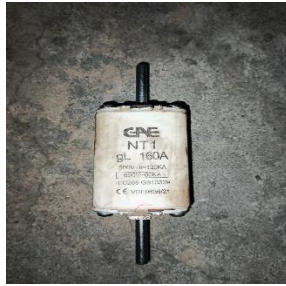
Gambar 2.32 Pergantian NH Fuse di Desa Bantan Tengah Sumber: (Dokumentasi, 2023)
