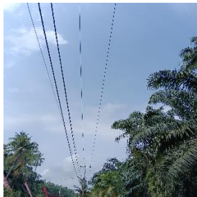
Gambar 2.31 Pemangkasan atau Pembersihan JTM di Desa Bantan Tengah Sumber: (Dokumentasi, 2023)
