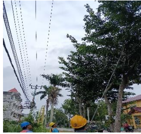
Gambar 2.12 Pemangkasan atau Pembersihan JTM di Jln Kelapapati Tengah Sumber: (Dokumentasi, 2023)
