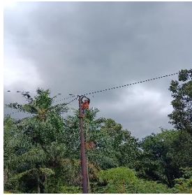
Gambar 2.36 perbaikan kabel SKU di Desa Bantan Tengah Sumber: (Dokumentasi, 2023)
