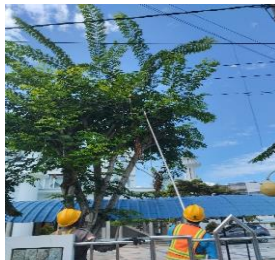
Gambar 2.9 Pemangkasan atau Pembersihan JTM di Area Pangkalan Batang Sumber: (Dokumentasi, 2023)
