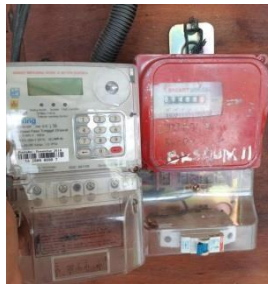
Gambar 2.7 Penggantian kWh Meter ke meter dummy di Daerah Sri Pulau Sumber: (Dokumentasi, 2023)
