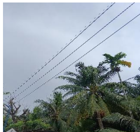
Gambar 2.13 Pemangkasan atau Pembersihan JTM di Desa Tengayun Sumber: (Dokumentasi, 2023)
