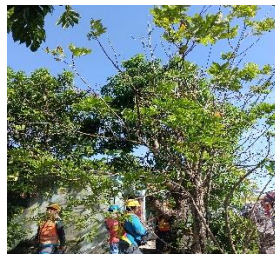
Gambar 2.11 Pemangkasan atau Pembersihan JTM di Jln Kelapapati Tengah Sumber: (Dokumentasi, 2023)
