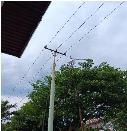
Gambar 2.15 Pemangkasan atau Pembersihan JTM di SMA N 01 Bengkalis Sumber: (Dokumentasi, 2023)
