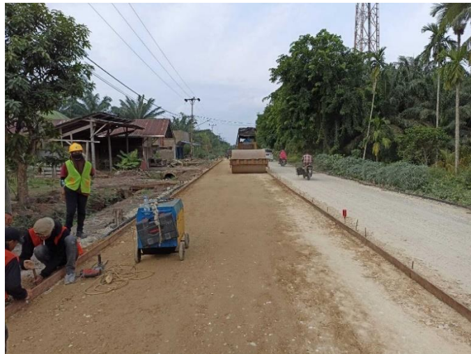
Gambar 19 Pemasangan Base B dengan Vibratory Roller
