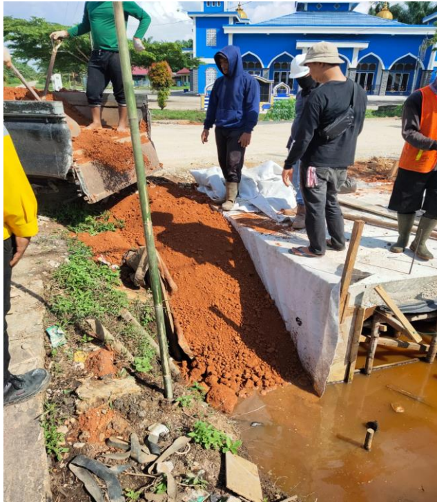
Gambar 13 Penimbunan Tanah Pilihan
