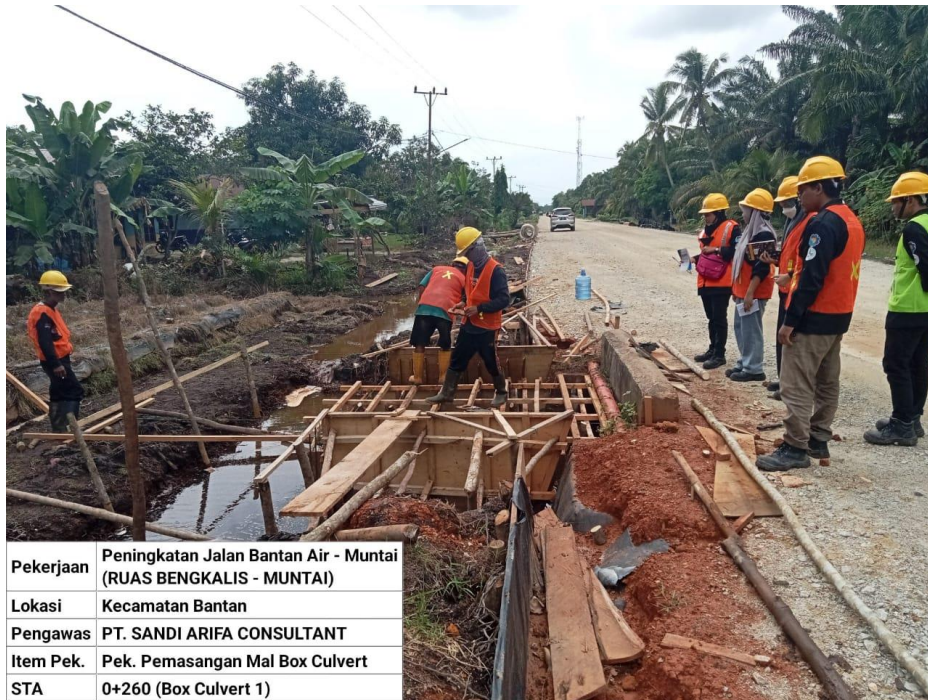
Gambar 5 Pemasangan mal Pada STA 0+260
