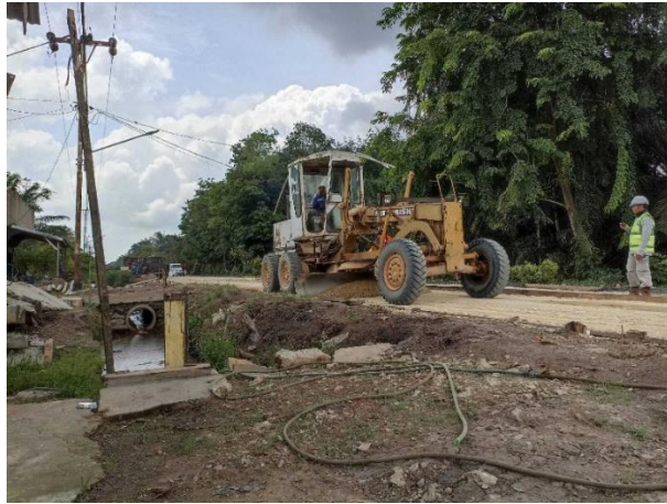
Gambar 18 Perataan Base B dengan Motor Grader
