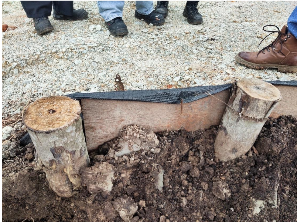
Gambar 6 Pemasangan Turap Kayu dan Geotextile
