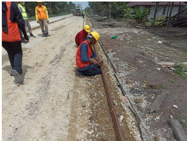
Gambar 17 Pemasangan Mal untuk Pengecoran Lantai Kerja (Lean Concrete)
