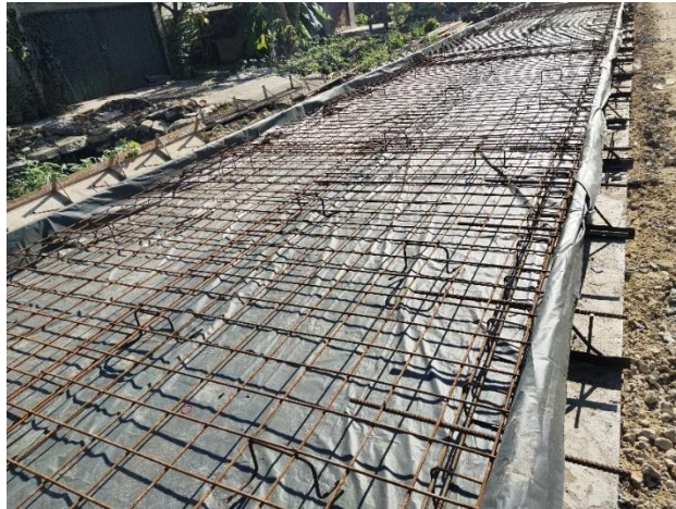
Gambar 22 Pemasangan Mal untuk Pengecoran Rigid
