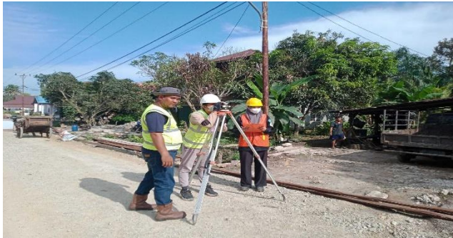
Gambar 16 Pengukuran Elevasi dengan Waterpass
