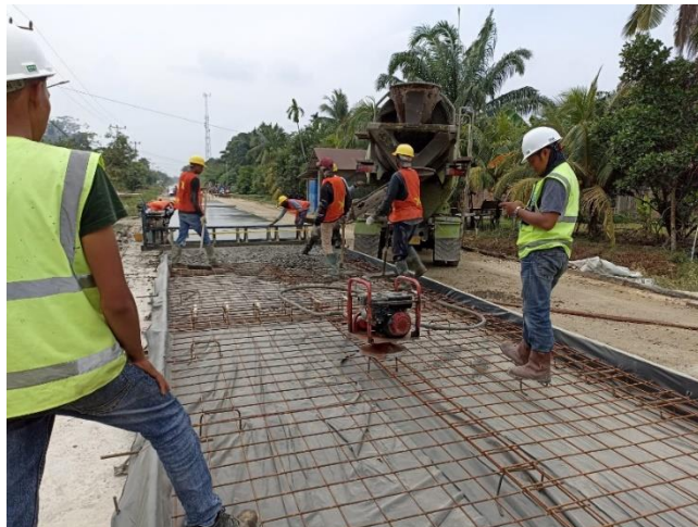
Gambar 25 Pengecoran Rigid
