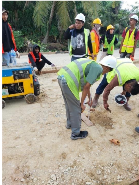
Gambar 20 Core Test pada tanah timbunan
