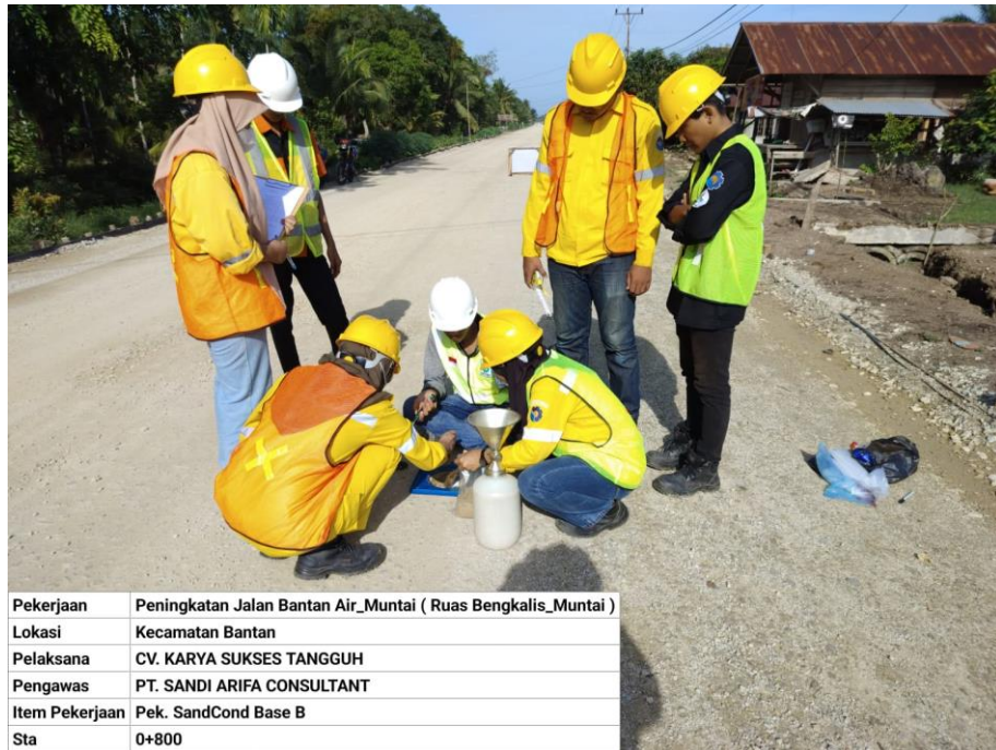
Gambar 15 Sand Cone Test pada STA 0+800
