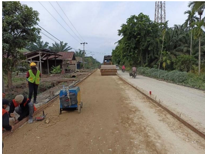
Gambar 19 Pemasatan Base B dengan Vibratory Roller
