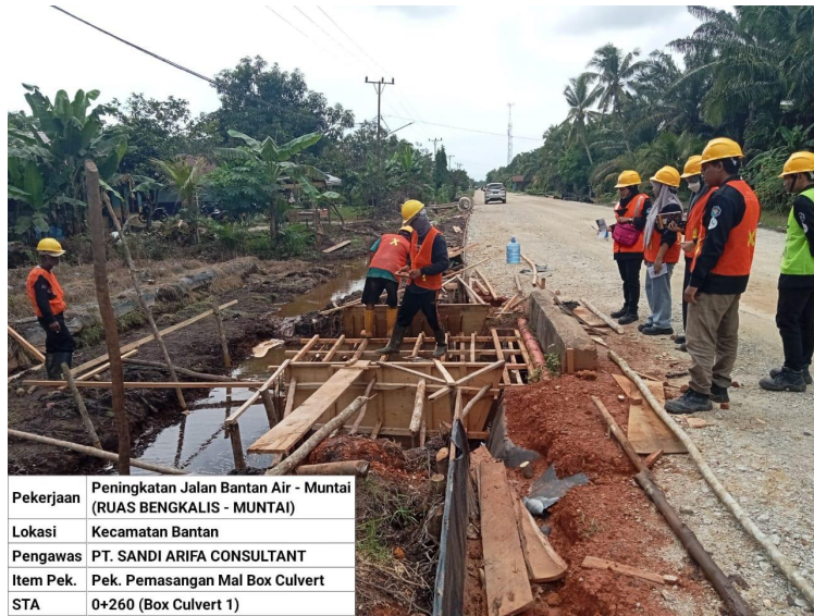
Gambar 11 Pemasangan mal box culvert
