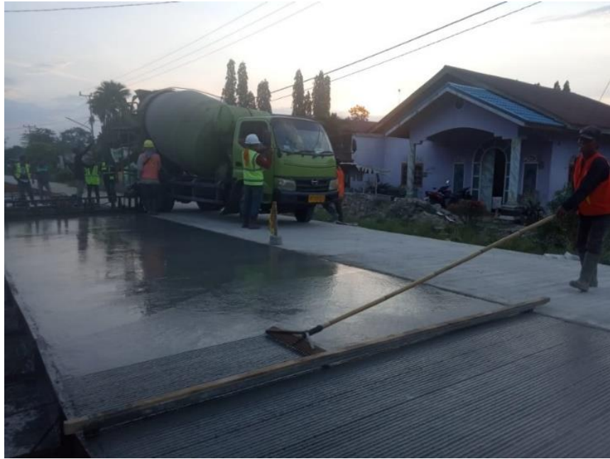
Gambar 26 Pembuatan Garis pada Hasil Cor Rigid
