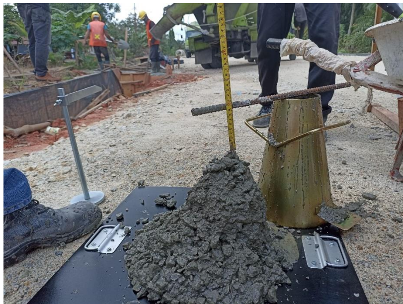
Gambar 14 Slump Test Box Culvert pada STA 0+260
