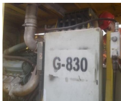
Gambar 2.3 Pemeliharaan emergency genset (Sumber : dokumentasi pribadi 2023)
