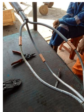
Gambar 3.17 sesudah memasang conektor (Dokumentasi pribadi 2023)
