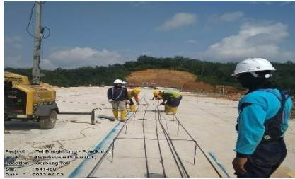
Gambar 4.1 pemasangan tulangan Sumber : Dokumentasi Kerja Praktek, 2023
