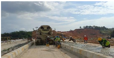
Gambar 4.4 pengecoran pulau Sumber : Dokumentasi Kerja Praktek, 2023
