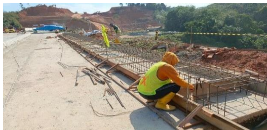
Gambar 4.2 pemasangan bakisting Sumber : Dokumentasi Kerja Praktek, 2023
