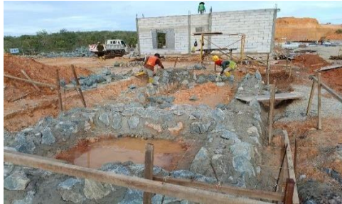
Gambar 3.2 Pembuatan Pondasi Rumah Jinset
