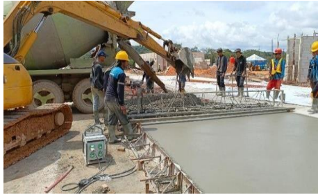
Gambar 3.1 pengecoran rigid manual
