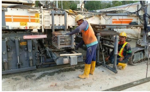
Gambar 3.3 pengecoran rigid dengan wirtgen Sumber : Dokumentasi Kerja Praktek, 2023
