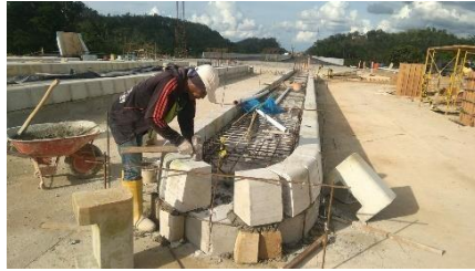
Gambar 4.3 pemasangan castin Sumber : Dokumentasi Kerja Praktek, 2023
