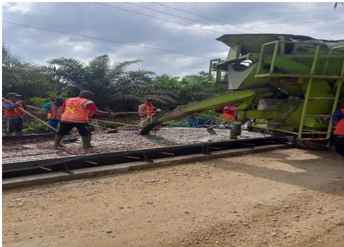
Gambar 3.15 Pemasangan Beton (Sumber : Dokumentasi Lapangan)
