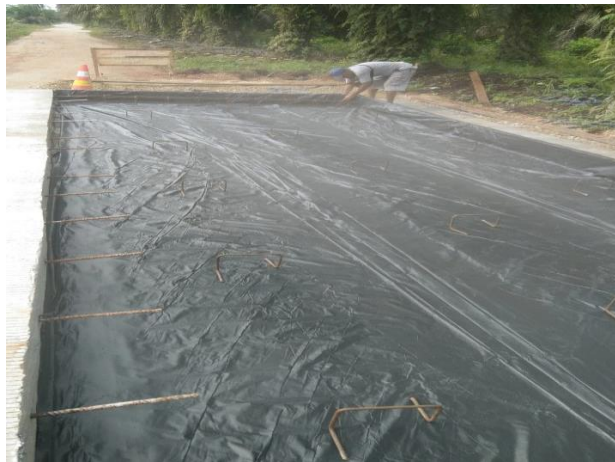
Gambar 3.24 Pemasangan Plastik alas (Sumber : Dokumentasi Lapangan)
