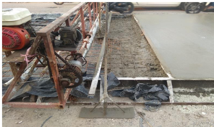
Gambar 4.11 Batas Sambungan Beton (Sumber: Dokumentasi lapangan)
