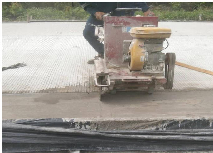
Gambar 3.21 Pemotongan Beton ( cutting ) (Sumber : Dokumentasi Lapangan)
