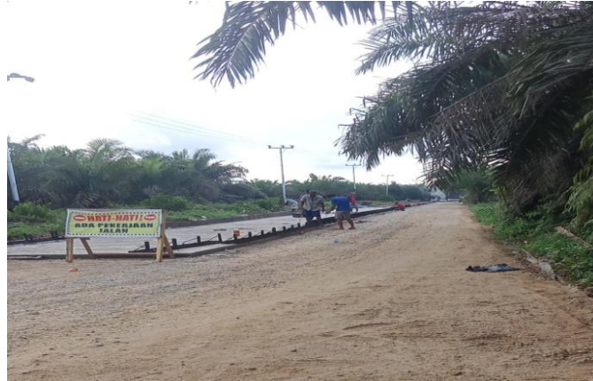
Gambar 3.8 Pemasangan Bekisting Rigid (Sumber : Dokumentasi Lapangan)
