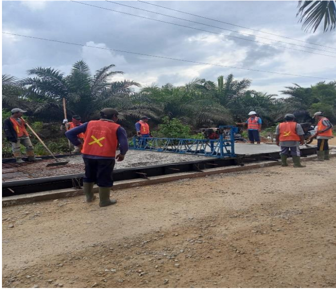
Gambar 3.14 Pengecoran Beton (Sumber : Dokumentasi Lapangan)
