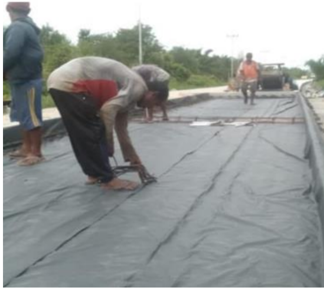
Gambar 3.11 Pemasangan Dudukan (Sumber : Dokumentasi Lapangan )
