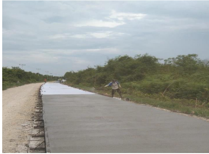
Gambar 3.19 Penyemprotan Curing Compound (Sumber : Dokumentasi Lapangan)
