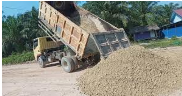
Gambar 3 .1 Penuangan Base B (Sumber : Dokumentasi Lapangan)
