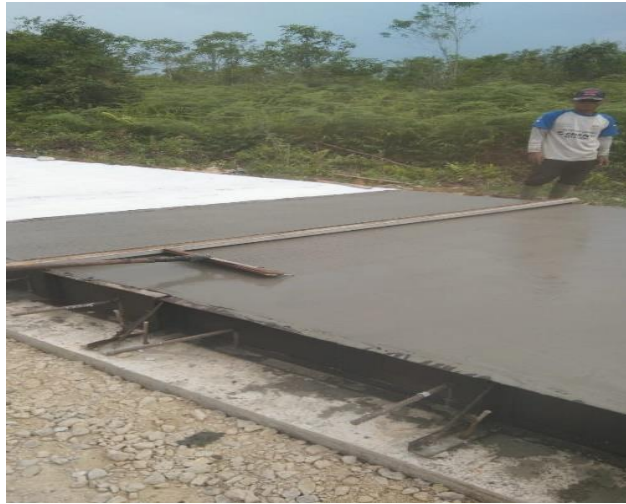
Gambar 3.18 Pembuatan Tekstur ( Grooving ) (Sumber : Dokumentasi Lapangan)
