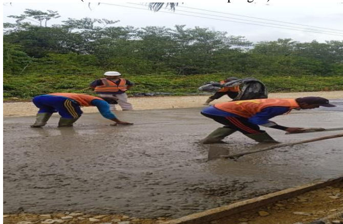
Gambar 3.17 Finishing (Sumber : Dokumentasi Lapangan)
