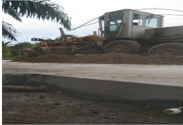
Gambar 3.2 Penghamparan Base B (Sumber : Dokumentasi Lapangan)
