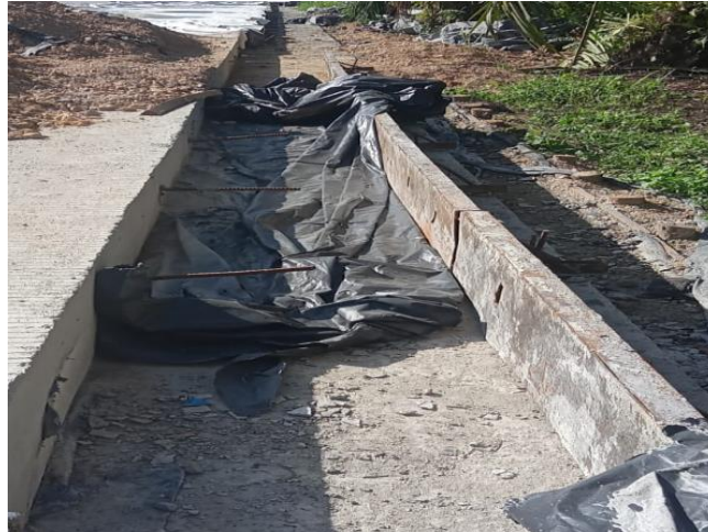
Gambar 3.23 Pemasangan Bekisting Bahu Jalan (Sumber : Dokumentasi Lapangan)
