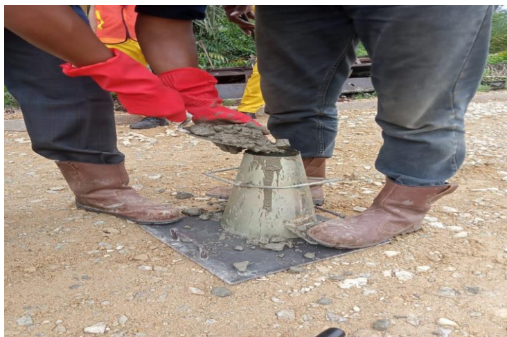
Gambar 4.8 Pengujian Slump (Sumber: Dokumentasi lapangan)
