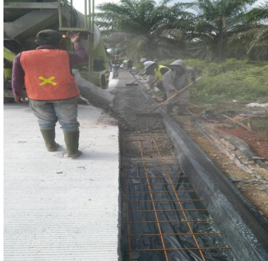
Gambar 3.25 Penuangan Beton (Sumber : Dokumentasi Lapangan)
