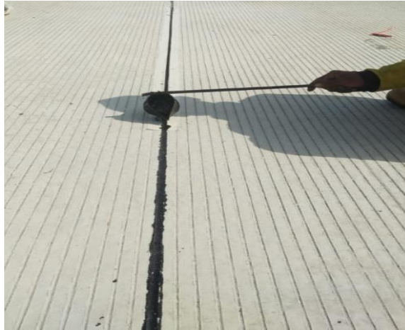
Gambar 3.22 Penuangan Joint Sealant (Sumber : Dokumentasi Lapangan)
