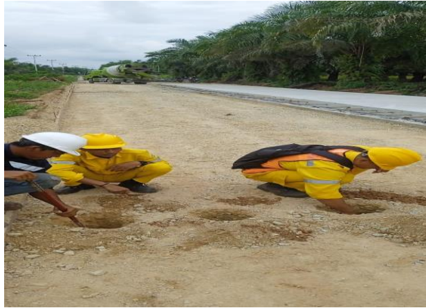
Gambar 3.5 Pengukuran kedalaman Base B (Sumber : Dokumentasi Lapangan )
