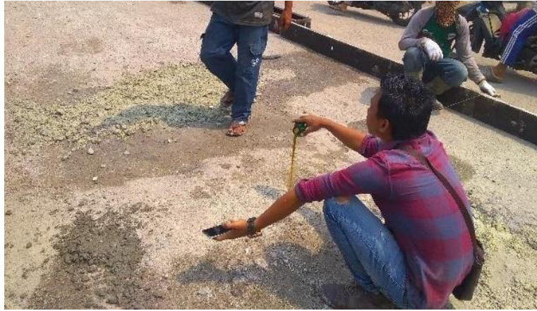
Gambar 4.5 Pengecoran Elevasi
