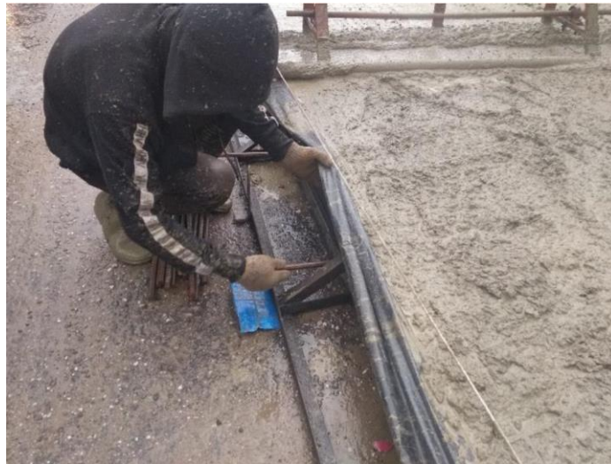
Gambar 4.14 Pemasangan Besi Gie-ber (Sumber : Dokumentasi lapangan)
