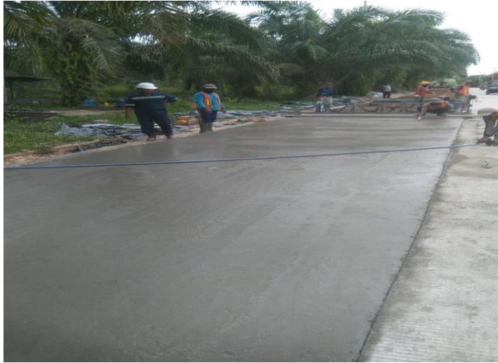
Gambar 4.15 Finishing (Sumber: Dokumentasi lapangan)
