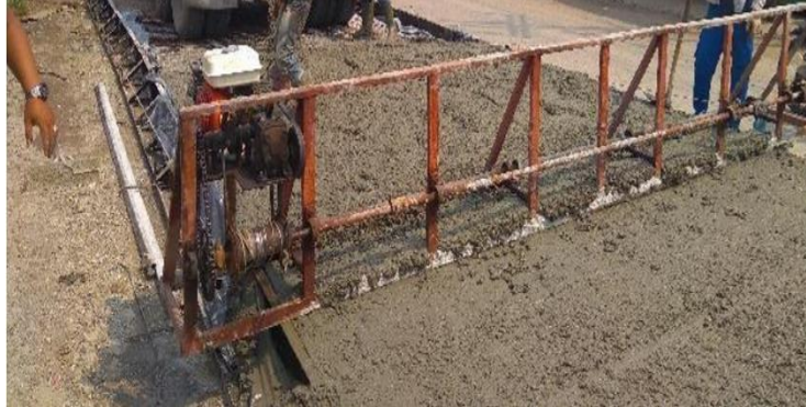
Gambar 4.13 Pemerataan Permukaan Beton (Sumber: Dokumentasi lapangan)
