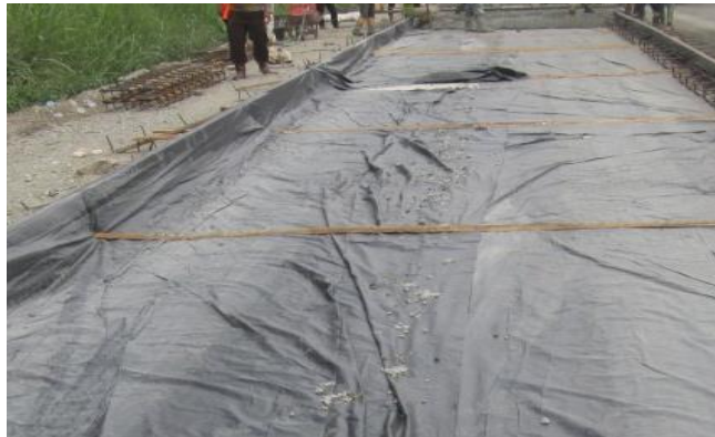
Gambar 3.10 Pemasangan Plastik Alas (Sumber : Dokumentasi Lapangan )
