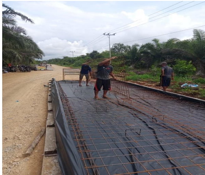
Gambar 3.12 Pemasangan Wiremesh M8 (Sumber : Dokumentasi Lapangan )
