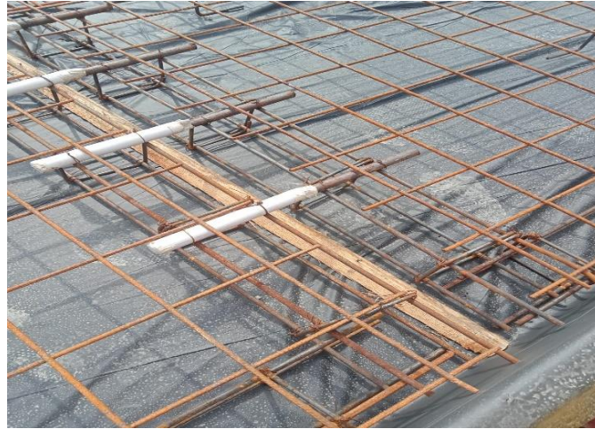
Gambar 3.13 Pemasangan Bangku Dowel (Sumber : Dokumentasi Lapangan )
