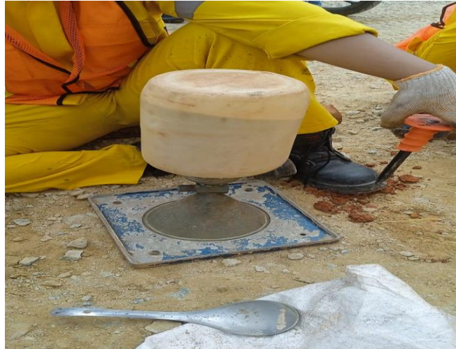
Gambar 3.6 Pengujian Sandcone (Sumber : Dokumentasi Lapangan )
