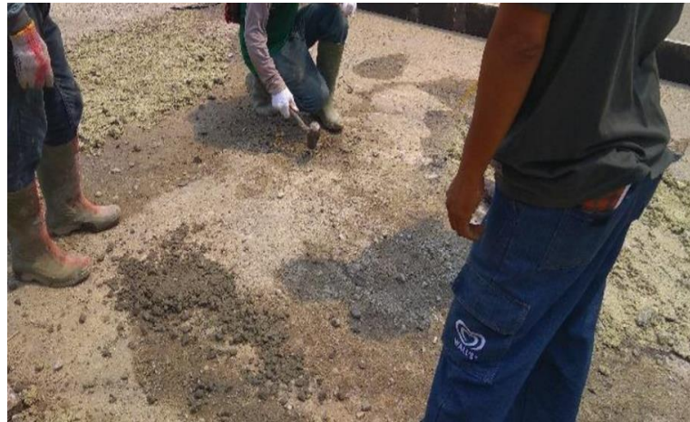
Gambar 4.6 Meratakan Permukaan
