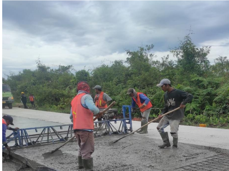
Gambar 4.10 Penuangan Adukan Beton (Sumber: Dokumentasi lapangan)
