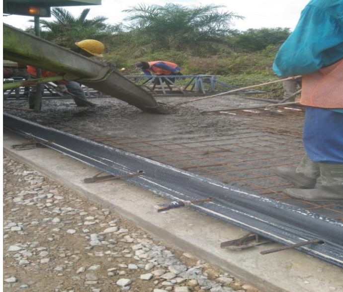
Gambar 4.7 Truck Mixer di Lokasi Pengecoran ( Sumber: Dokumentasi lapangan )
