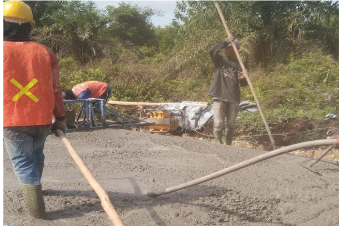
Gambar 4.12 Proses Pemadatan Beton (Sumber: Dokumentasi lapangan)
