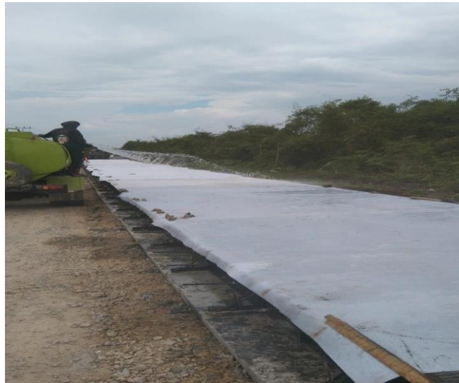
Gambar 3.20 Penyemprotan air pada beton (Sumber : Dokumentasi Lapangan)
