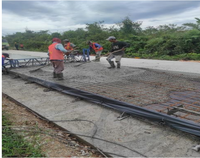
Gambar 3.16 Pemerataan Permukaan Beton (Sumber : Dokumentasi Lapangan)
