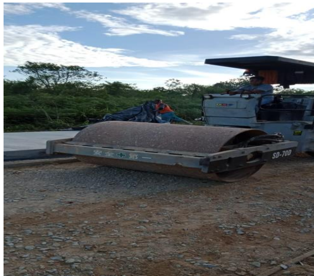
Gambar 3.3 Pemasatan Base B (Sumber : Dokumentasi Lapangan)
