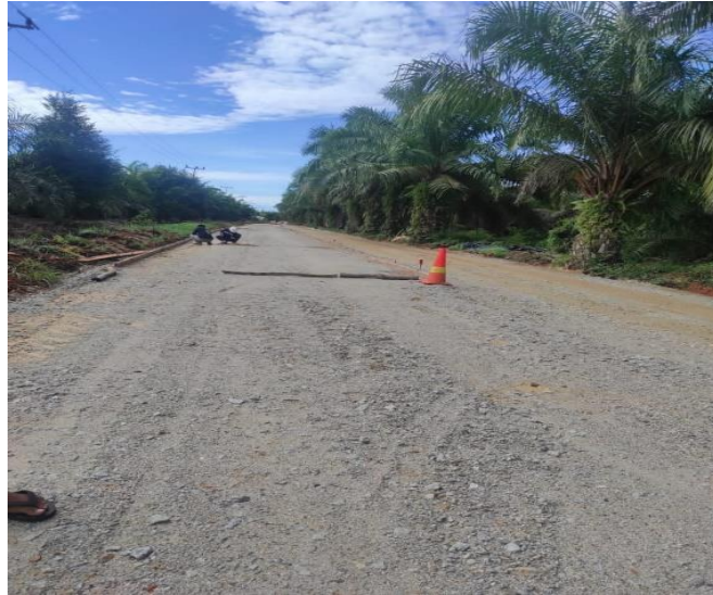
Gambar 3.7 Pemasangan Bekisting Lc (Sumber : Dokumentasi Lapangan)
