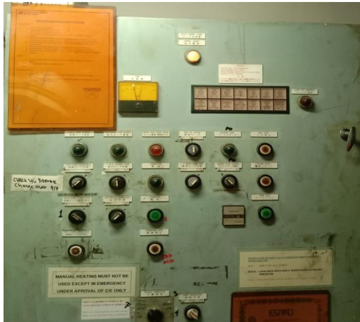
Gambar 2.9 Pemeriksaan BOILER CONTROL
