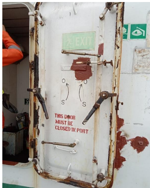
Gambar 2.58 Pemeriksaan pintu deck kapal
