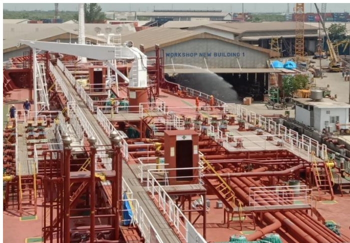
Gambar 2.8 Pengetesan pada nozel hydrant kapal
