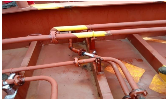
Gambar 2.57 Pemeriksaan pipa dan sambungan pipa
