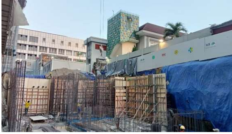
Gambar 3. 26 Pengecoran kolom dan dinding (Sumber: Dokumentasi Pribadi)
