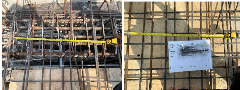
Gambar 3. 32 Pengecekan Tulangan Plat dan Balok (Sumber: Dokumentasi proyek,2023)
