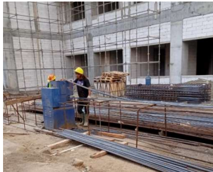
Gambar 3. 29 Pemotongan tulangan (Sumber: Dokumentasi pribadi,2023)
