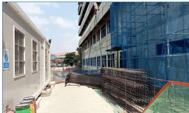
Gambar 3. 22 Pengangkatan tulangan menggunakan Tower Crane (sumber : Dokumentasi Pribadi,2023)
