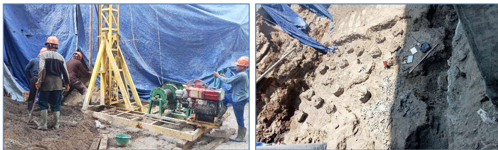
Gambar 3. 12 Pekerjaan BoredPile (Sumber: Dokumentasi Pribadi, 2023 )
