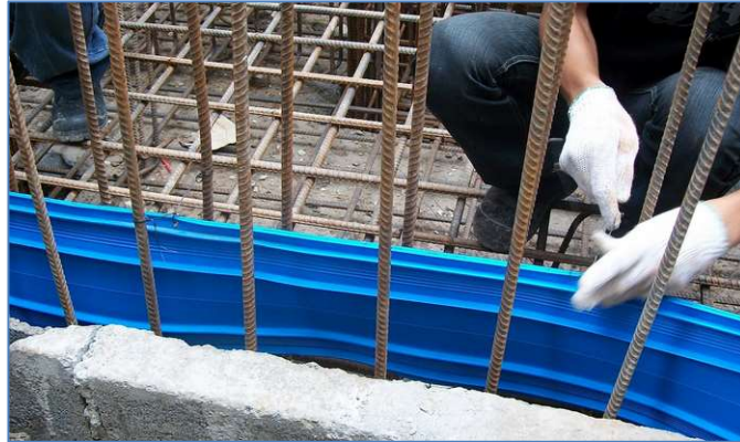
Gambar 3. 21 Pemasangan Waterstop (sumber : Dokumentasi)
