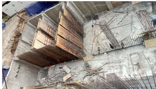
Gambar 3. 24 Bekisting Kolom dan retaining wall ( Sumber: Dokumentasi Pribadi,2023 )
