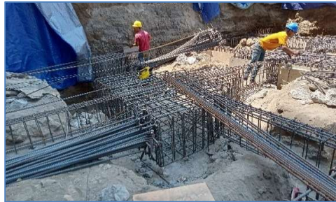
Gambar 3. 15 Penulangan Pile Cap (Sumber: Dokumentasi Pribadi, 2023 )
