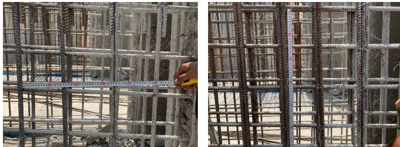
Gambar 3. 23 Pengecekan Tulangan Kolom
