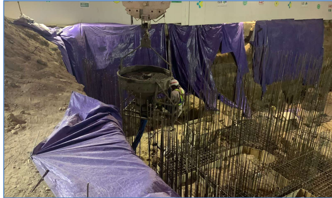
Gambar 3. 20 Pengecoran TieBeam (Sumber: Dokumentasi Pribadi, 2023)
