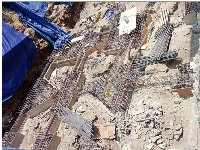
Gambar 3. 19 Pembesian dan Bekisting TieBeam (Sumber: Dokumentasi Pribadi, 2023 )
