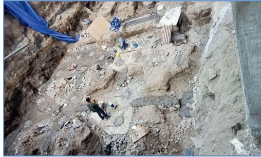
Gambar 3. 13 Lean Concrete (Sumber: Dokumentasi Pribadi, 2023 )
