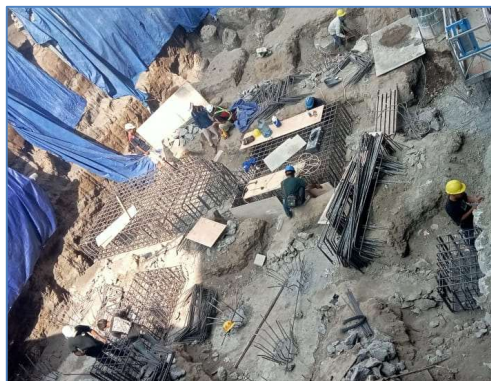
Gambar 3. 16 Bekisting PileCap (Sumber: Dokumentasi Pribadi, 2023 )
