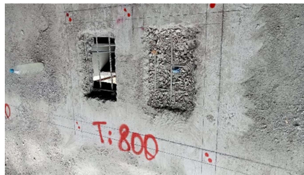
Gambar 3. 36 Marking Dinding yang sudah Jadi
