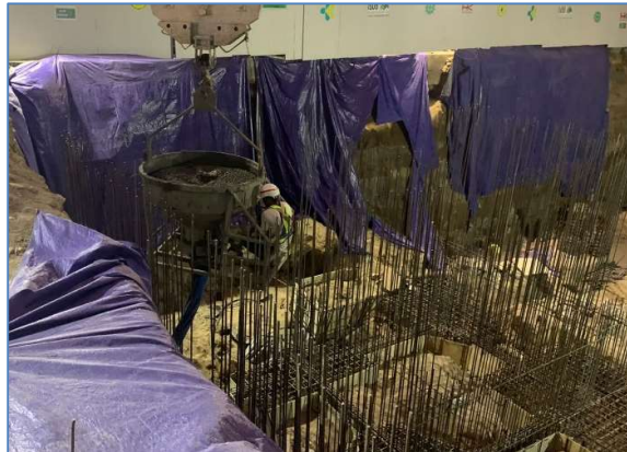
Gambar 3. 17 Pekerjaan Pengecoran PileCap (Sumber: Dokumentasi Pribadi, 2023 )
