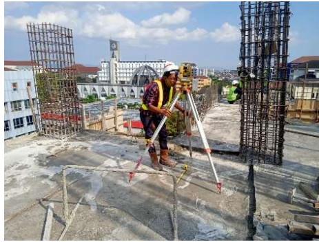
Gambar 3. 34 Penentuan As kolom (Sumber : Dokumentasi Pribadi, 2023)
