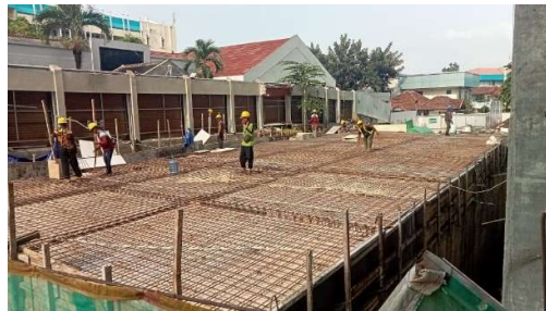
Gambar 3. 31 Pembesian Plat Lantai (Sumber: Dokumentasi pribadi,2023)
