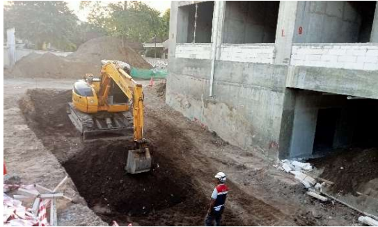
Gambar 3. 10 Penggalian GWT (Sumber : Dokumentasi Pribadi, 2023 )
