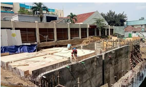
Gambar 3. 28 Pemasangan Bekisting Balok dan Plat (Sumber: Dokumentasi pribadi,2023)
