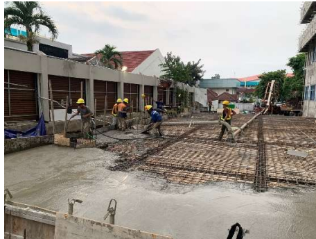
Gambar 3. 33 Pengecoran Plat dan Balok (Sumber: Dokumentasi pribadi,2023)
