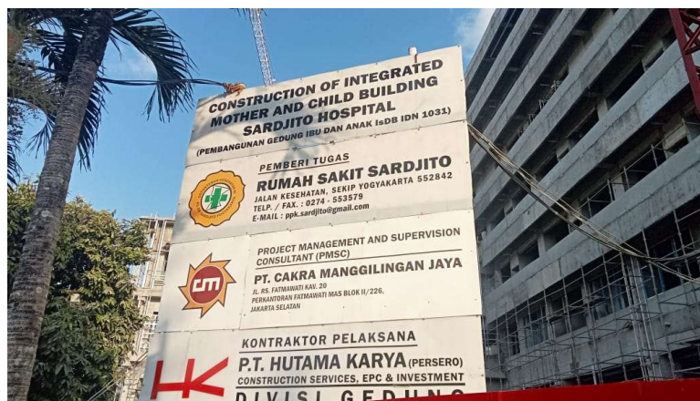
Gambar 2. 7 Papan Nama Proyek (Sumber : Dokumentasi pribadi, 2023)
