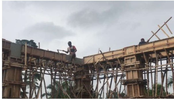
Gambar 3.39 Pembongkaran Bekisting Ring Balok ( sumber : Dokumentasi Lapangan )
