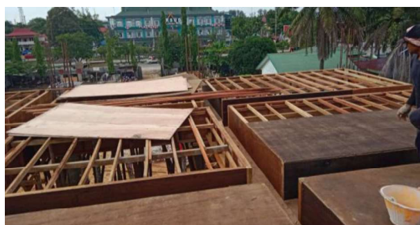
Gambar 3.30 Gelagar Kayu Plat Lantai ( sumber : Dokumentasi Lapangan )
