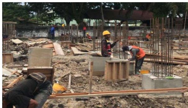
Gambar 3.8 Pembongkaran Bekisting ( sumber : Dokumentasi Lapangan )
