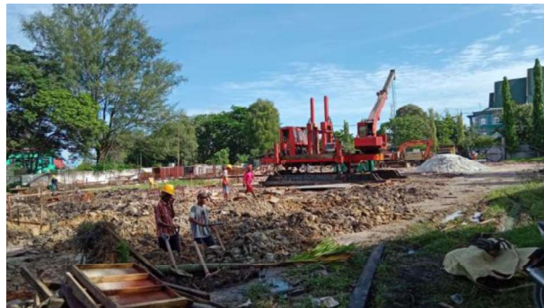
Gambar 3.4 Galian tanah Pile Cap ( sumber : Dokumentasi Lapangan )
