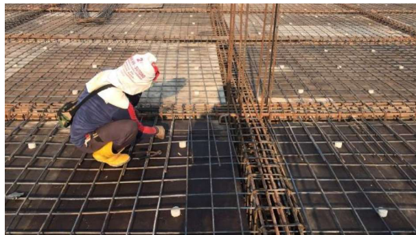
Gambar 3.32 Pembersian Plat Lantai ( sumber : Dokumentasi Lapangan )
