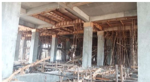
Gambar 3.35 Pembongkaran Bekisting Plat Lantai ( sumber : Dokumentasi Lapangan )
