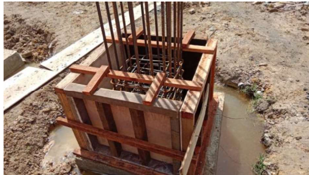
Gambar 3.10 Bekisting Kolom Pedestal ( sumber : Dokumentasi Lapangan )
