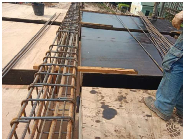
Gambar 3.31 Bekisting Plat Lantai ( sumber : Dokumentasi Lapangan )
