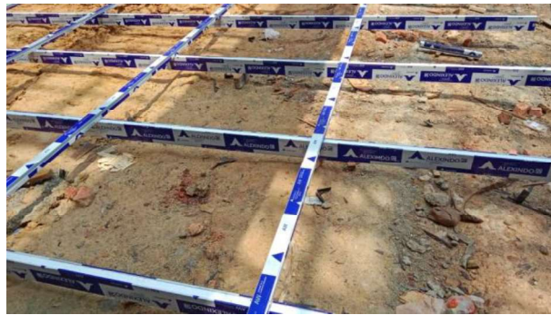
Gambar 3.61 Perakitan Rangka Curtain Wall ( sumber : Dokumentasi Lapangan )
