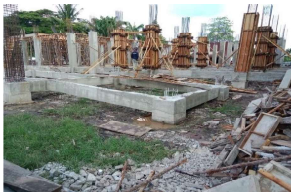
Gambar 3.18 Pembongkaran Bekisting Sloof ( sumber : Dokumentasi Lapangan )
