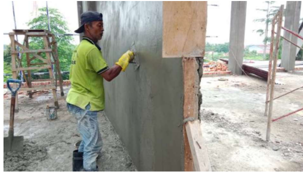
Gambar 3.46 Plasteran Dinding Bata ( sumber : Dokumentasi Lapangan )
