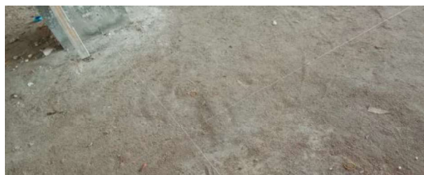
Gambar 3.57 Benang Acuan Granit ( sumber : Dokumentasi Lapangan )
