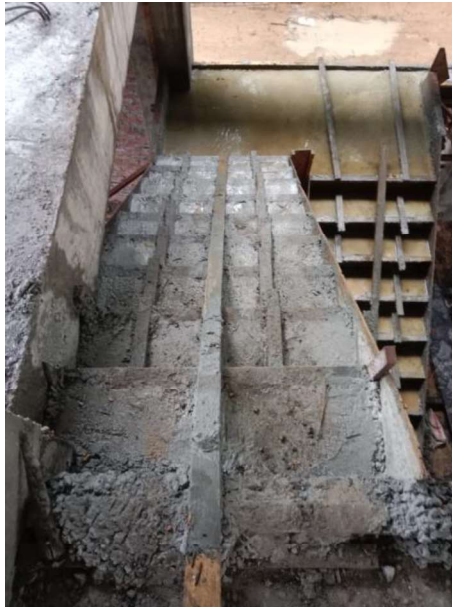
Gambar 3.42 Pengecoran Tangga ( sumber : Dokumentasi Lapangan )
