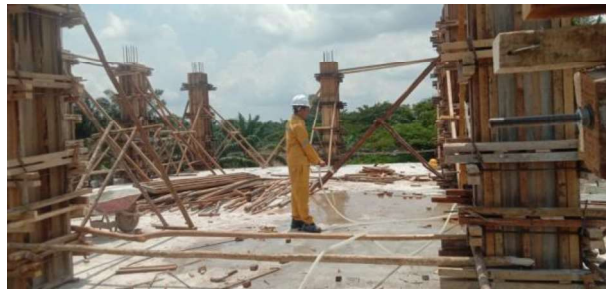
Gambar 3.34 Perawatan Plat Lantai ( sumber : Dokumentasi Lapangan )
