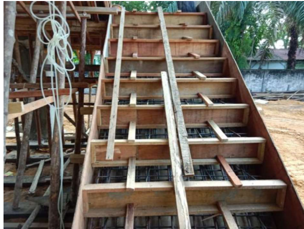
Gambar 3.41 Pembesian Tangga ( sumber : Dokumentasi Lapangan )
