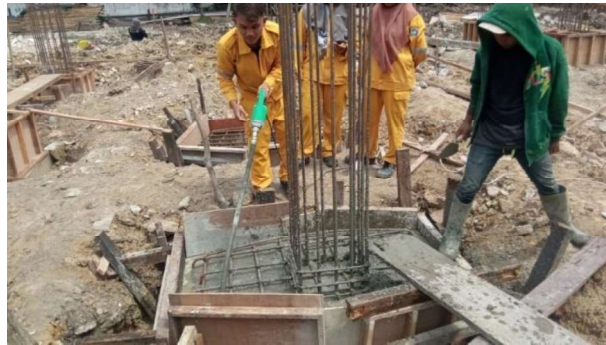
Gambar 3.7 Pengecoran Pile Cap ( sumber : Dokumentasi Lapangan )
