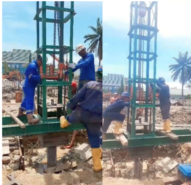
Gambar 3.2 Pemukulan Drop Hammer pada Tiang Pancang ( sumber : Dokumentasi Lapangan )
