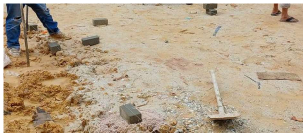
Gambar 3.74 Leveling Paving Block ( sumber : Dokumentasi Lapangan )
