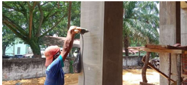
Gambar 3.44 Pengeboran lubang untuk Tulangan ( sumber : Dokumentasi Lapangan )
