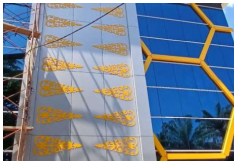
Gambar 3.67 ACP yang telah selesai terpasang ( sumber : Dokumentasi Lapangan )
