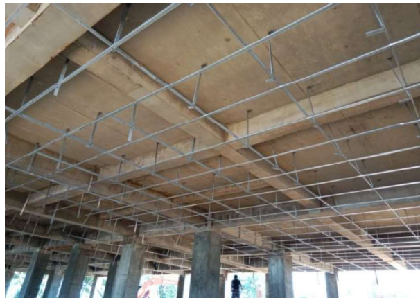
Gambar 3.54 Rangka Plafon ( sumber : Dokumentasi Lapangan )
