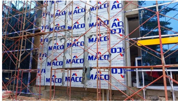
Gambar 3.66 Pemasangan Lembar ACP ( sumber : Dokumentasi Lapangan )
