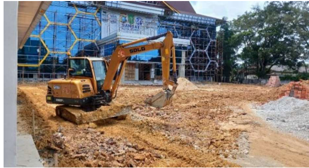
Gambar 3.73 Pekerjaan Perataan Permukaan Jalan ( sumber : Dokumentasi Lapangan )
