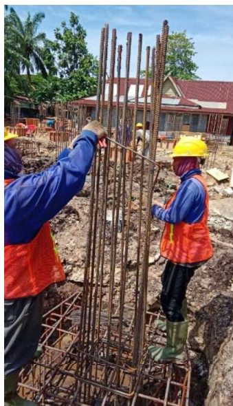
Gambar 3.9 Perakitan Tulangan Kolom Pedestal ( sumber : Dokumentasi Lapangan )
