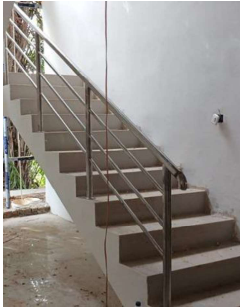
Gambar 3.43 Pemasangan Railing Tangga ( sumber : Dokumentasi Lapangan )
