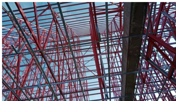
Gambar 3.51 Pemasangan Reng ( sumber : Dokumentasi Lapangan )
