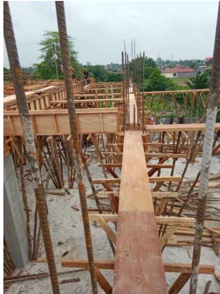
Gambar 3.36 Bekisting Ring Balok ( sumber : Dokumen Lapangan )
