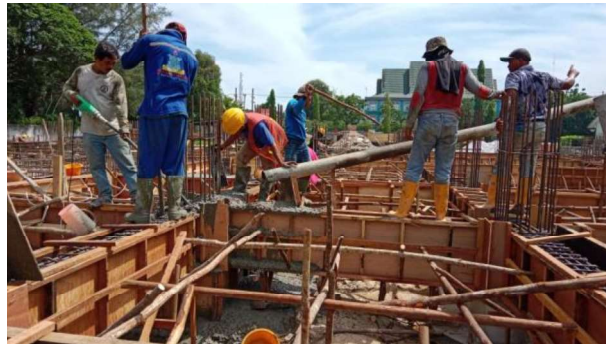
Gambar 3.17 Pengecoran Sloof ( sumber : Dokumentasi Lapangan )
