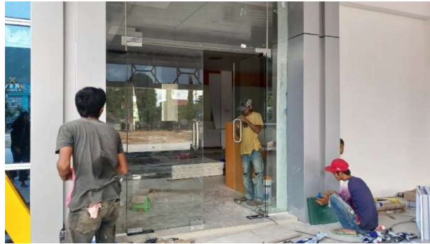
Gambar 3.71 Pemasangan Pintu Tipe P1 ( sumber : Dokumentasi Lapangan )
