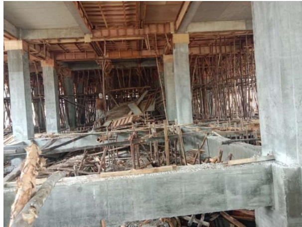
Gambar 3.29 Pembongkaran Bekisting Balok ( sumber : Dokumentasi Lapangan )
