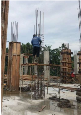
Gambar 3.20 Perakitan Tulangan Kolom ( sumber : Dokumentasi Lapangan )
