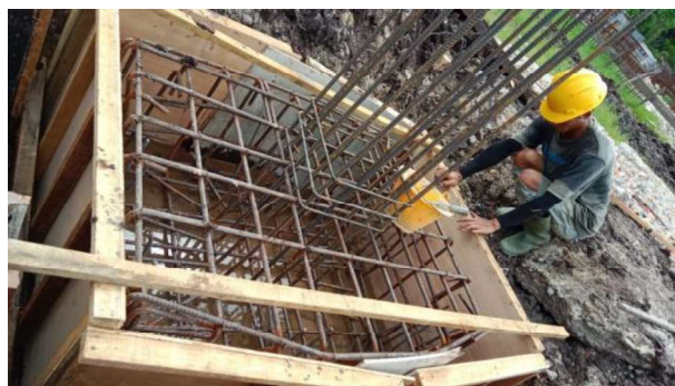
Gambar 3.6 Bekisting Pile Cap ( sumber : Dokumentasi Lapangan )
