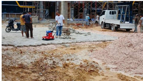
Gambar 3.76 Pemasakan Paving Block ( sumber : Dokumentasi Lapangan )
