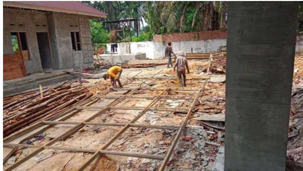
Gambar 3.64 Perakitan Rangka ACP ( sumber : Dokumentasi Lapangan )
