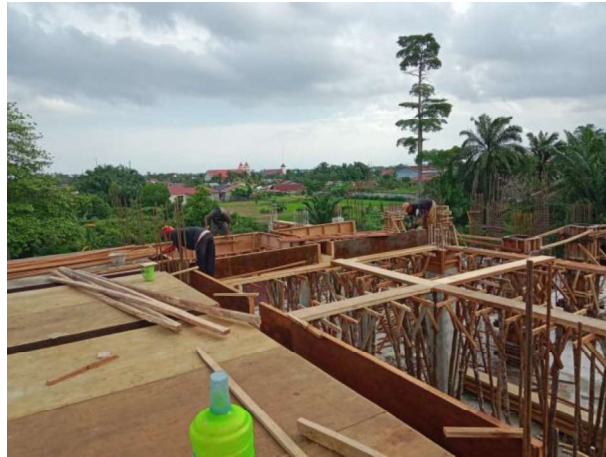
Gambar 3.26 Bekisting Balok ( sumber : Dokumentasi Lapangan )
