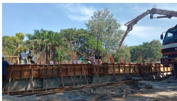
Gambar 3.11 Pengecoran Kolom Pedestal ( sumber : Dokumentasi Lapangan )
