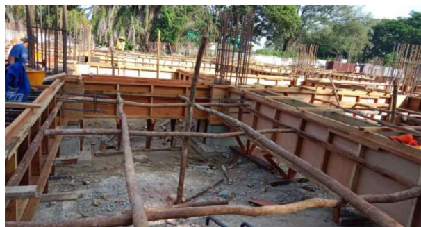
Gambar 3.16 Bekisting Sloof ( sumber : Dokumentasi Lapangan )
