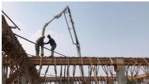
Gambar 3.38 Pengecoran Ring Balok ( sumber : Dokumentasi Lapangan )
