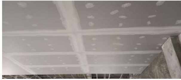
Gambar 3.56 Dempul Plafond ( sumber : Dokumentasi Lapangan )
