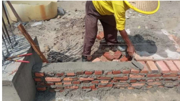
Gambar 3.13 Pasangan Batu Rollag ( sumber : Dokumentasi Lapangan )
