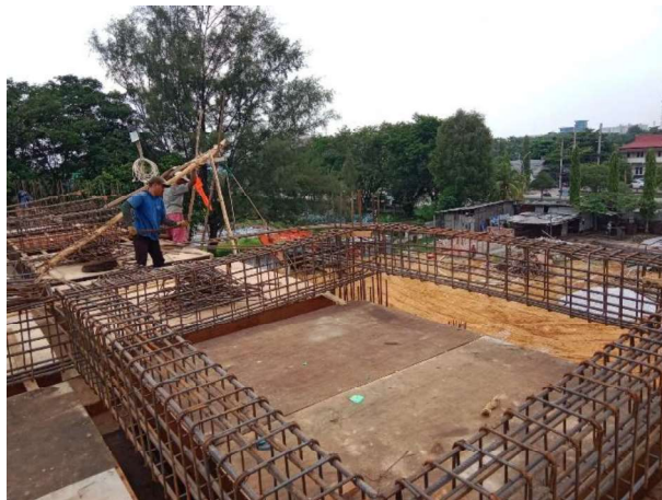
Gambar 3.27 Penulangan Balok ( sumber : Dokumentasi Lapangan )
