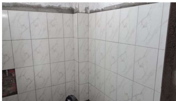
Gambar 3.48 Pemasangan Dinding Keramik ( sumber : Dokumentasi Lapangan )
