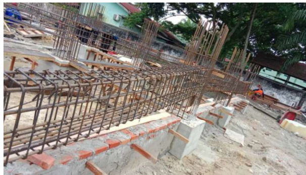
Gambar 3.15 Penulangan Balok Sloof ( sumber : Dokumentasi Lapangan )
