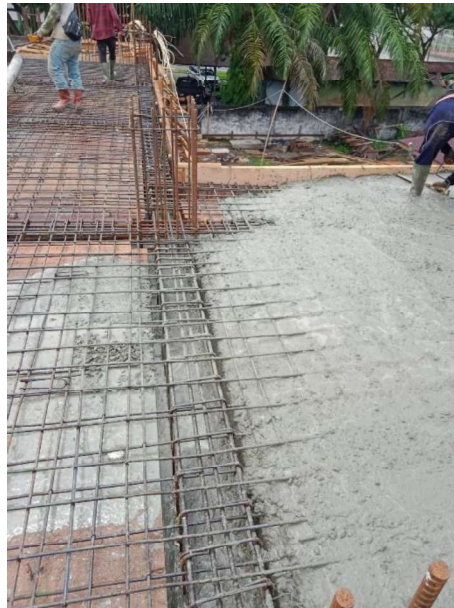
Gambar 3.28 Pengecoran Balok ( sumber : Dokumentasi Lapangan )
