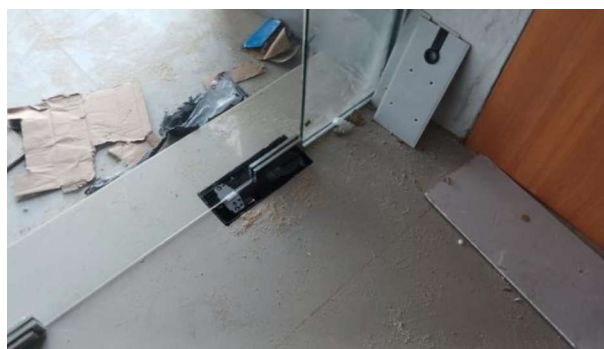
Gambar 3.70 Pemasangan Floor Hinges ( sumber : Doukmentasi Lapangan )
