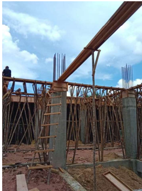
Gambar 3.25 Perancah Balok ( sumber : Dokumentasi Lapangan )
