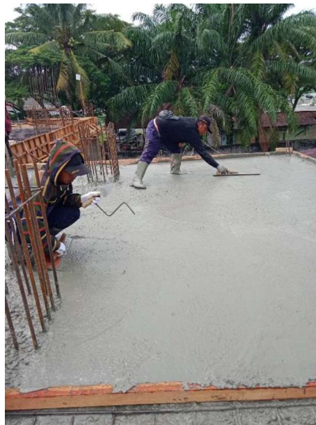
Gambar 3.33 Pengecoran Plat Lantai ( sumber : Dokumentasi Lapangan )
