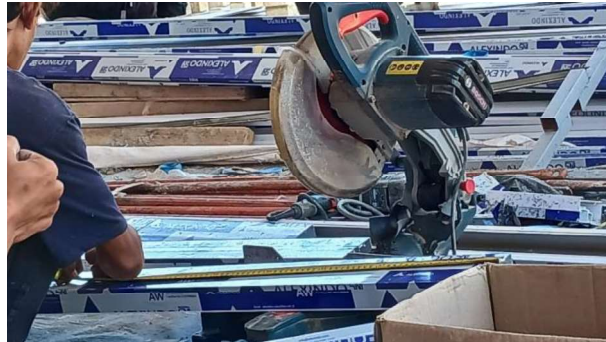
Gambar 3.68 Fabrikasi Kusen ( sumber : Dokumentasi Lapangan )
