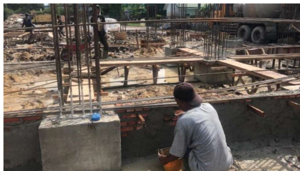
Gambar 3.14 Adverking Batu Rollag ( sumber : Dokumentasi Lapangan )
