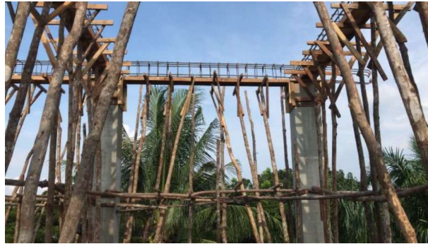
Gambar 3.37 Pembesian Ring Balok ( sumber : Dokumentasi Lapangan )
