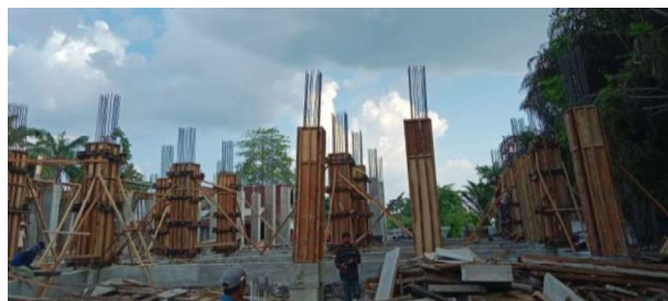
Gambar 3.23 Pembongkaran Bekisting Kolom ( sumber : Dokumentasi Lapangan )
