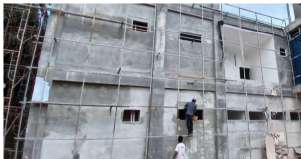
Gambar 3.65 Pemasangan Rangka ACP ( sumber : Dokumentasi Lapangan )
