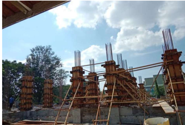
Gambar 3.21 Bekisting Kolom ( sumber : Dokumentasi Lapangan )
