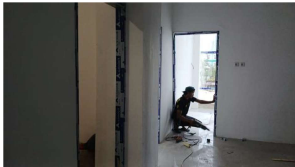
Gambar 3.69 Pemasangan Kusen Aluminium ( sumber : Dokumentasi Lapangan )
