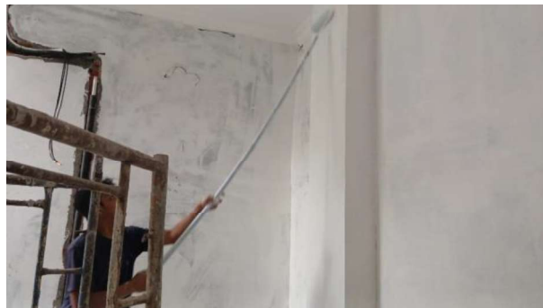
Gambar 3.49 Pengecatan Dinding ( sumber : Dokumentasi Lapangan )
