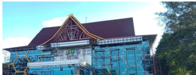
Gambar 3.53 Pasangan Atap ( sumber : Dokumentasi Lapangan )
