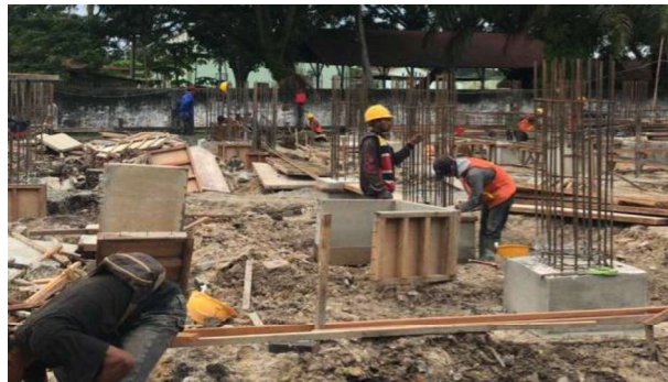
Gambar 3.12 Pembongkaran Bekisting Kolom Pedestal ( sumber : Dokumentasi Lapangan )
