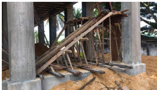
Gambar 3.40 Bekisting Tangga ( sumber : Dokumentasi Lapangan )
