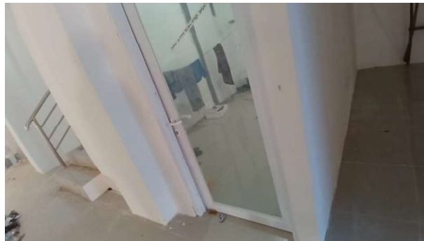
Gambar 3.72 Pemasangan Pintu ( sumber : Dokumentasi Lapangan )
