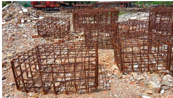
Gambar 3.5 Pile Cap yang sudah dirakit ( sumber : Dokumentasi Lapangan )
