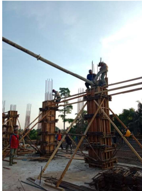
Gambar 3.22 Pengecoran Kolom ( sumber : Dokumentasi Lapangan )
