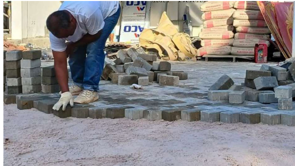
Gambar 3.75 Pasangan Paving Block ( sumber : Dokumentasi Lapangan )
