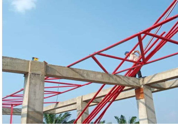
Gambar 3.50 Pemasangan Kuda-Kuda ( sumber : Dokumentasi Lapangan )
