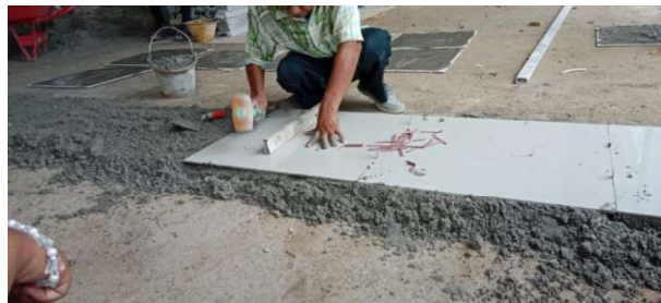
Gambar 3.58 Pasangan granit ( sumber : Dokumentasi Lapangan )
