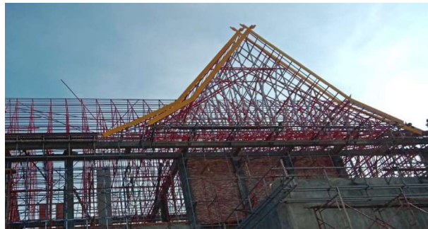
Gambar 3.52 Pemasangan Lisplank ( sumber : Dokumentasi Lapangan )
