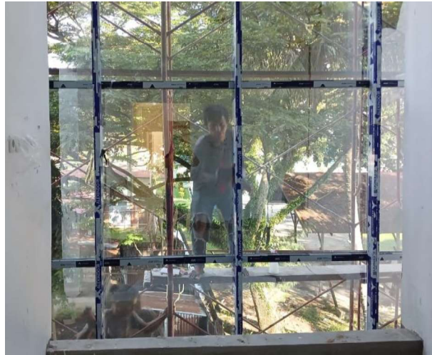
Gambar 3.63 Pembersihan Kaca Curtain Wall ( sumber : Dokumentasi Lapangan )
