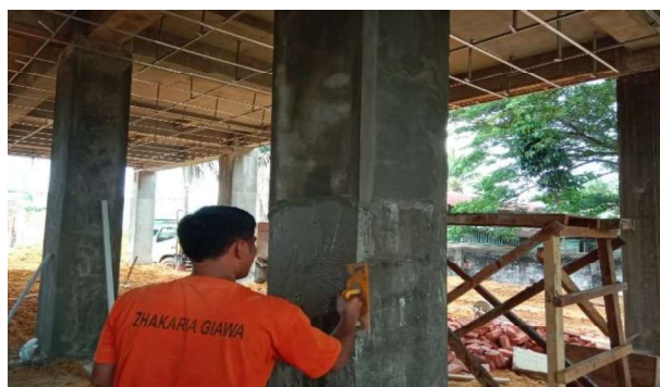
Gambar 3.47 Acian kolom ( sumber : Dokumentasi Lapangan )
