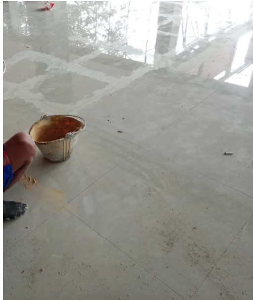
Gambar 3.59 Pengisian Grout pada Granit ( sumber : Dokumentasi Lapangan )
