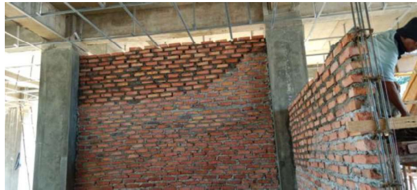
Gambar 3.45 Pasangan \frac{1}{2} Bata ( sumber : Dokumentasi Lapangan )
