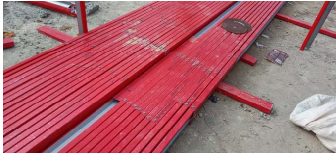
Gambar 3.64 Penyambungan Baja C 75.75 mm (Sumber : Dokumentasi Lapangan ,2023)
