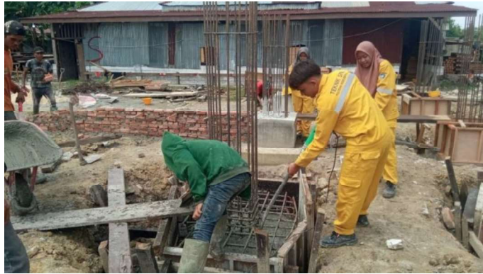
Gambar 3.5 Pengecoran Pile Cap (Sumber : Dokumentasi Lapangan ,2023)
