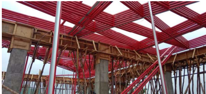
Gambar 3.65 Pemasangan Kuda-Kuda (Sumber : Dokumentasi Lapangan ,2023)
