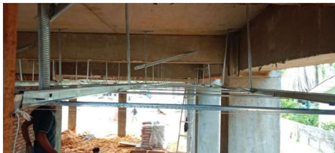
Gambar 3.61 Pemasangan Rangka Horizontal (Sumber : Dokumentasi Lapangan ,2023)
