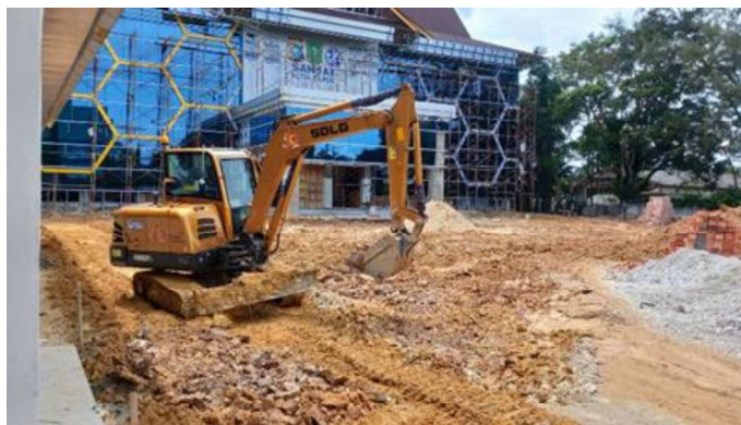
Gambar 3.81 Meratakan Tanah Timbunan (Sumber : Dokumentasi Lapangan ,2023)
