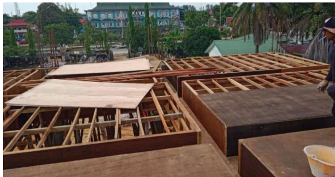
Gambar 3.35 Pemasangan Bekisting (Sumber : Dokumentasi Lapangan ,2023)
