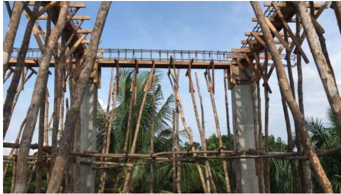
Gambar 3.43 Pembesian Ring Balok (Sumber : Dokumentasi Lapangan ,2023)
