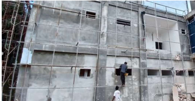
Gambar 3.75 Pemasangan Rangka ACP (Sumber : Dokumentasi Lapangan ,2023)
