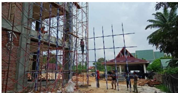
Gambar 3.70 Erection Rangka (Sumber : Dokumentasi Lapangan ,2023)
