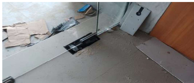
Gambar 3.80 Pemasangan Floor Hinges (Sumber : Dokumentasi Lapangan ,2023)
