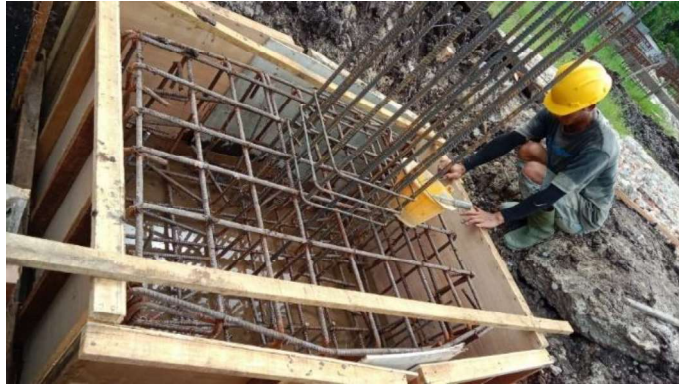
Gambar 3.4 Pekerjaan Bekisting Pile Cap (Sumber : Dokumentasi Lapangan ,2023)
