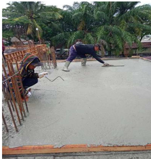
Gambar 3.38 Pengecoran Plat Lantai (Sumber : Dokumentasi Lapangan ,2023)
