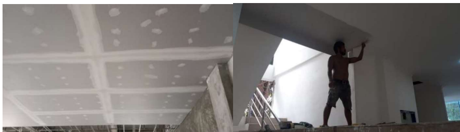
Gambar 3.63 Pekerjaan Pengecatan Dan Pendempulan (Sumber : Dokumentasi Lapangan ,2023)
