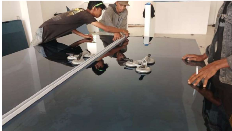
Gambar 3.72 Mengukur Dan Memotong Kaca (Sumber : Dokumentasi Lapangan ,2023)
