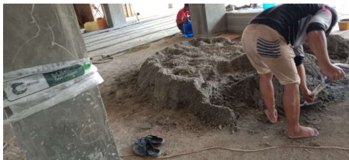
Gambar 3.56 Membuat Adukan Spesi (Sumber : Dokumentasi Lapangan ,2023)
