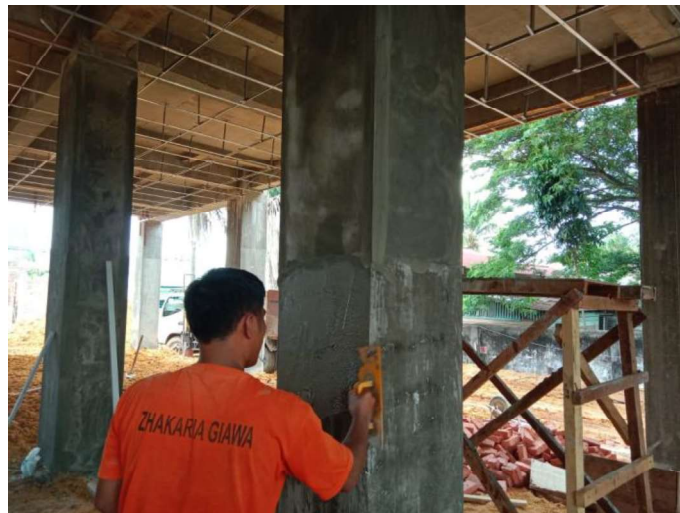
Gambar 3.52 Acian Kolom (Sumber : Dokumentasi Lapangan ,2023)
