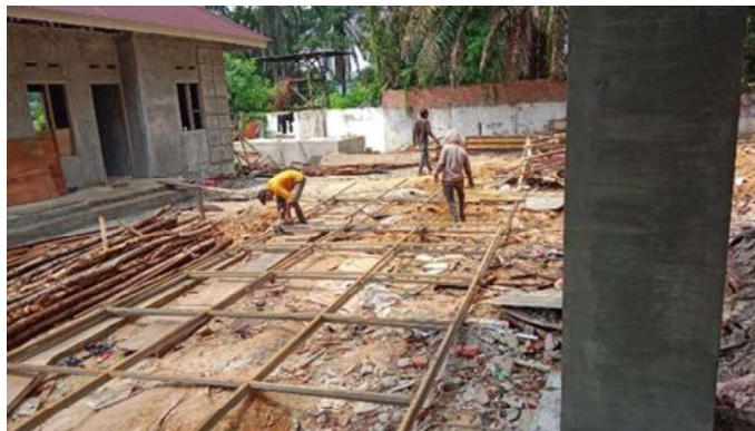
Gambar 3.74 Perakitan Rangka ACP (Sumber : Dokumentasi Lapangan ,2023)
