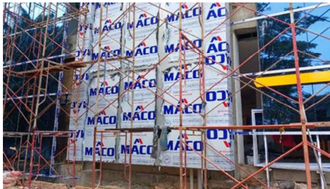
Gambar 3.76 Pemasangan ACP (Sumber : Dokumentasi Lapangan ,2023)
