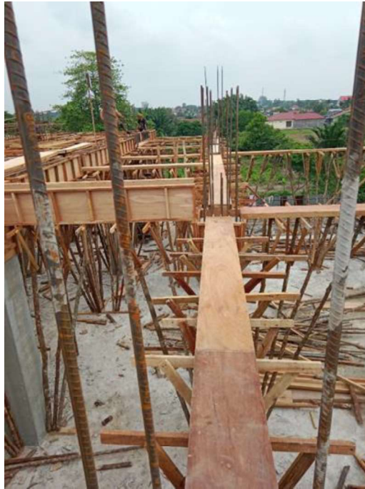
Gambar 3.42 Bekisting Ring Balok (Sumber : Dokumentasi Lapangan ,2023)
