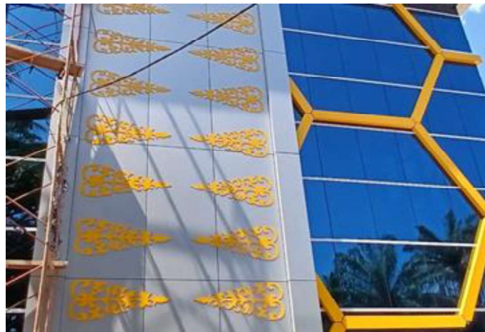
Gambar 3.77 Pekerjaan Finishing (Sumber : Dokumentasi Lapangan ,2023)
