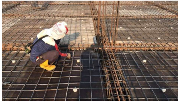
Gambar 3.37 Pembesian Plat Lantai (Sumber : Dokumentasi Lapangan ,2023)
