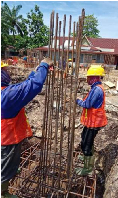
Gambar 3.12 Perakitan Tulangan (Sumber : Dokumentasi Lapangan ,2023)
