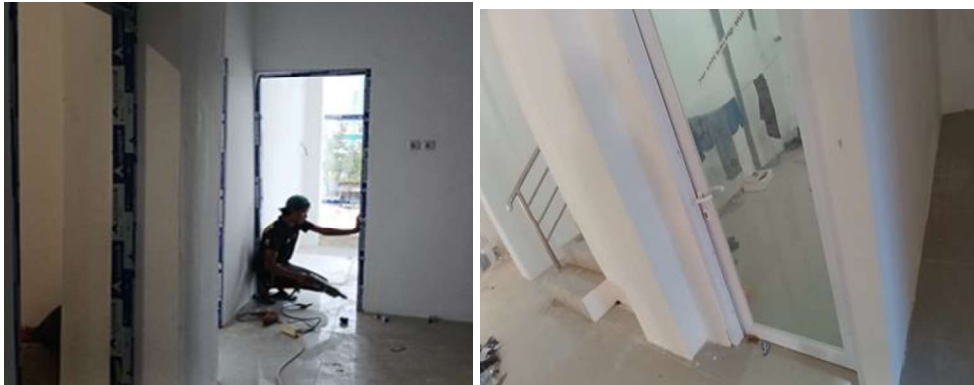
Gambar 3.78 Pemasangan Kusen dan Daun Pintu Tipe (Sumber : Dokumentasi Lapangan ,2023)
