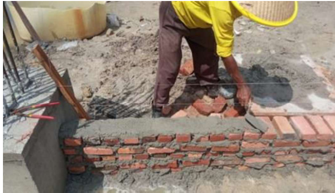
Gambar 3.21 Pemasangan Batu Rollag (Sumber : Dokumentasi Lapangan ,2023)
