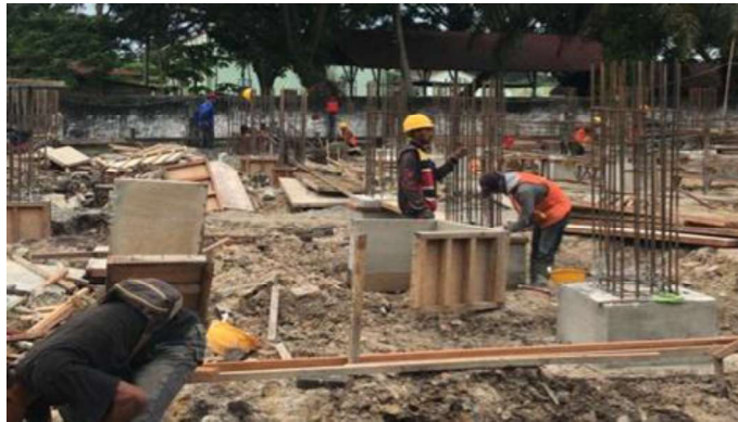
Gambar 3.6 Pembongkaran Bekisting (Sumber : Dokumentasi Lapangan ,2023)
