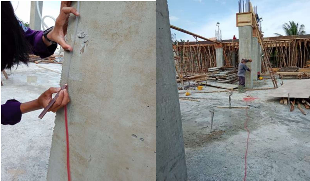
Gambar 3.41 Pengukuran Elevasi Dengan Selang Air (Sumber : Dokumentasi Lapangan ,2023)
