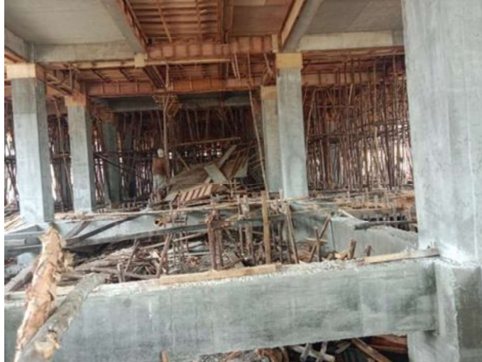
Gambar 3.34 Pembongkaran Bekisting Balok (Sumber : Dokumentasi Lapangan ,2023)
