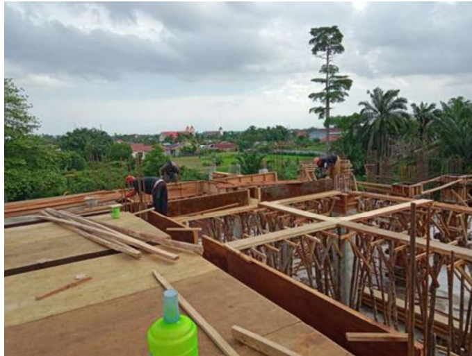
Gambar 3.31 Bekisting Balok (Sumber : Dokumentasi Lapangan ,2023)
