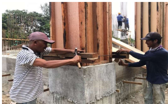
Gambar 3.26 Pemasangan Tie Rod Kolom (Sumber : Dokumentasi Lapangan ,2023)
