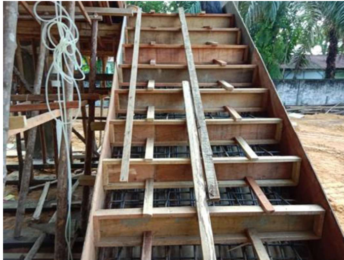
Gambar 3.47 Pembesian Tangga (Sumber : Dokumentasi Lapangan ,2023)
