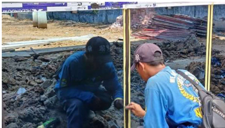
Gambar 3.73 Perekatan Menggunakan Silicone (Sumber : Dokumentasi Lapangan ,2023)
