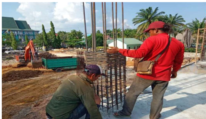
Gambar 3.24 Perakitan Tulangan Kolom (Sumber : Dokumentasi Lapangan ,2023)
