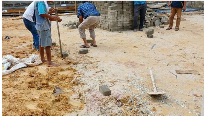
Gambar 3.82 Meratakan Pasir Urug Dan Membuat Benang Acuan (Sumber : Dokumentasi Lapangan ,2023)
