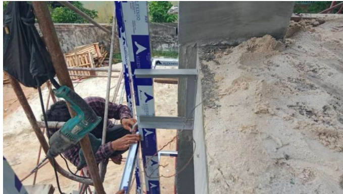
Gambar 3.71 Pengecekan Kedataran Rangka Curtain Wall (Sumber : Dokumentasi Lapangan ,2023)
