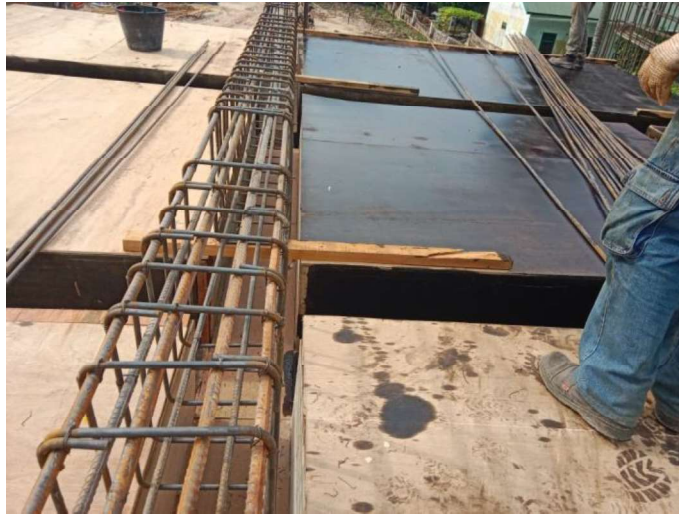
Gambar 3.36 Pekerjaan Minyak Bekisting (Sumber : Dokumentasi Lapangan ,2023)
