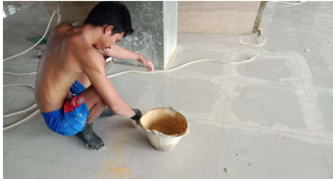
Gambar 3.58 Pekerjaan Grouting Pada Granit (Sumber : Dokumentasi Lapangan ,2023)
