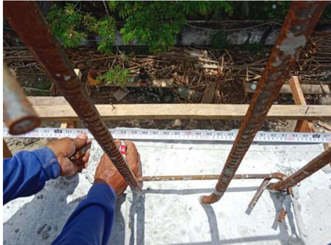
Gambar 3.23 Penentuan As Kolom (Sumber : Dokumentasi Lapangan ,2023)
