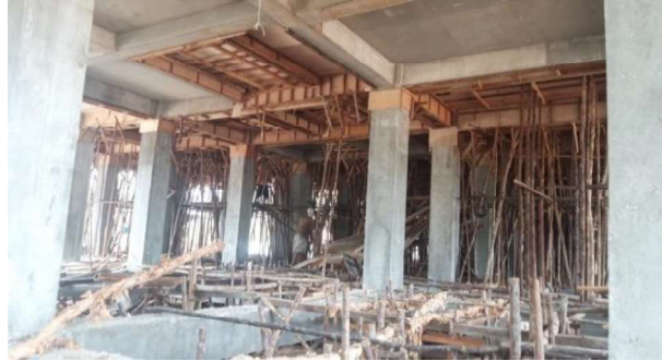
Gambar 3.39 Pembongkaran Bekisting Plat Lantai (Sumber : Dokumentasi Lapangan ,2023)
