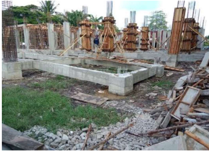
Gambar 3.20 Pembongkaran Bekisting Sloof (Sumber : Dokumentasi Lapangan ,2023)
