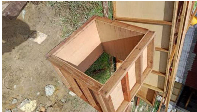
Gambar 3.13 Pembuatan Bekisting (Sumber : Dokumentasi Lapangan ,2023)
