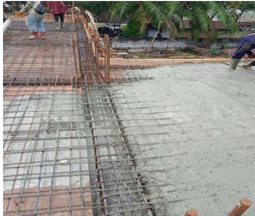
Gambar 3.33 Pengecoran Balok (Sumber : Dokumentasi Lapangan ,2023)
