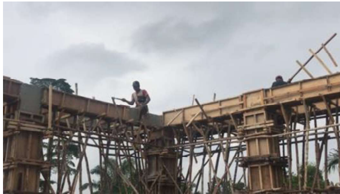
Gambar 3.45 Pembongkaran Bekisting Ring Balok (Sumber : Dokumentasi Lapangan ,2023)
