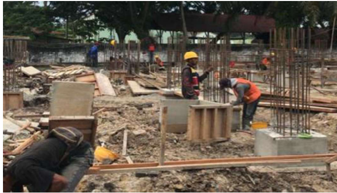
Gambar 3.16 Pembongkaran Bekisting (Sumber : Dokumentasi Lapangan ,2023)
