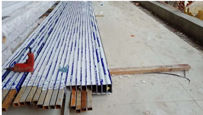
Gambar 3.69 Pemasangan Besi Hollow Pada Aluminium (Sumber : Dokumentasi Lapangan ,2023)
