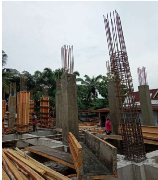
Gambar 3.28 Pembongkaran Bekisting Kolom (Sumber : Dokumentasi Lapangan ,2023)
