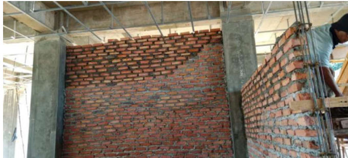
Gambar 3.50 Pasangan ½ Bata (Sumber : Dokumentasi Lapangan ,2023)
