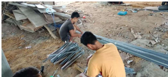
Gambar 3.59 Pemotongan Rangka Furing (Sumber : Dokumentasi Lapangan ,2023)
