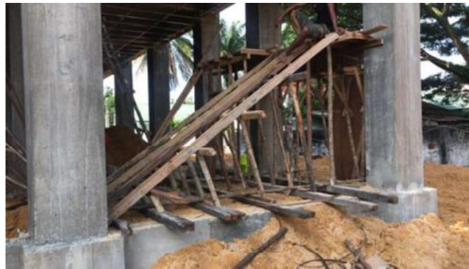
Gambar 3.46 Bekisting Tangga (Sumber : Dokumentasi Lapangan ,2023)
