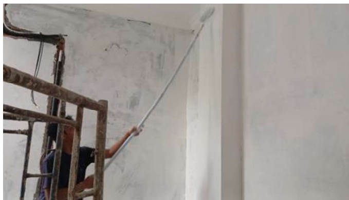
Gambar 3.54 Pengecatan Dinding (Sumber : Dokumentasi Lapangan ,2023)
