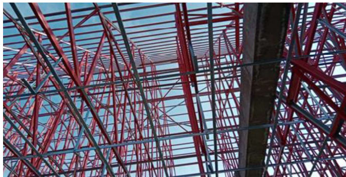
Gambar 3.66 Pemasangan Reng (Sumber : Dokumentasi Lapangan ,2023)
