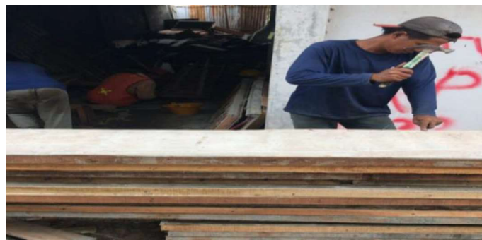
Gambar 3.25 Pembuatan Bekisting Kolom (Sumber : Dokumentasi Lapangan ,2023)
