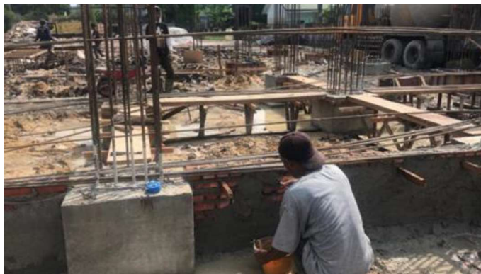
Gambar 3.22 Pekerjaan Plesteran (Sumber : Dokumentasi Lapangan ,2023)
