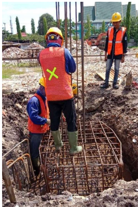
Gambar 3.3 Penulangan Kolom Pedestal (Sumber : Dokumentasi Lapangan ,2023)
