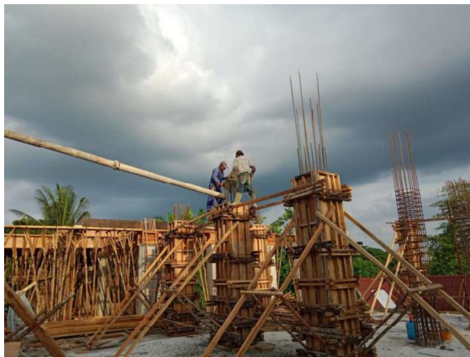
Gambar 3.27 Pengecoran Kolom (Sumber : Dokumentasi Lapangan ,2023)
