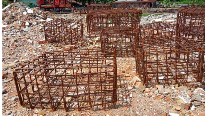
Gambar 3.2 Penulangan Pile Cap (Sumber : Dokumentasi Lapangan ,2023)
