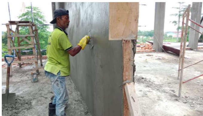
Gambar 3.51 Plesteran Dinding Bata (Sumber : Dokumentasi Lapangan ,2023)
