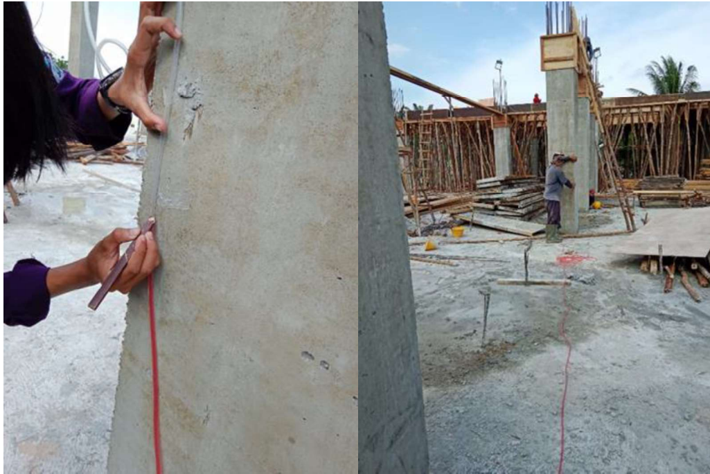
Gambar 3.29 Pengukuran Elevasi Dengan Selang Air (Sumber : Dokumentasi Lapangan ,2023)
