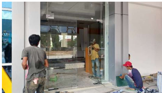
Gambar 3.78 Pemasangan Kusen dan Daun Pintu Tipe (Sumber : Dokumentasi Lapangan ,2023)
