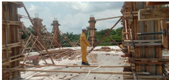
Gambar 3.40 Perawatan Plat Lantai (Sumber : Dokumentasi Lapangan ,2023)
