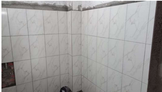
Gambar 3.53 Pemasangan Dinding Keramik (Sumber : Dokumentasi Lapangan ,2023)
