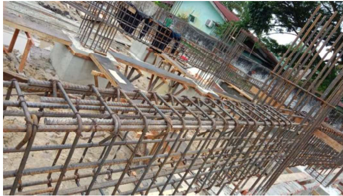
Gambar 3.17 Penulangan Sloof (Sumber : Dokumentasi Lapangan ,2023)
