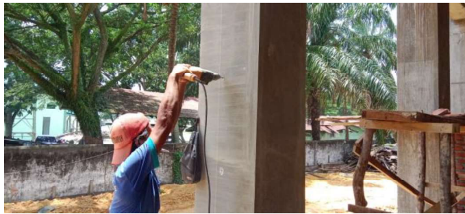
Gambar 3.49 Pengeboran untuk Tulangan (Sumber : Dokumentasi Lapangan ,2023)
