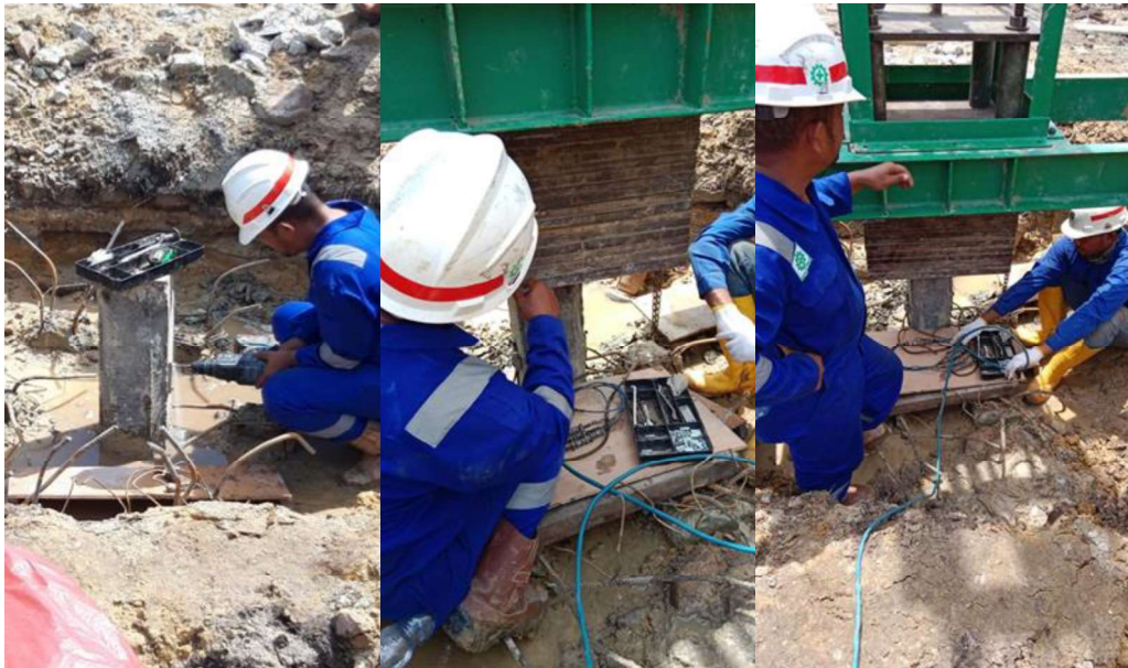
Gambar 3.7 Persiapan sebelum pengujian PDA (Sumber : Dokumentasi Lapangan ,2023)
