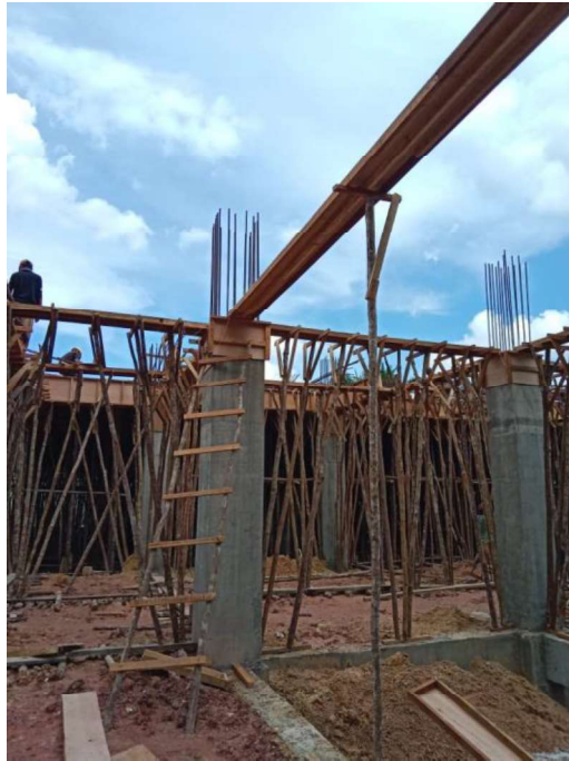
Gambar 3.30 Perancah Balok (Sumber : Dokumentasi Lapangan ,2023)
