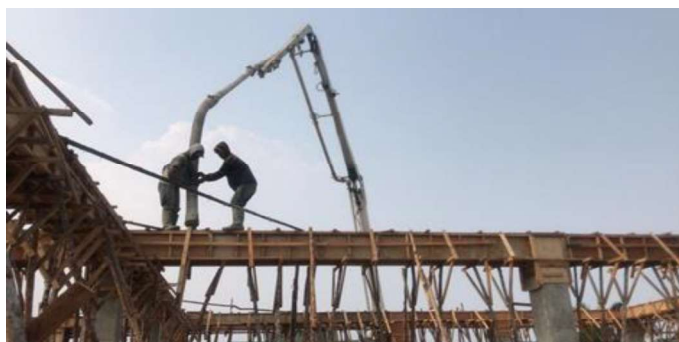
Gambar 3.44 Pengecoran Ring Balok (Sumber : Dokumentasi Lapangan ,2023)
