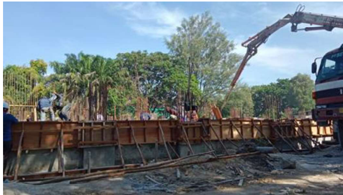
Gambar 3.15 Pengecoran Kolom Pedestal (Sumber : Dokumentasi Lapangan ,2023)
