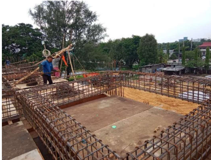
Gambar 3.32 Pembesian Balok (Sumber : Dokumentasi Lapangan ,2023)
