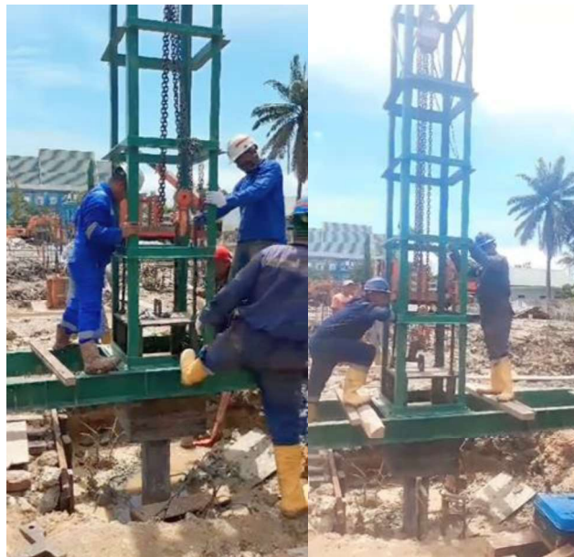
Gambar 3.8 Proses Pengujian Dengan Drop Hammer (Sumber : Dokumentasi Lapangan ,2023)
