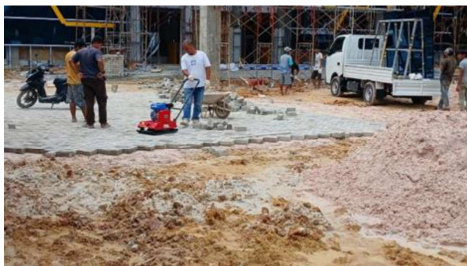
Gambar 3.84 Memadatkan Conblok (Sumber : Dokumentasi Lapangan ,2023)
