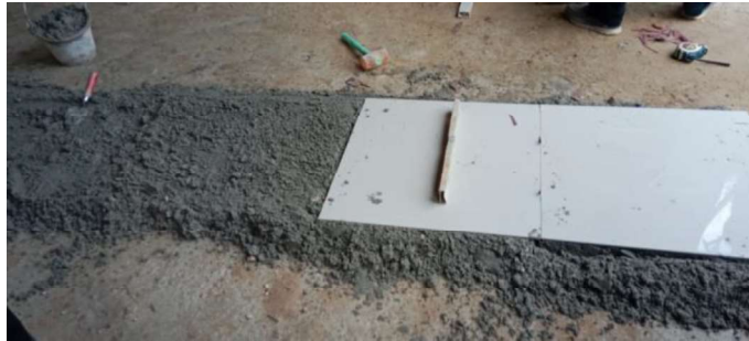
Gambar 3.57 Pemasangan Granit (Sumber : Dokumentasi Lapangan ,2023)
