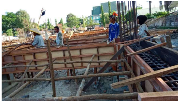
Gambar 3.18 Pemasangan Bekisting Sloof (Sumber : Dokumentasi Lapangan ,2023)
