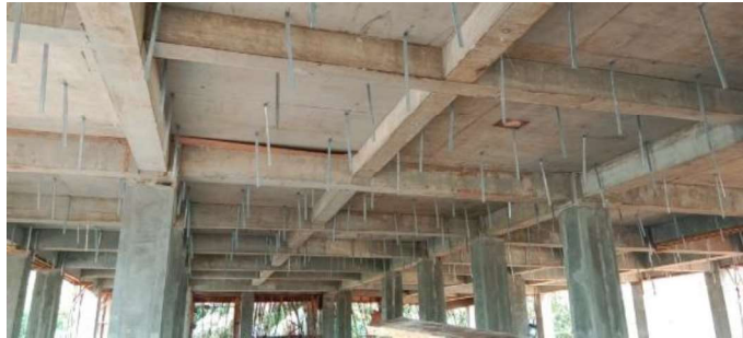
Gambar 3.60 Pemasangan Rangka Vertikal (Sumber : Dokumentasi Lapangan ,2023)
