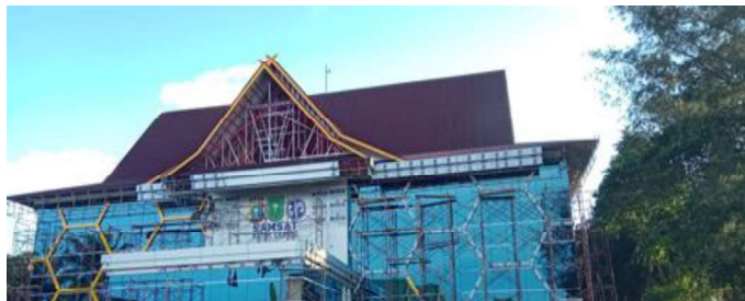
Gambar 3.67 Pemasangan Lisplank Dan Atap (Sumber : Dokumentasi Lapangan ,2023)
