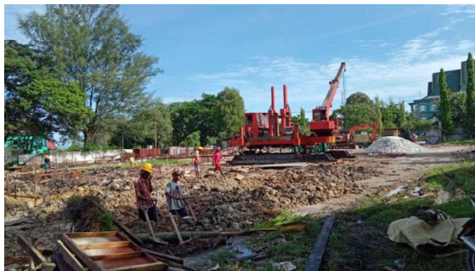
Gambar 3.1 Penggalian Tanah (Sumber : Dokumentasi Lapangan ,2023)
