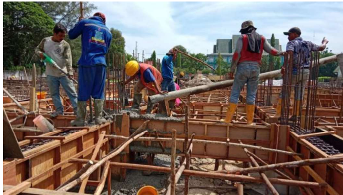
Gambar 3.19 Pengecoran Sloof (Sumber : Dokumentasi Lapangan ,2023)
