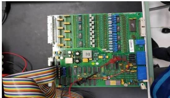
Gambar 3. 9 Pemasangan Socket Kaki IC
