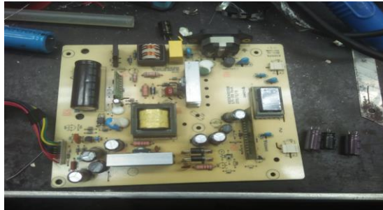
Gambar 2. 4 Perbaikan Monitor Hp (Sumber Dokumentasi PT. Indah Kiat pulp & paper Tbk Perawang 2023)
