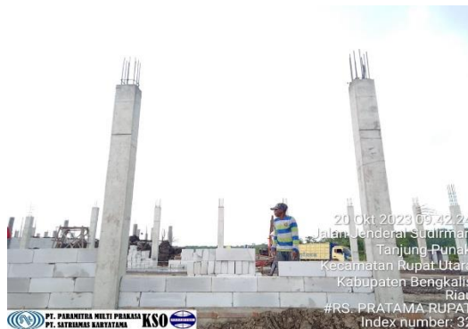
Gambar 3. 43 Pemasangan dinding bata ringan Sumber : Dokumentasi lapangan
