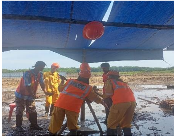
Gambar 3. 7 Pemotongan besi tulangan utama Sumber : Dokumentasi lapangan
