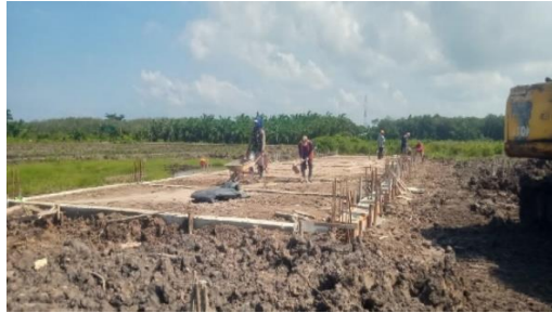
Gambar 3. 34 Proses pengurukan pasir Sumber : Dokumentasi lapangan
