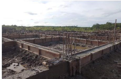
Gambar 3. 31 Proses pengecoran sloof Sumber : Dokumentasi lapangan
