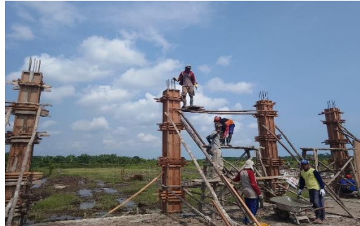
Gambar 3. 42 Proses pengecoran kolom Sumber : Dokumentasi lapangan
