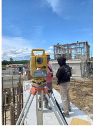
Gambar 3. 50 Pekerjaan survey titik as Sumber : Dokumentasi lapangan
