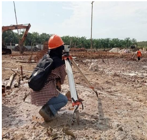
Gambar 3. 4 Pengukuran titik AS Sumber : Dokumentasi lapangan
