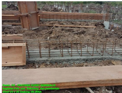
Gambar 3. 29 Proses pemasangan bekisting sloof Sumber : Dokumentasi lapangan
