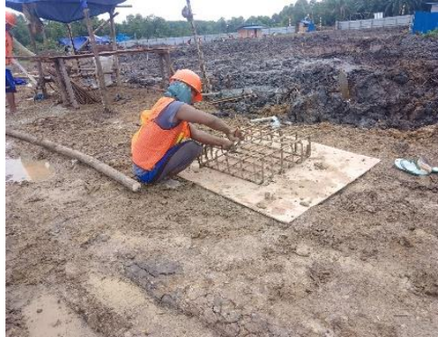
Gambar 3. 15 Penulangan pile cap Sumber : Dokumentasi lapangan
