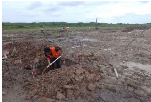
Gambar 3. 13 Pekerjaan galian tanah Sumber : Dokumentasi lapangan
