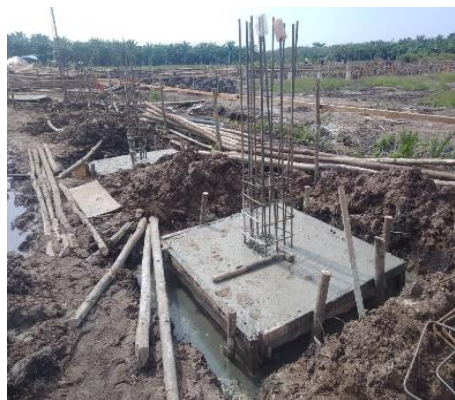
Gambar 3. 21 Hasil pengecoran pile cap Sumber : Dokumentasi lapangan
