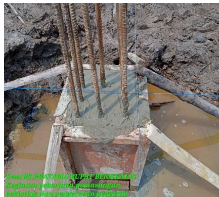
Gambar 3. 23 Pengecoran kolom pedestal Sumber : Dokumentasi lapangan
