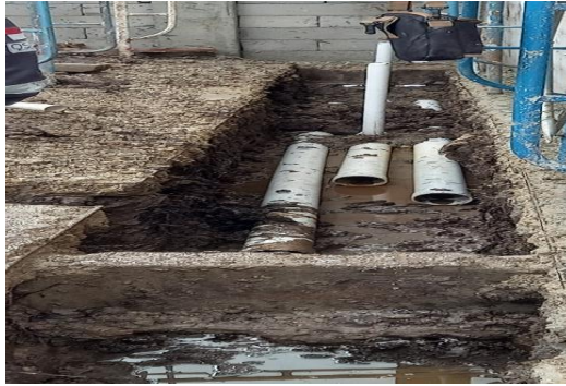
Gambar 3. 59 Pemasangan Pipa Air Kotor & Air Bersih Sumber : Dokumentasi lapangan
