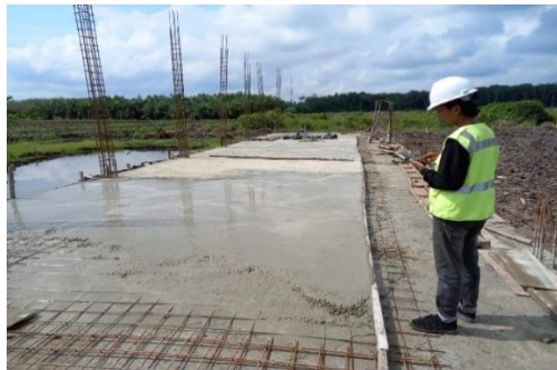
Gambar 3. 37 Proses pengecoran lantai Sumber : Dokumentasi lapangan
