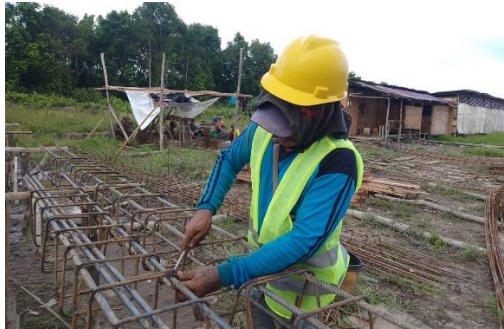
Gambar 3. 38 Proses penulangan kolom Sumber : Dokumentasi lapangan
