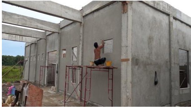
Gambar 3. 57 Pekerjaan acian Sumber : Dokumentasi lapangan
