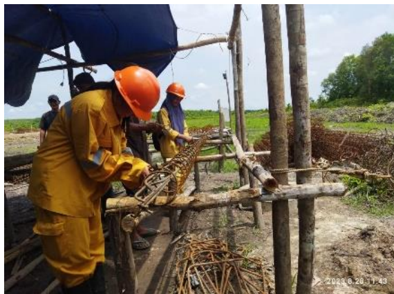
Gambar 3. 8 Perakitan tulangan strauss pile Sumber : Dokumentasi lapangan
