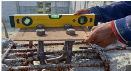
Gambar 3. 51 Proses perakitan Sumber : Dokumentasi lapangan
