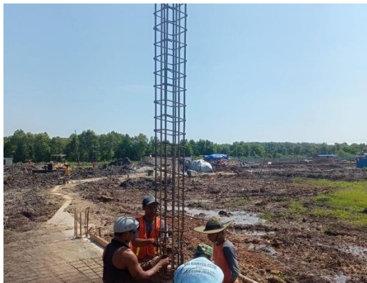
Gambar 3. 39 Proses pemasangan kolom Sumber : Dokumentasi lapangan
