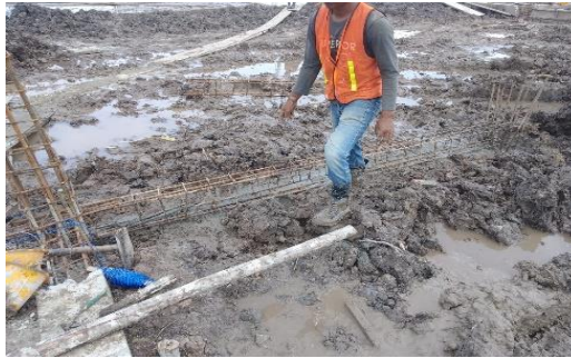
Gambar 3. 28 Proses pemasangan sloof Sumber : Dokumentasi lapangan
