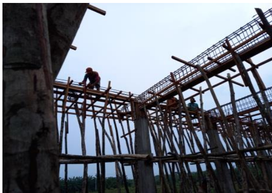
Gambar 3. 44 Penulangan balok Sumber : Dokumentasi lapangan
