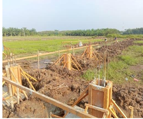
Gambar 3. 22 Pemasangan bekisting kolom pedestal Sumber : Dokumentasi lapangan
