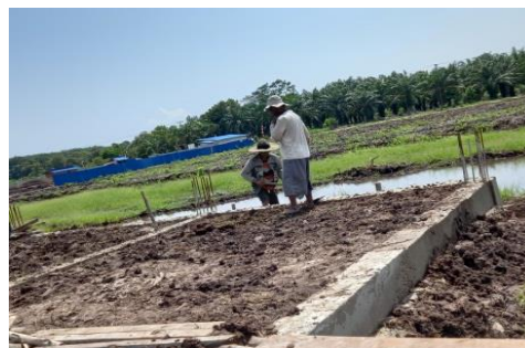
Gambar 3. 33 Proses perataan tanah Sumber : Dokumentasi lapangan
