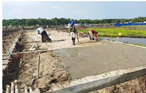
Gambar 3. 35 Proses pengecoran lantai kerja Sumber : Dokumentasi lapangan
