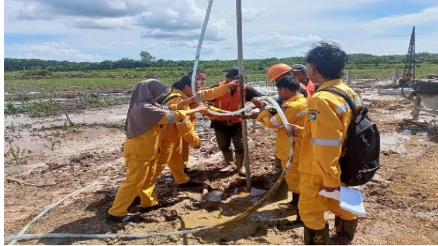
Gambar 3. 9 Proses Pengeboran strauss pile Sumber : Dokumentasi lapangan
