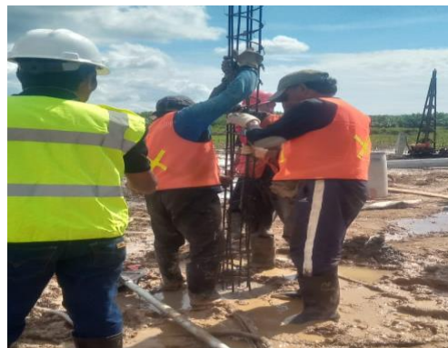
Gambar 3. 10 Proses memasukkan tulangan strauss pile Sumber : Dokumentasi lapangan
