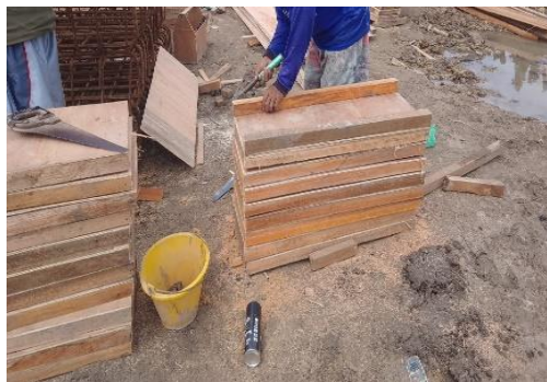
Gambar 3. 18 Pembuatan bekisting Sumber : Dokumentasi lapangan
