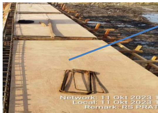
Gambar 3. 47 Pemasangan bekisting pelat lantai Sumber : Dokumentasi lapangan
