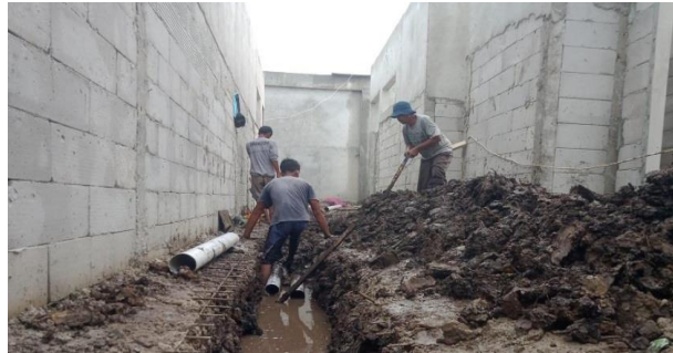
Gambar 3. 58 Pembobokan Untuk Jalur Pipa Air Kotor Sumber : Dokumentasi lapangan
