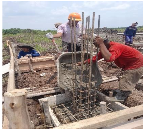
Gambar 3. 20 Pengecoran pile cap Sumber : Dokumentasi lapangan
