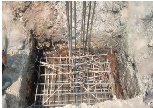
Gambar 3. 17 Pemasangan tulangan pile cap dan kolom pedestal Sumber : Dokumentasi lapangan
