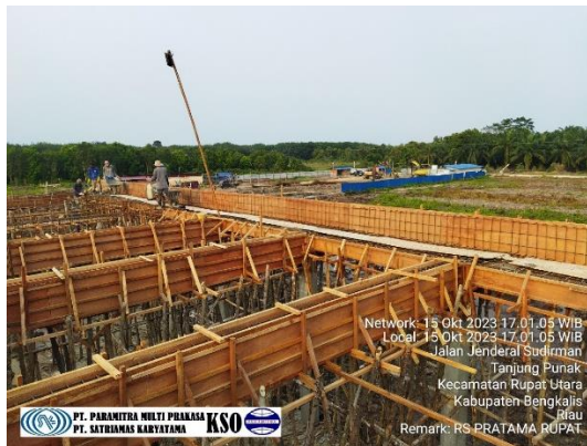
Gambar 3. 46 Pemasangan bekisting dan pengecoran balok Sumber : Dokumentasi lapangan
