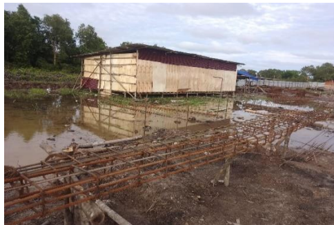
Gambar 3. 27 Proses penulangan sloof Sumber : Dokumentasi lapangan
