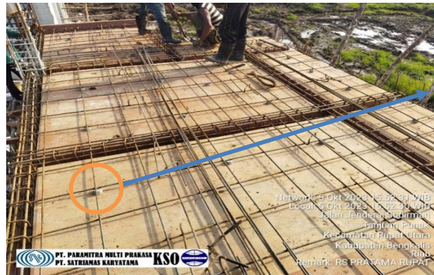
Gambar 3. 48 Pemasangan tulangan dan beton decking Sumber : Dokumentasi lapangan
