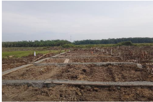
Gambar 3. 26 Penyemenan lantai tanah sloof Sumber : Dokumentasi lapangan
