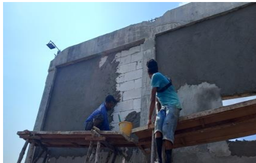
Gambar 3. 56 Pekerjaan plesteran dinding Sumber : Dokumentasi lapangan
