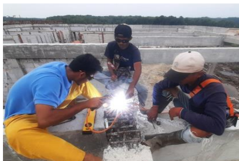
Gambar 3. 52 Proses pemasangan besi angkur Sumber : Dokumentasi lapangan
