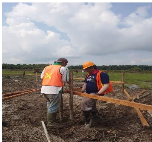
Gambar 3. 5 Pemasangan Bouwplank Sumber : Dokumentasi lapangan
