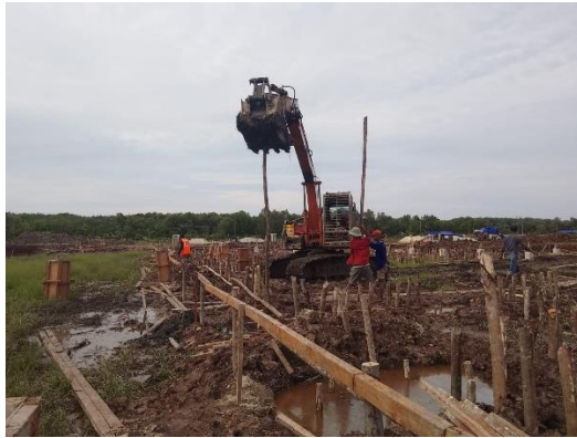
Gambar 3. 24 Pemasangan kayu cerocok Sumber : Dokumentasi lapangan
