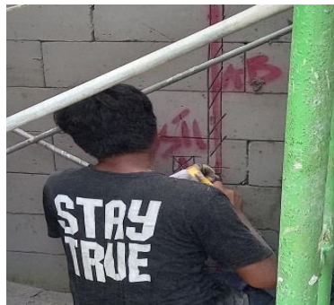
Gambar 3. 60 Pekerjaan pembobokan dinding Sumber : Dokumentasi lapangan
