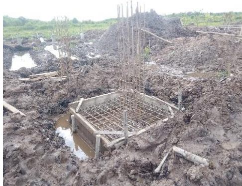
Gambar 3. 19 Pemasangan bekisting pile cap Sumber : Dokumentasi lapangan
