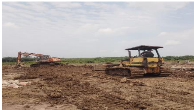
Gambar 3. 3 Membuat akses jalan Sumber : Dokumentasi lapangan
