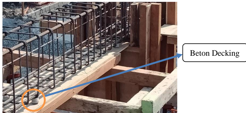
Gambar 3. 45 Pemasangan beton decking Sumber : Dokumentasi lapangan
