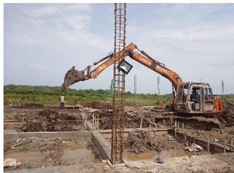
Gambar 3. 32 Proses pengurukan tanah Sumber : Dokumentasi lapangan
