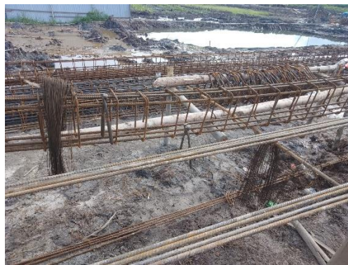
Gambar 3. 16 Penulangan kolom pedestal Sumber : Dokumentasi lapangan
