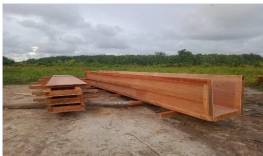
Gambar 3. 41 Pemasangan bekisting Sumber : Dokumentasi lapangan
