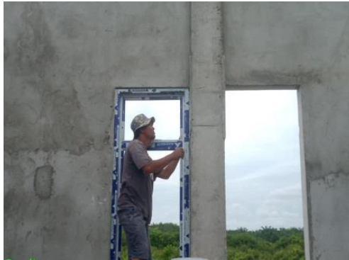
Gambar 3. 55 Pekerjaan Kusen Jendela & pintu Sumber : Dokumentasi lapangan
