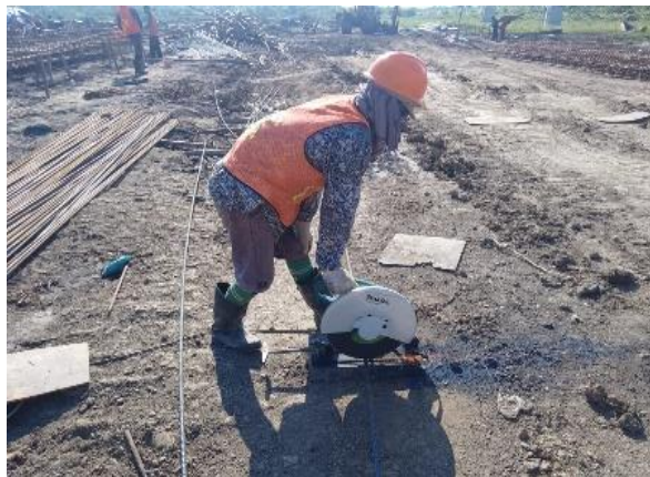
Gambar 3. 6 Pemotongan besi tulangan utama Sumber : Dokumentasi lapangan
