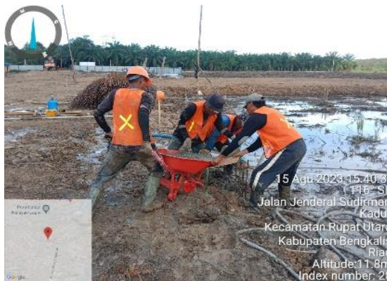
Gambar 3. 11 Proses pengecoran strauss pile Sumber : Dokumentasi lapangan
