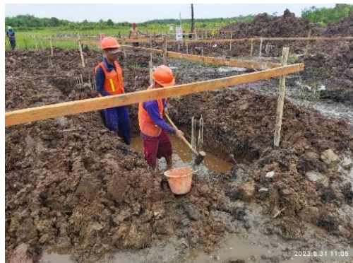
Gambar 3. 14 Pekerjaan pembobokan kepala beton Sumber : Dokumentasi lapangan
