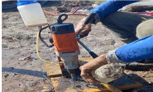
Gambar 3. 53 Pengeboran lubang sambungan baut Sumber : Dokumentasi lapangan
