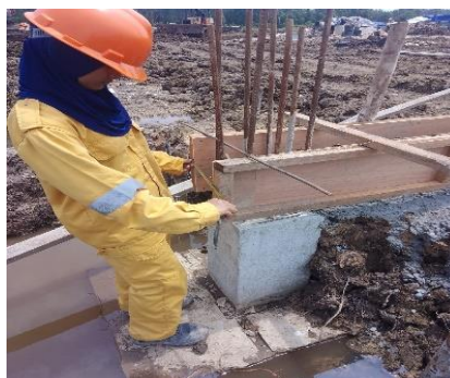
Gambar 3. 30 Mengukur bekisting sloof Sumber : Dokumentasi lapangan
