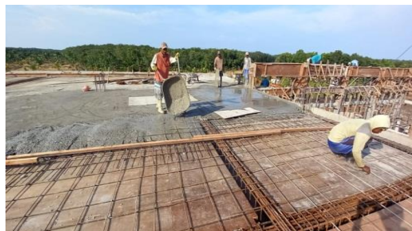
Gambar 3. 49 Pengecoran pelat lantai Sumber : Dokumentasi lapangan
