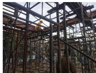
Gambar 3. 27 Instal Bekisting Balok (Sumber : Dokumentasi Perusahaan, 2023)
