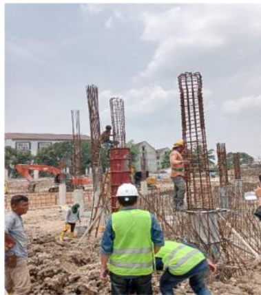
Gambar 3. 24 Penggetaran Beton Menggunakan Vibrator Beton (Sumber : Dokumentasi Perusahaan, 2023)
