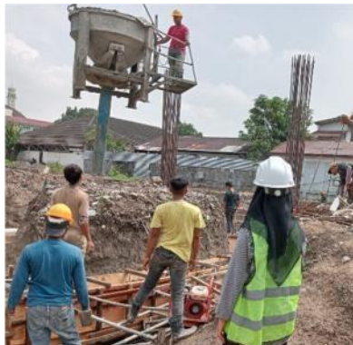
Gambar 3. 15 Pengecoran Sloof (Sumber : Dokumentasi Lapangan, 2023)
