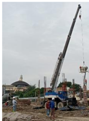
Gambar 3. 25 Pengecoran Lanjutan Kolom (Sumber : Dokumentasi Perusahaan, 2023)
