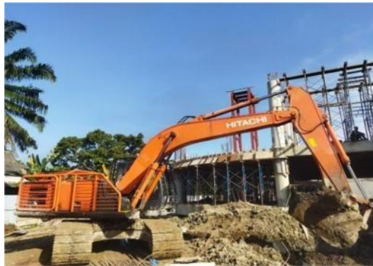
Gambar 3. 1 Pekerjaan Galian (Sumber : Dokumentasi Lapangan, 2023)
