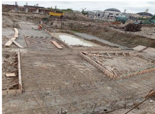
Gambar 3. 4 Instal Tulangan Dan bekisting Tapak (Sumber : Dokumentasi Lapangan, 2023)
