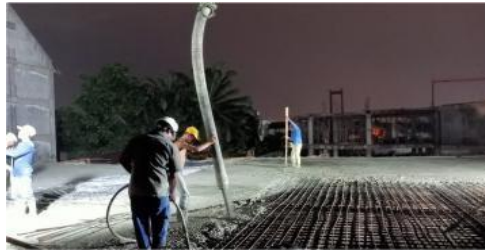
Gambar 3. 31 Penggetaran Beton Menggunakan Vibrator (Sumber : Dokumentasi Perusahaan, 2023)
