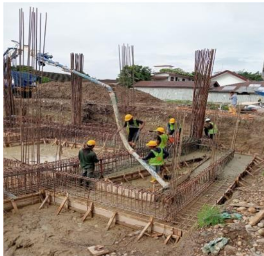
Gambar 3. 8 Pengecoran Tapak (Sumber : Dokumentasi Lapangan, 2023)
