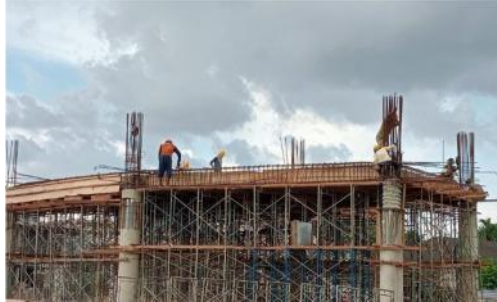
Gambar 3. 28 Instal Besi Dan Plat Lantai 2 (Sumber : Dokumentasi Perusahaan, 2023)
