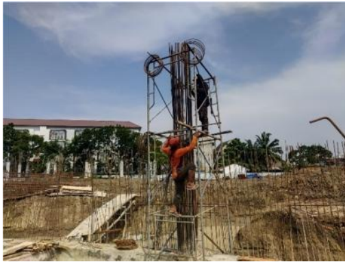
Gambar 3. 19 Instal Tulangan Kolom (Sumber : Dokumentasi Perusahaan, 2023)
