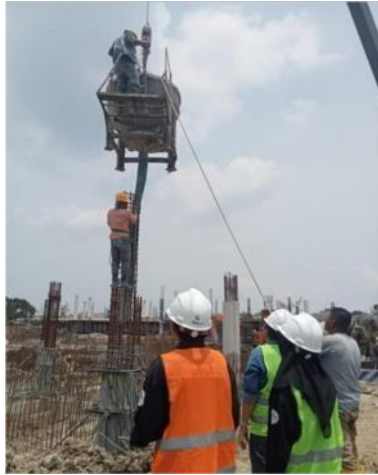
Gambar 3. 23 Pengecoran Kolom (Sumber : Dokumentasi Perusahaan, 2023)
