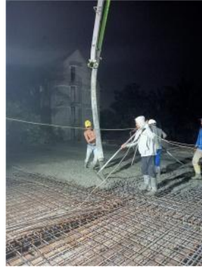
Gambar 3. 30 Pengecoran balok dan plat lantai 2 (Sumber : Dokumentasi Perusahaan, 2023)
