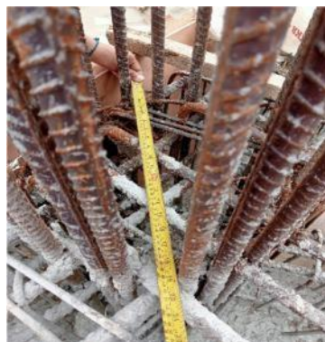
Gambar 3. 20 Pengecekan Tulangan Kolom (Sumber : Dokumentasi Perusahaan, 2023)
