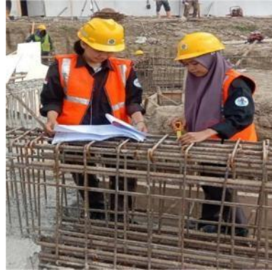
Gambar 3. 12 Pengecekan Tulangan Sloof (Sumber : Dokumentasi Lapangan, 2023)
