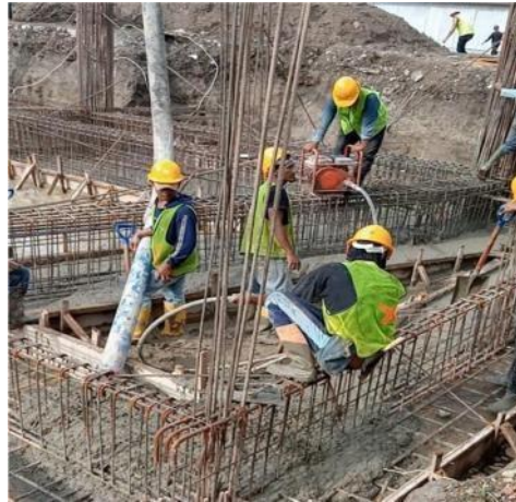
Gambar 3. 9 Penggetaran Beton Menggunakan Vibrator (Sumber : Dokumentasi Lapangan, 2023)
