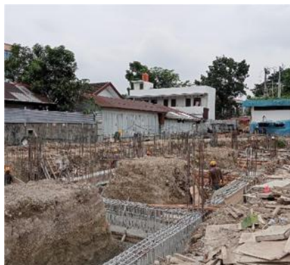
Gambar 3. 11 Instal Tulangan dan Bekisting Sloof (Sumber : Dokumentasi Lapangan, 2023)
