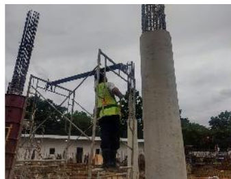
Gambar 3. 26 Instal Scaffolding (Sumber : Dokumentasi Perusahaan, 2023)
