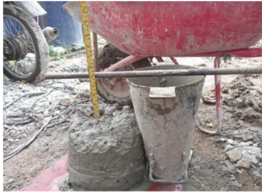
Gambar 3. 7 Pengujian Slump (Sumber : Dokumentasi Lapangan, 2023)
