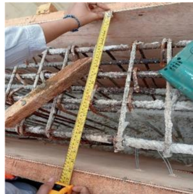
Gambar 3. 13 Pengecekan Bekisting Sloof (Sumber : Dokumentasi Lapangan, 2023)
