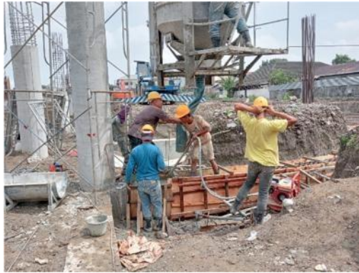
Gambar 3. 16 Penggetaran Beton Menggunakan Vibrator (Sumber : Dokumentasi Lapangan, 2023)
