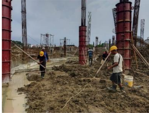
Gambar 3. 21 Instal Kolom (Sumber : Dokumentasi Perusahaan, 2023)
