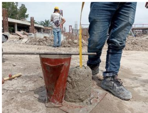
Gambar 3. 22 Pengujian Slump (Sumber : Dokumentasi Perusahaan, 2023)
