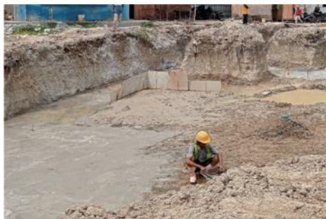
Gambar 3. 2 Pekerjaan Lantai Kerja (Sumber : Dokumentasi Lapangan, 2023)
