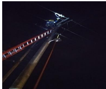
Gambar.2.39. Penyambungan SUTM (Sumber PT.Haleyora Power,2023)
