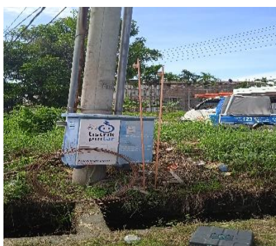
Gambar.2.18. Melakukan pemasangan gronding (Sumber PT.Haleyora Power,2023)
