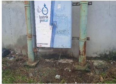
Gambar.2.17.Membersihkan rumput-rumput pada lesbor
