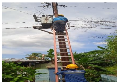
Gambar.2.45.Memperbaiki SKTR terbakar (Sumber PT.Haleyora Power,2023)
