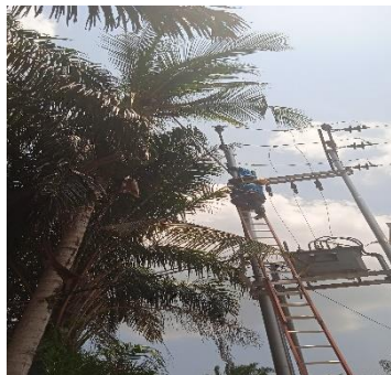
Gambar.2.52. Pemangkasan (Sumber PT.Haleyora Power,2023)
