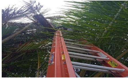
Gambar.2.22. Penyambungan kabel kabel SR (Sumber PT.Haleyora Power,2023)
