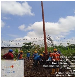
Gambar.2.20. menegakkan tiang yang tumbang (Sumber PT.Haleyora Power,2023)
