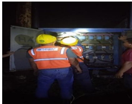
Gambar.2.48. Memoerbaiki pin copper yang (Sumber PT.Haleyora Power,2023)
