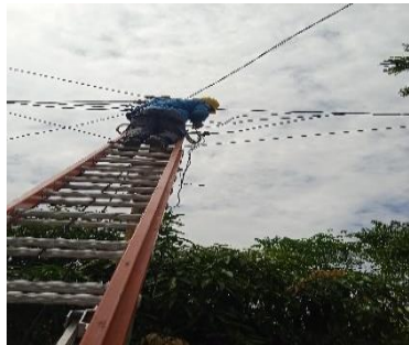
Gambar.2.14. meyambung kabel yang putus. (Sumber PT.Haleyora Power,2023)
