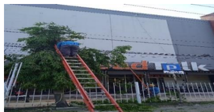
Gambar.2.3 Pemangkasan jaringan tegangan menengah (Sumber PT.Haleyora Power,2023)
