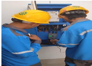
Gambar.2.10. pemeriksaan instalasi masjid (Sumber PT.Haleyora Power,2023)
