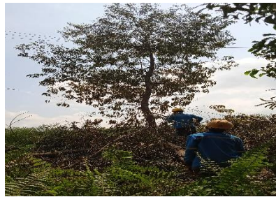
Gambar.2.12. Pemangkasan (Sumber PT.Haleyora Power,2023)
