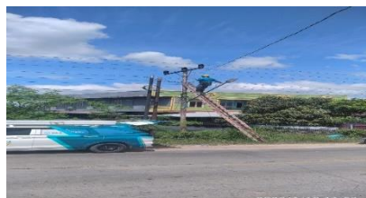
Gambar.2.9.Memperbaiki kabel jatuh (Sumber PT.Haleyora Power,2023)
