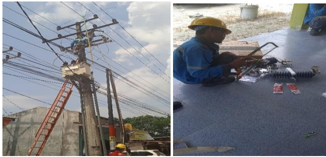
Gambar.2.51. Pemasangan FCO (Sumber PT.Haleyora Power,2023)
