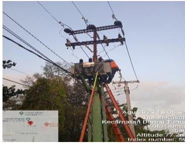
Gambar.2.38. Penyambungan SKTR (Sumber PT.Haleyora Power,2023)
