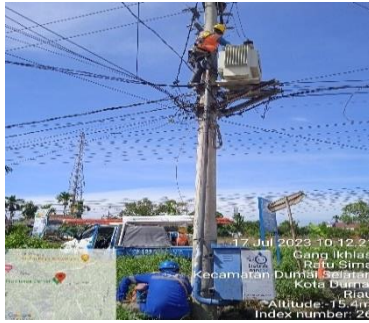
Gambar.2.28. Pemasangan gronding LA (Sumber PT.Haleyora Power,2023)
