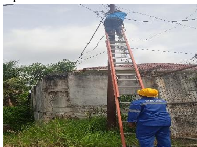
Gambar.2.6.meyambung kabel yang putus.
