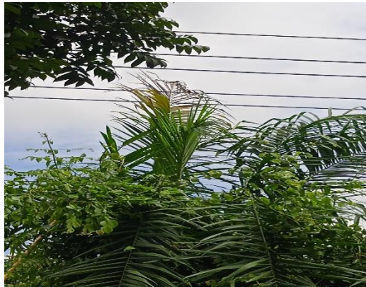
Gambar 3.1 Ranting pohon menyentuh JTM (Sumber PT.Haleyora Power,2023)
