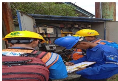
Gambar.2.36. Pengecekan alat di dalm lesbor (Sumber PT.Haleyora Power,2023)
