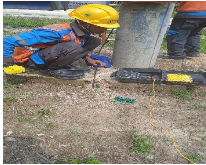
Gambar.2.53. Pemasangan gronding (Sumber PT.Haleyora Power,2023)
