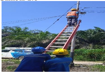
Gambar.2.8.Memperbaiki kabel yang bocor (Sumber PT.Haleyora Power,2023)
