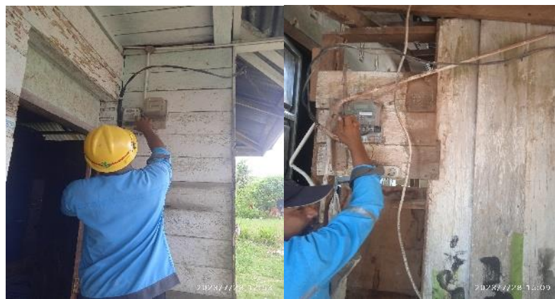
Gambar 2. 35 Memasukkan No CT Pada KWH
