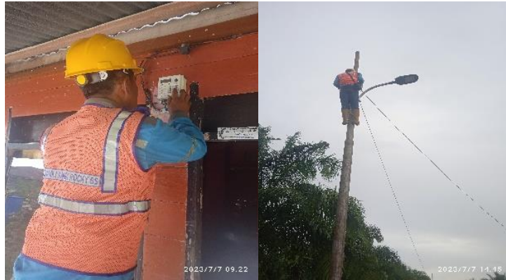
Gambar 2. 22 Penggantian KWH Meter
