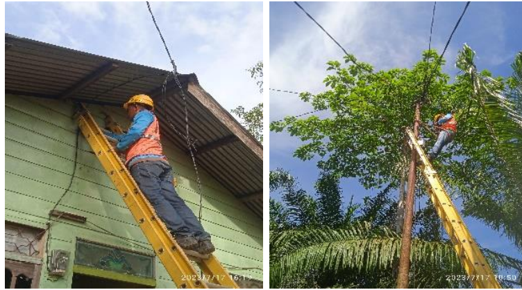
Gambar 2. 28 Memperbaiki Kabel SR
