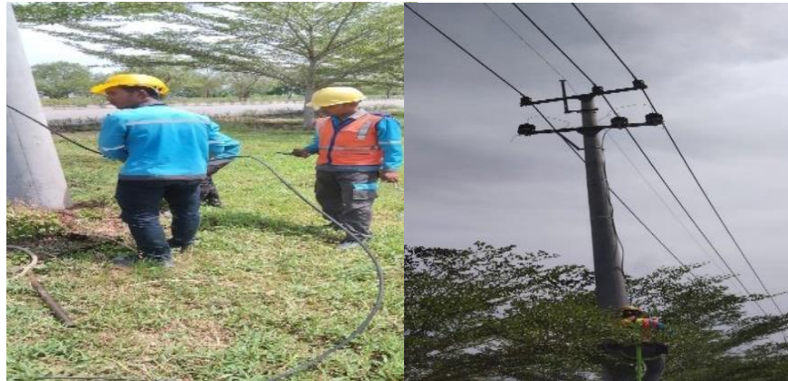
Gambar 2. 1 Pemasangan Grounding arrester (Sumber:PT.PLN ULP Bagan Siapi-Api 2023)
