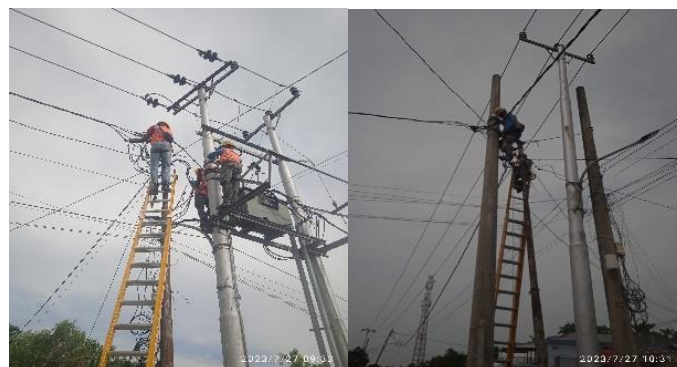
Gambar 2. 34 Pemeliharaan JTR Sumber:PT.PLN ULP Bagan Siapi-Api 2023
