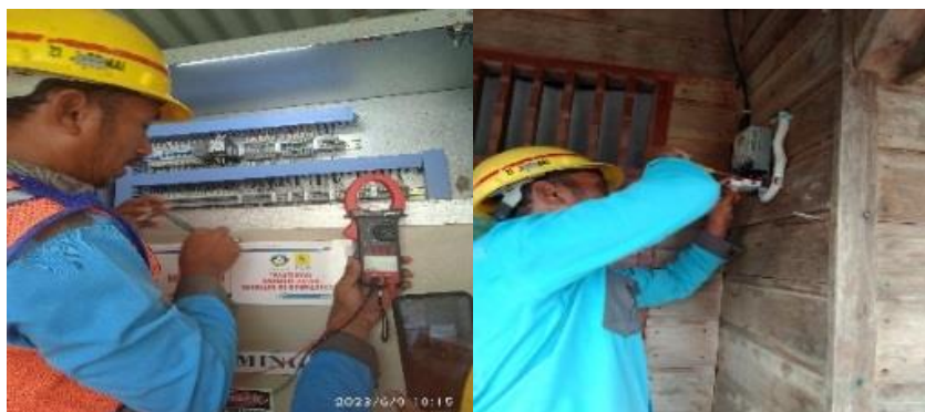
Gambar 2. 4 Memperbaiki KWH Meter
