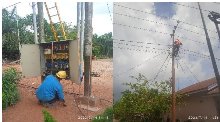
Gambar 2. 27 Pemeliharaan PHBTR
