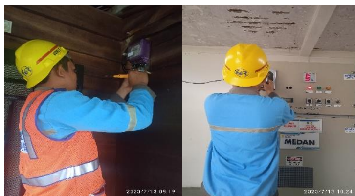
Gambar 2. 26 Penggantian KWH meter
