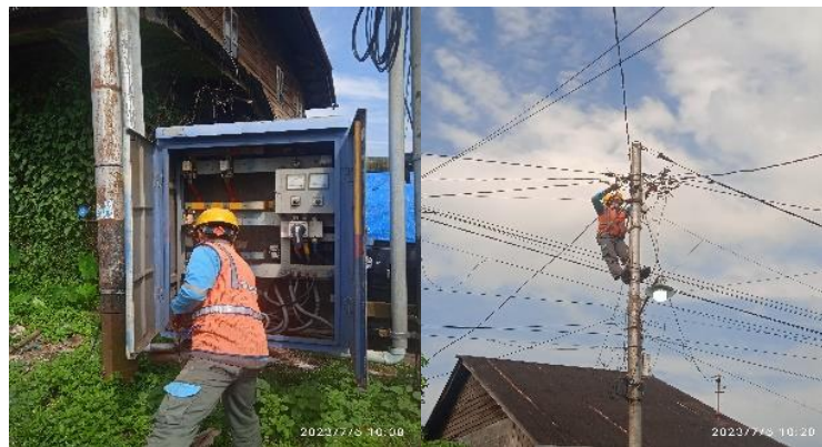
Gambar 2. 21 Penyeimbangan Beban Trafo
