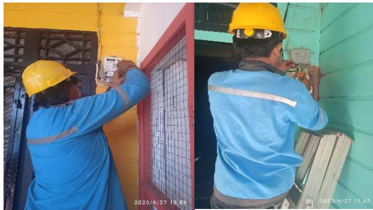
Gambar 2. 16 Penggantian KWH Meter
