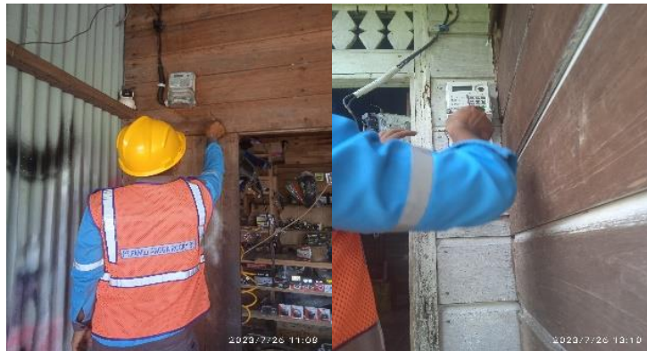
Gambar 2. 33 Penggantian KWH Meter Sumber:PT.PLN ULP Bagan Siapi-Api 2023
