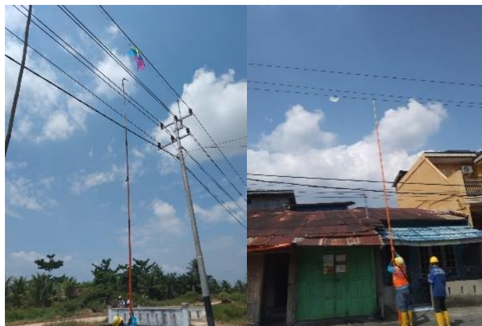
Gambar 2. 37 Pemeliharaan JTM
