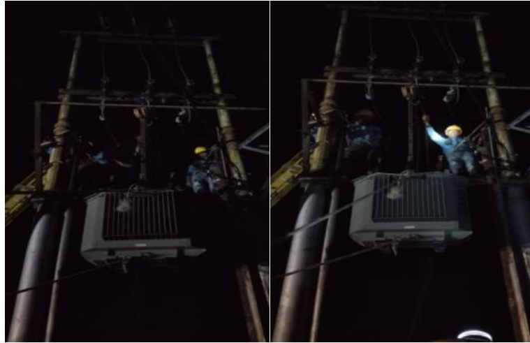
Gambar 2. 48 Penggantian trafo baru
