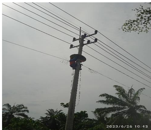
Gambar 2. 15 Pemeliharaan JTM
