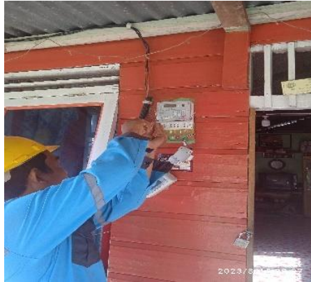
Gambar 2. 45 Penggantian KWH Meter
