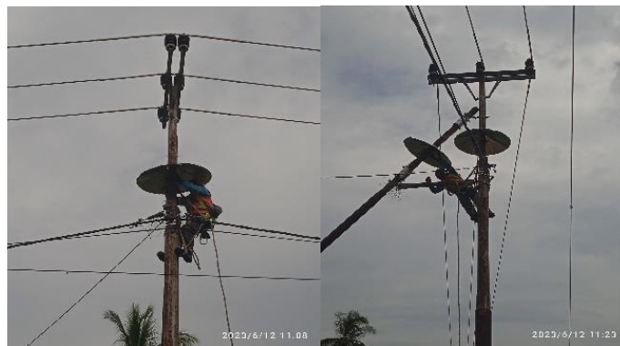
Gambar 2. 5 Pemeliharaan JTM
