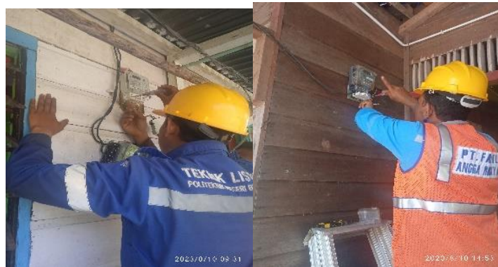
Gambar 2. 43 Penggantian KWH meter
