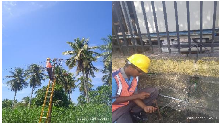
Gambar 2. 31 Pemeliharaan JTR dan PHBTR
