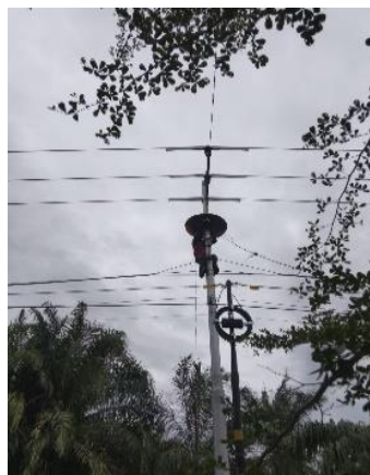
Gambar 2. 49 Pemasangan Payung Seng
