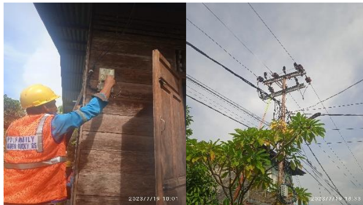
Gambar 2. 30 Penggantian KWH Meter dan FCO
