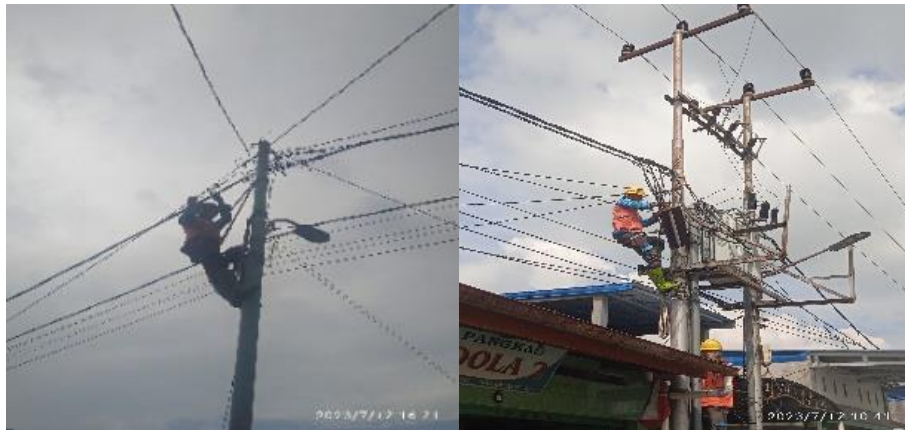
Gambar 2. 25 Perbaikan Kabel SR dan FCO
