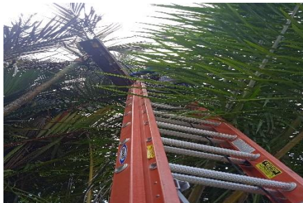
Gambar 2. 22 Penyambungan kabel kabel SR
