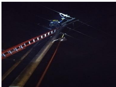
Gambar 2. 39 Penyambungan SUTM
