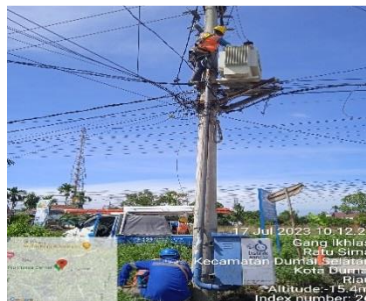
Gambar 2. 28 Pemasangan gronding LA
