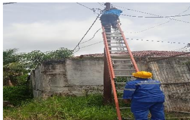
Gambar 2. 6 meyambung kabel yang putus
