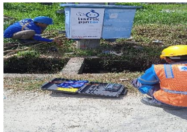
Gambar 2. 19 Pengukuran tegangan grounding
