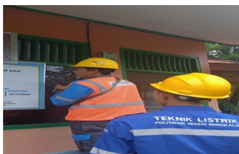
Gambar 2. 5 Gangguan kwa pada rumah pelanggan
