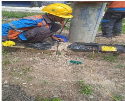
Gambar 2. 53 Pemasangan gronding
