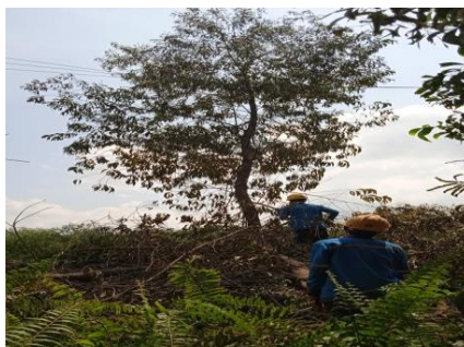
Gambar 2. 3 Pemangkasan jaringan tegangan menengah
