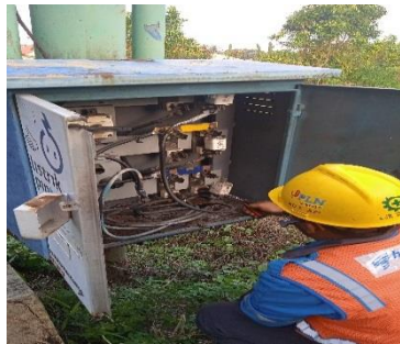
Gambar 2. 26 Memasang NH fuse
