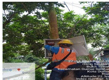
Gambar 2. 35 Pengecekan Gronding LA
