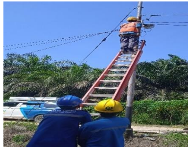
Gambar 2. 8 Memperbaiki kabel yang bocor
