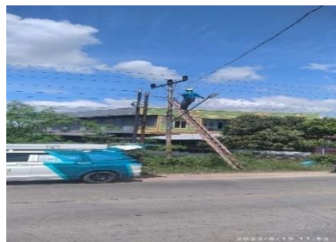
Gambar 2. 9 Memperbaiki kabel jatuh
