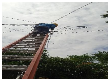
Gambar 2. 14 Menyambung kabel yang putus
