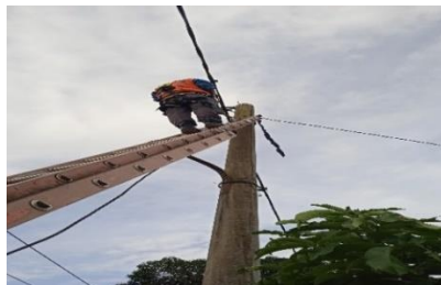
Gambar 2. 30 Kabel SR jatuh
