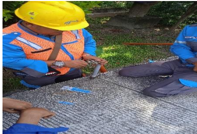
Gambar 2. 43 Pengantian fuse link
