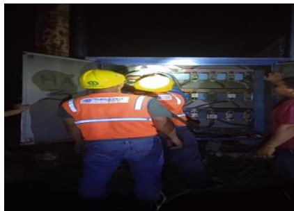
Gambar 2. 48 Memperbaiki pin copper
