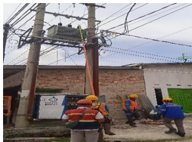
Gambar 2. 11 Pemasangan grounding trafo
