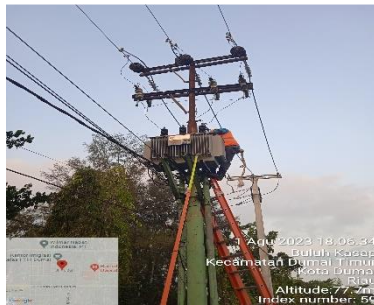
Gambar 2. 38 Penyambungan SKTR
