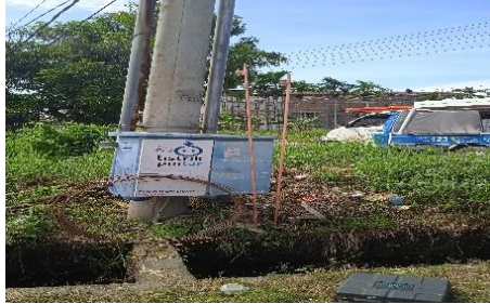
Gambar 2. 18 Melakukan pemasangan gronding
