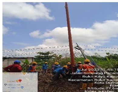
Gambar 2. 20 Menegakkan tiang yang tumbang
