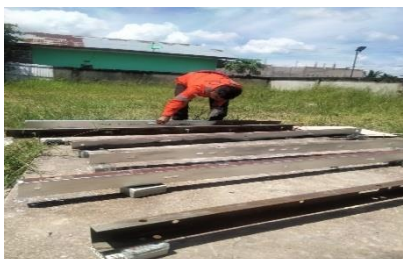
Gambar 2. 7 Memperbaiki teraves.
